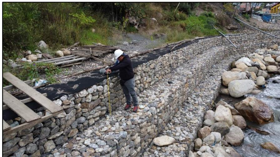
**Figura 16:** Verificando la altura de cada hilada del muro de gaviones
