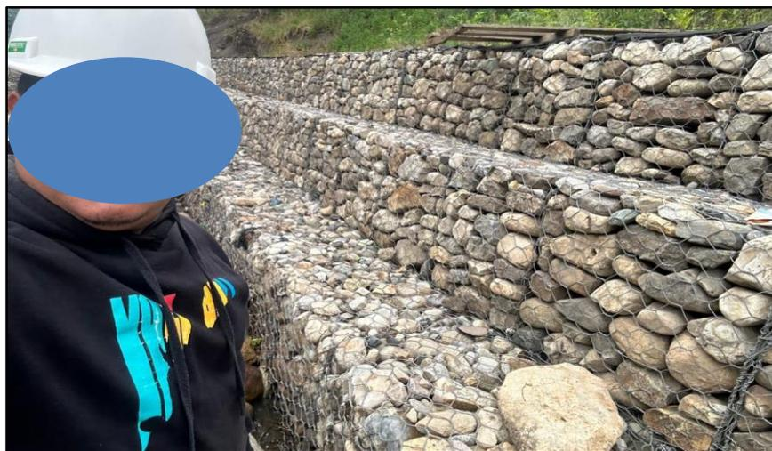
**Figura 17:** Tramo del muro de gaviones a evaluar
