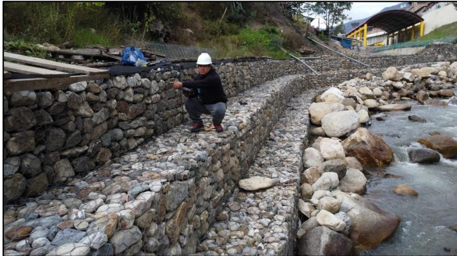
**Figura 15:** Realizando la evaluación del muro de gaviones
