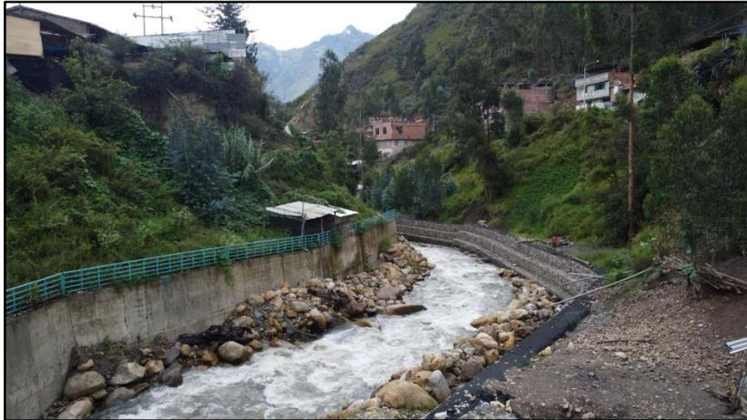
**Figura 12:** Vista general del muro de gaviones
