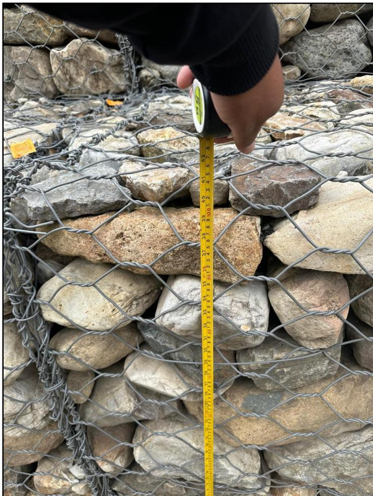
**Figura 18:** Verificando la altura de la hilada
