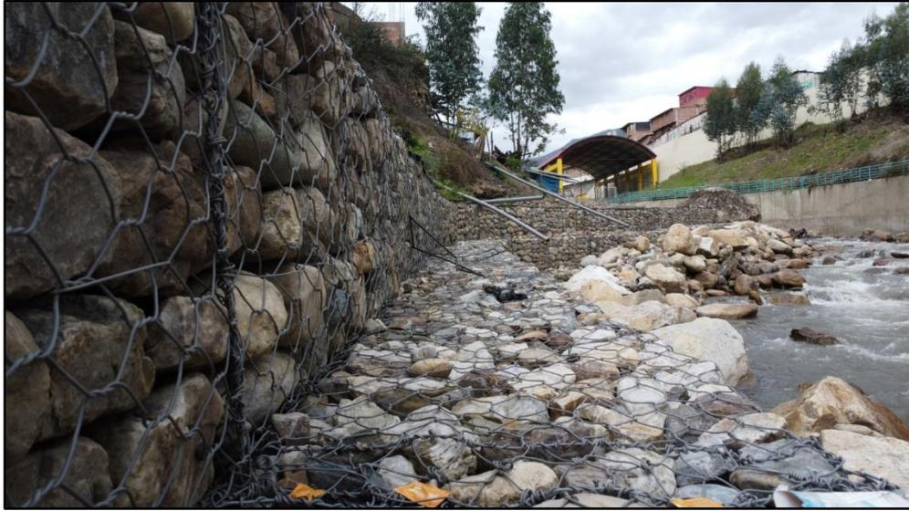
**Figura 20:** Vista cercana del muro de gaviones
