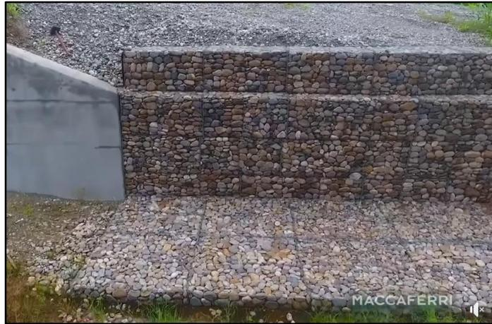
**Figura 4:** Muestra de los Gaviones con suelo reforzado. Fue extraído del libro de Amórtegui et al (15).
