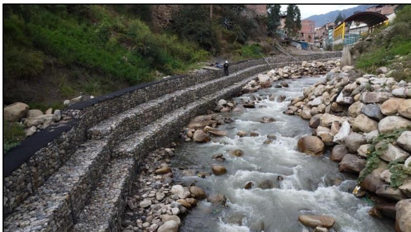
**Figura 14:** Tramo del muro de gaviones a evaluar
