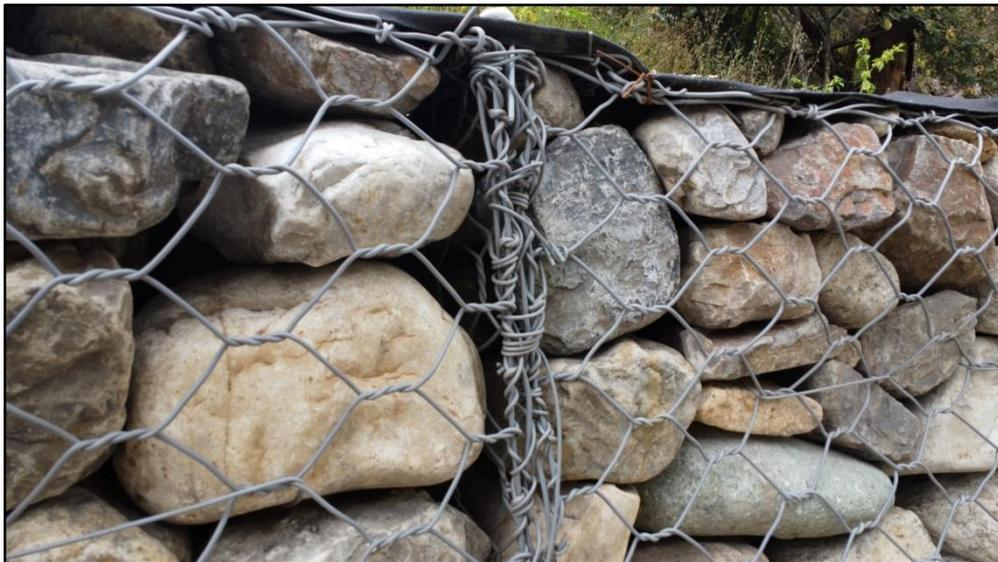
**Figura 21:** Malla empleada en el muro de gaviones
