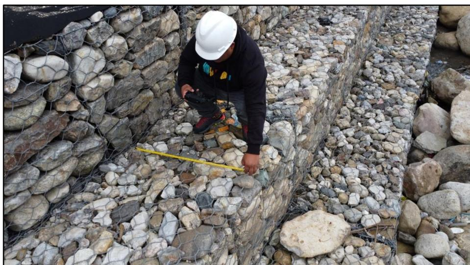
**Figura 19:** Verificando el ancho de la hilada
