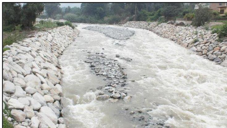
**Figura 11:** Muestra del enrocado que protege de los daños del escurrimiento del agua y ondas de un río o mar. Fue extraído del libro de Villón (16).
