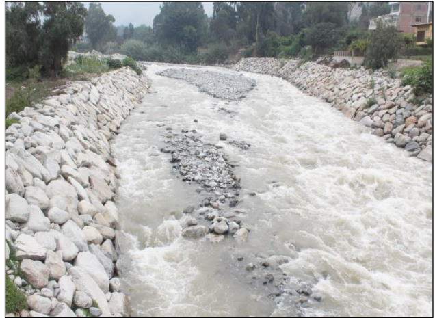
Figura 5: Enrocado para defensa ribereña
