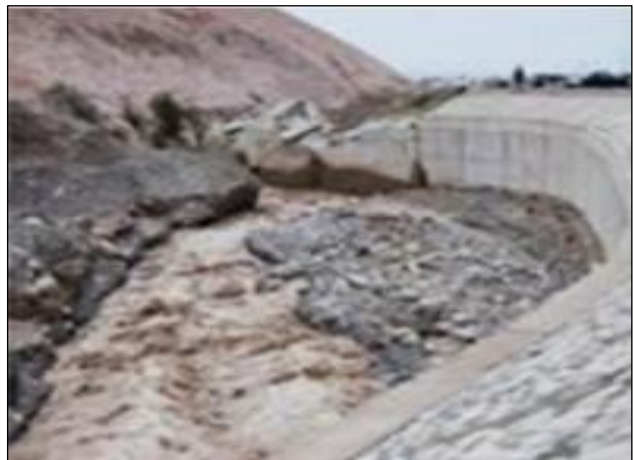
Figura 6: Muro de concreto para defensa ribereña
