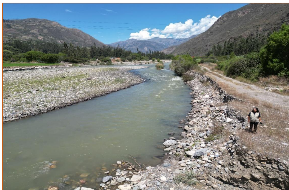
Figura 9: Deformación de enrocado y erosión de las progresivas 264+100 al km 264+200.
