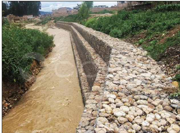
Figura 4: Gaviones de defensa ribereña
