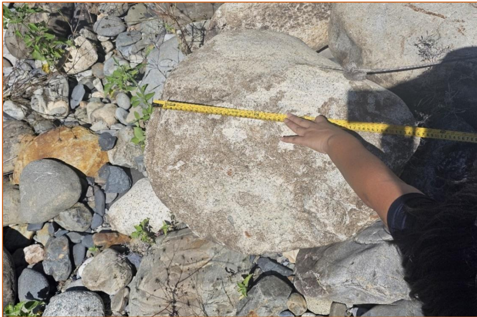
Figura 11: Medición de tamaño de rocas en enrocado
