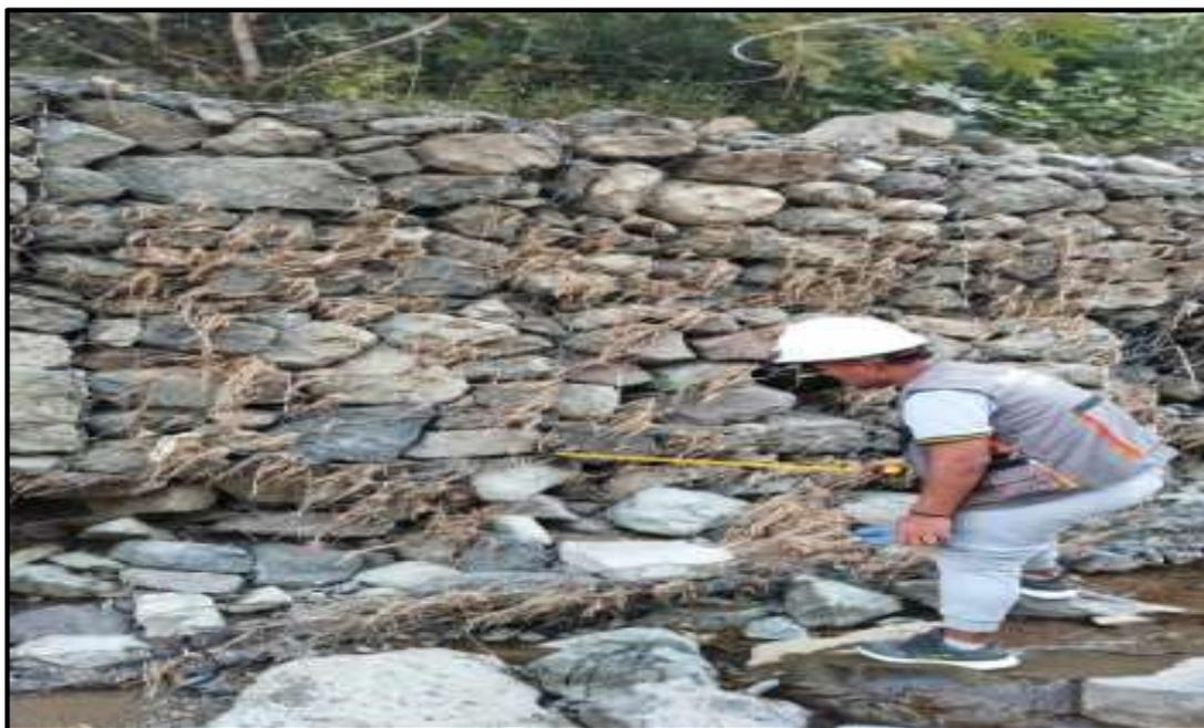
**Figura 17:** Medición del ancho del gavión del primer nivel.
