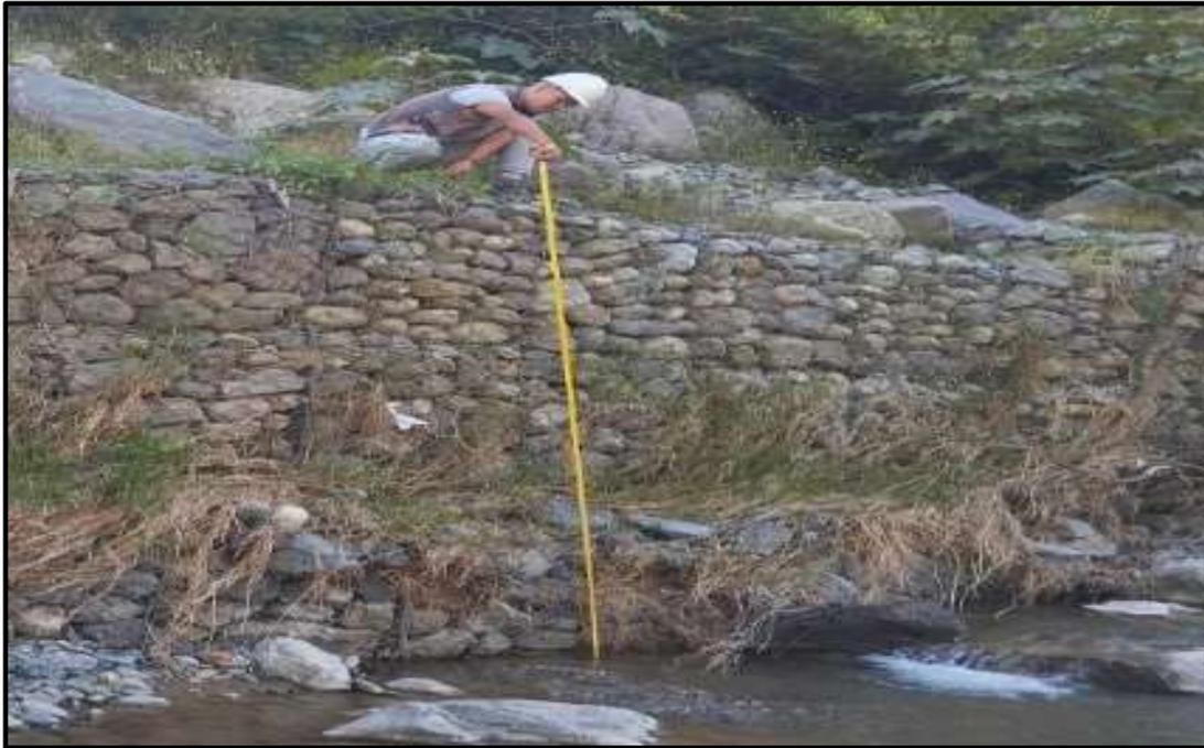
**Figura 13:** Medición de la altura del muro de gavión .
