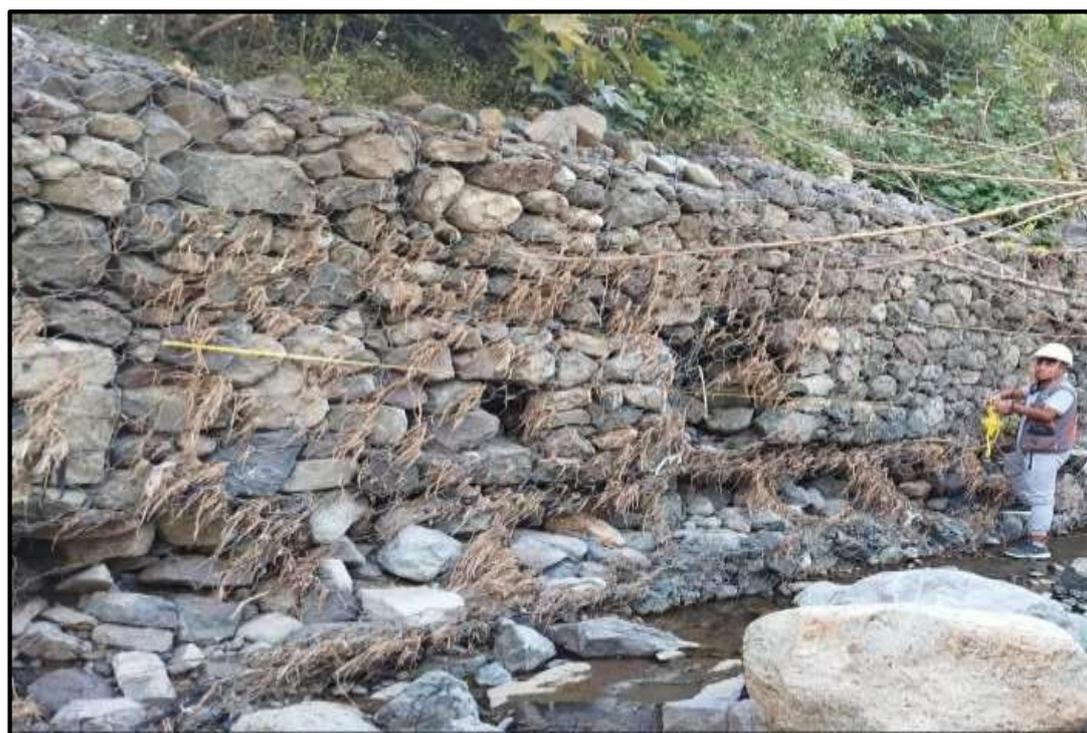
**Figura 18:** Medición de los tramos afectados por roturas de mallas y socavación.
