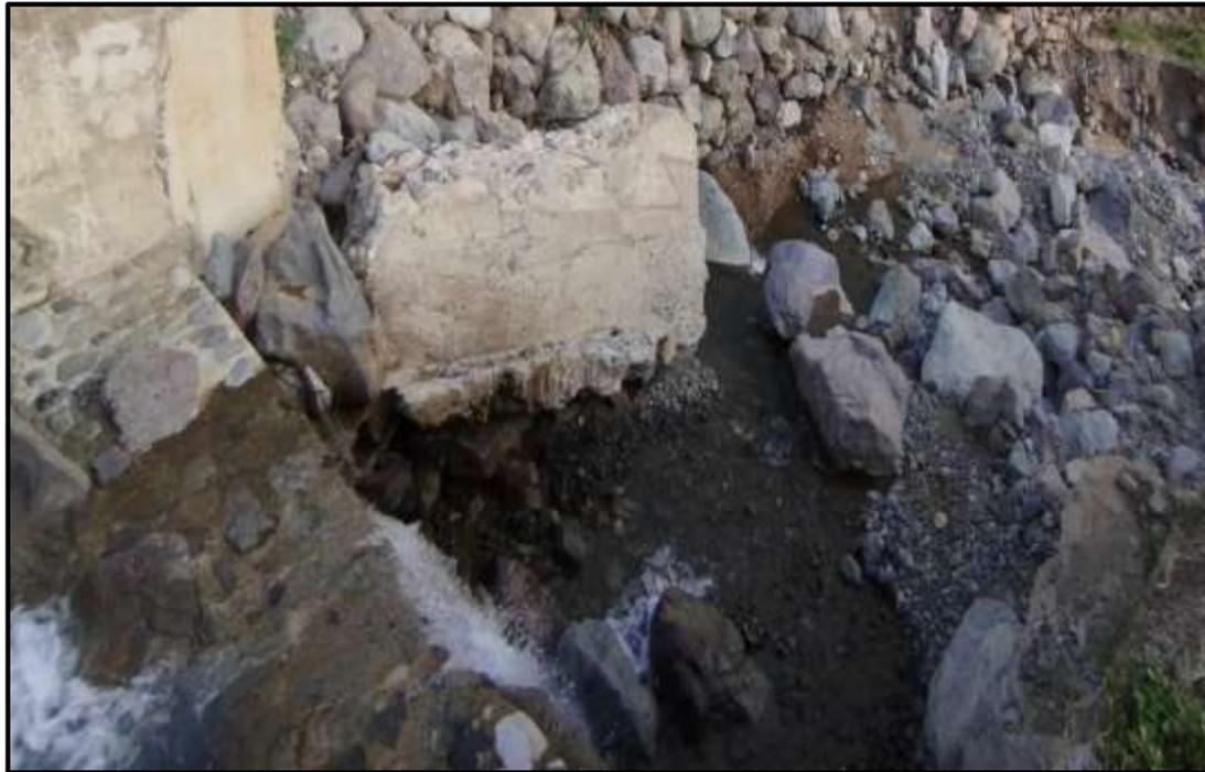
**Figura 22:** Estructura rota por causa de los huaycos.
