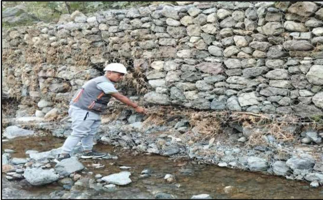
**Figura 19:** Mallas rotas y socavamiento del primer nivel del muro de gavion.
