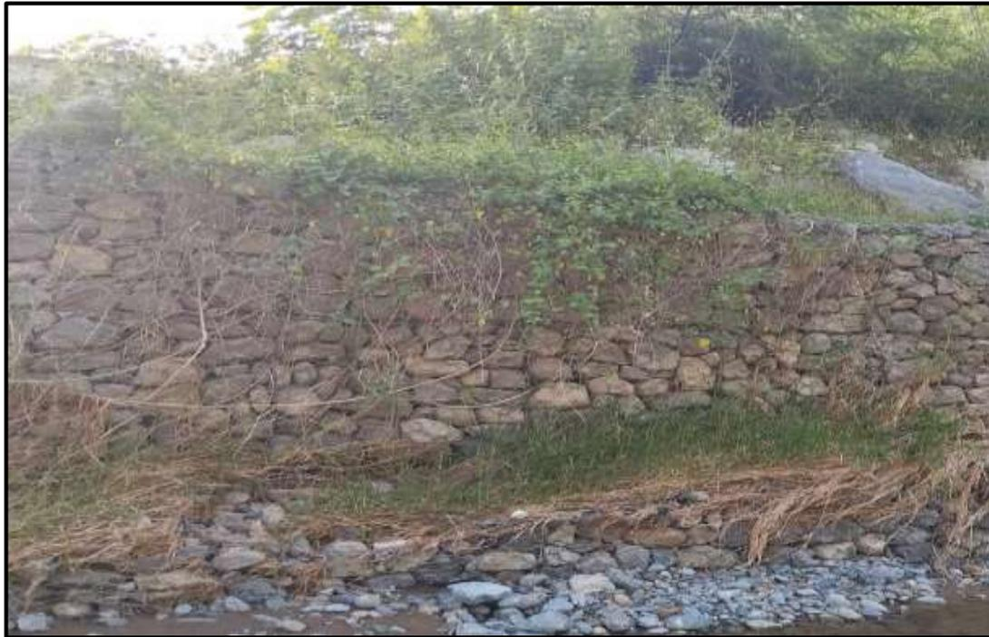
**Figura 12:** Vegetación cubriendo completamente al muro de gavión.
