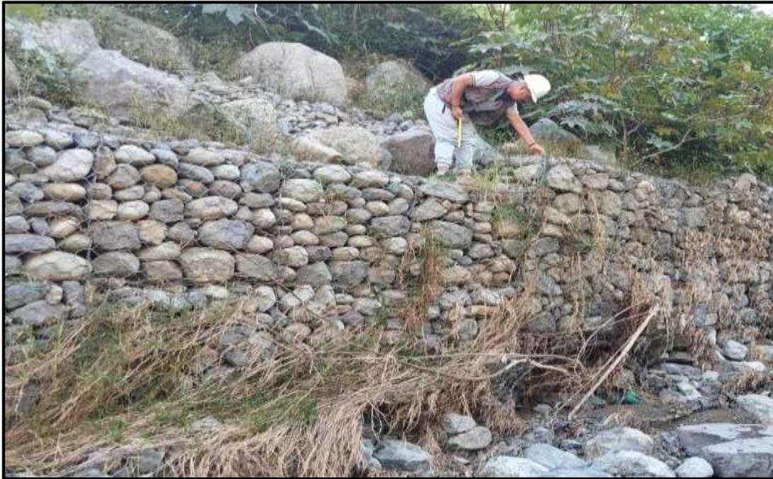
**Figura 11:** Muro de gavión con socavación.
