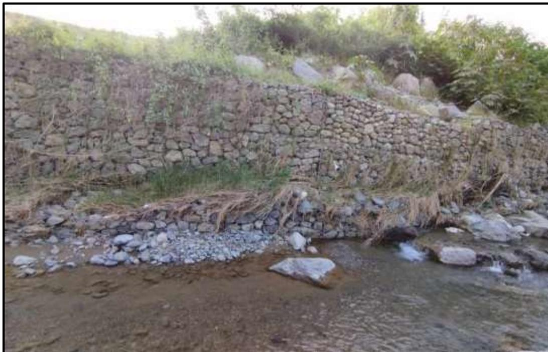
**Figura 10:** Muro de gavión cubierto con vegetación y socavamiento.
