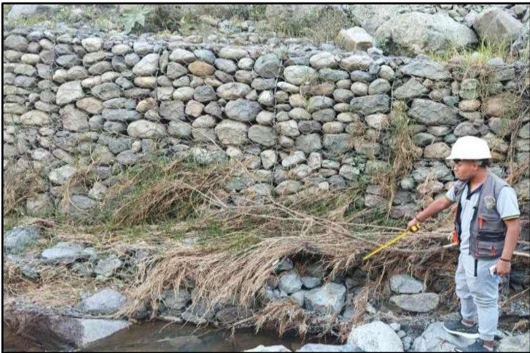
**Figura 16:** Socavamiento del uro de gavión recubierto de vegetación seca.
