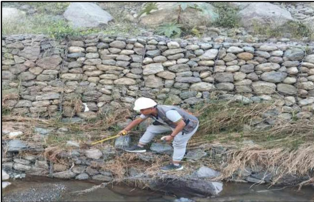
**Figura 14:** Roturas de mallas por completo en el primer nivel del muro de gavión.
