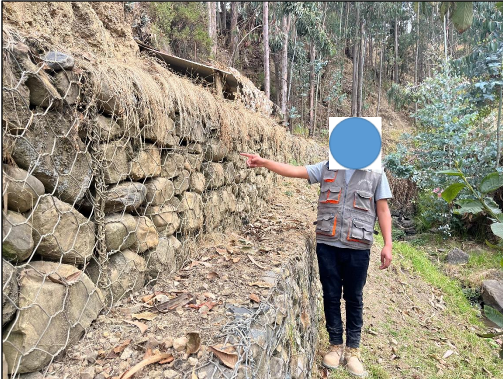
Figura 17: Evaluación estructural del muro de gabi6n del tercer nivel del r6o Chaupirgra, progresiva 700+800
