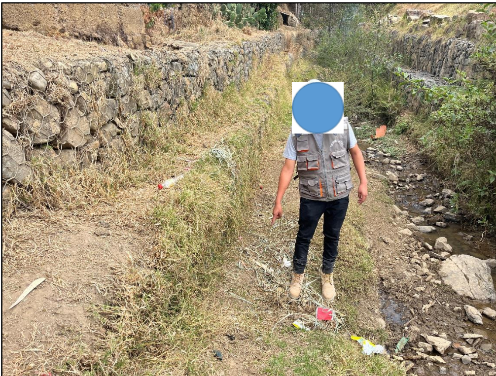
Figura 6: Evaluación estructural del muro de gaviones del río Chaupiragra primer nivel, progresiva 200+300
