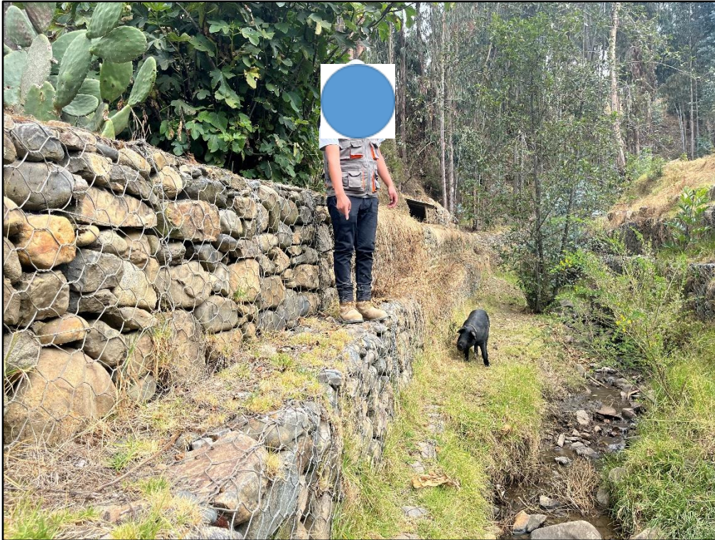
Figura 13: Evaluación estructural del muro de gabi6n del r6o Chaupiragra, segundo nivel progresiva 600+700
