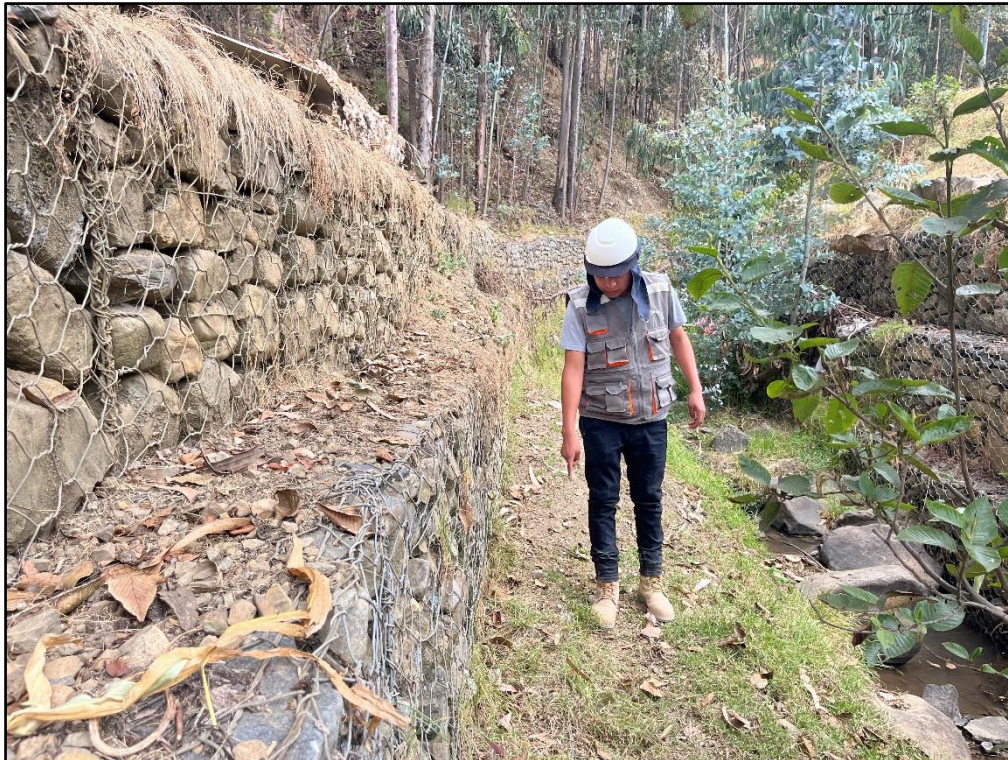
Figura 15: Evaluación estructural del muro de gavión del río Chaupiragra, primer nivel progresiva 700+800
