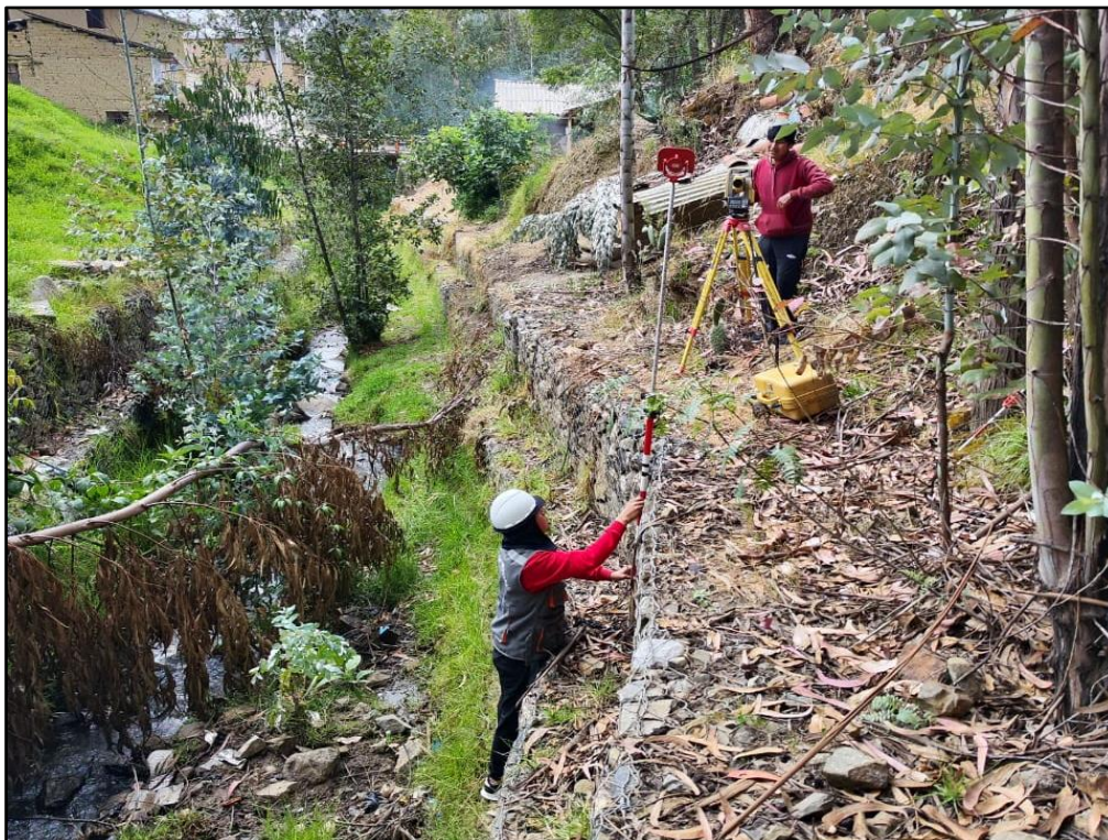
Figura 22: Realizando el levantamiento topográfico de los niveles del muro de gavión del río Chaupirgra
