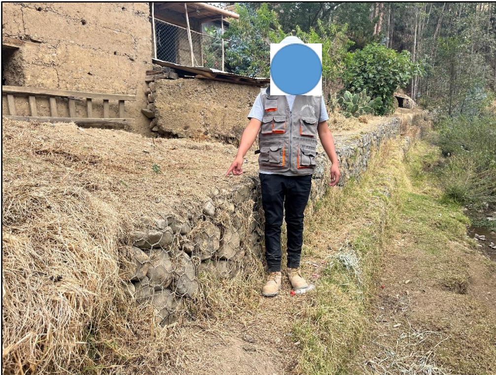
Figura 8: Evaluación estructural del muro de gaviones del río Chaupiragra tercer nivel, progresiva 200+300
