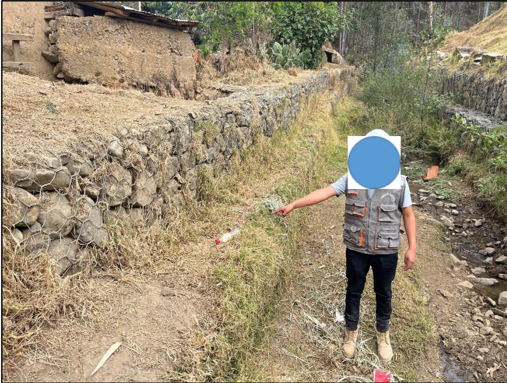
Figura 7: Evaluación estructural del muro de gaviones del río Chaupiragra segundo nivel, progresiva 200+300
