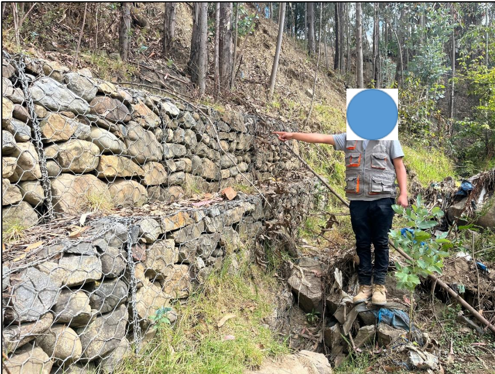
Figura 20: Evaluación estructural del muro de gavión del río Chaupiragra tercer nivel, progresiva 900+1000
