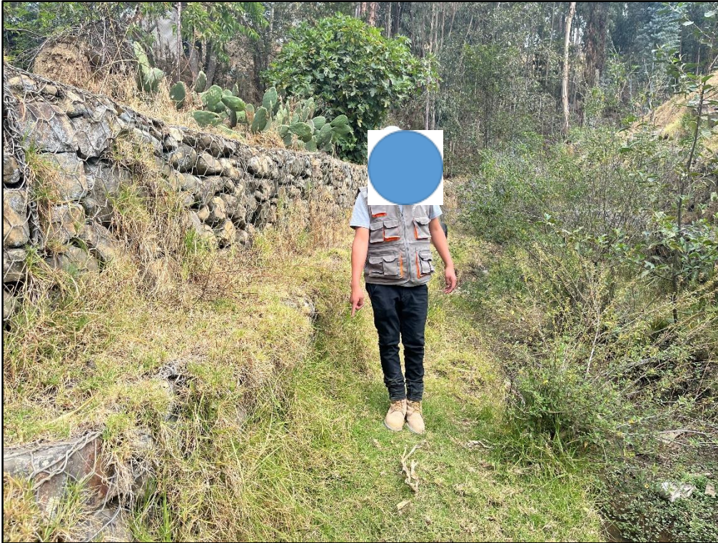
Figura 9: Evaluación estructural del muro de gavione del río Chaupiragra, primer nivel progresiva 500+600
