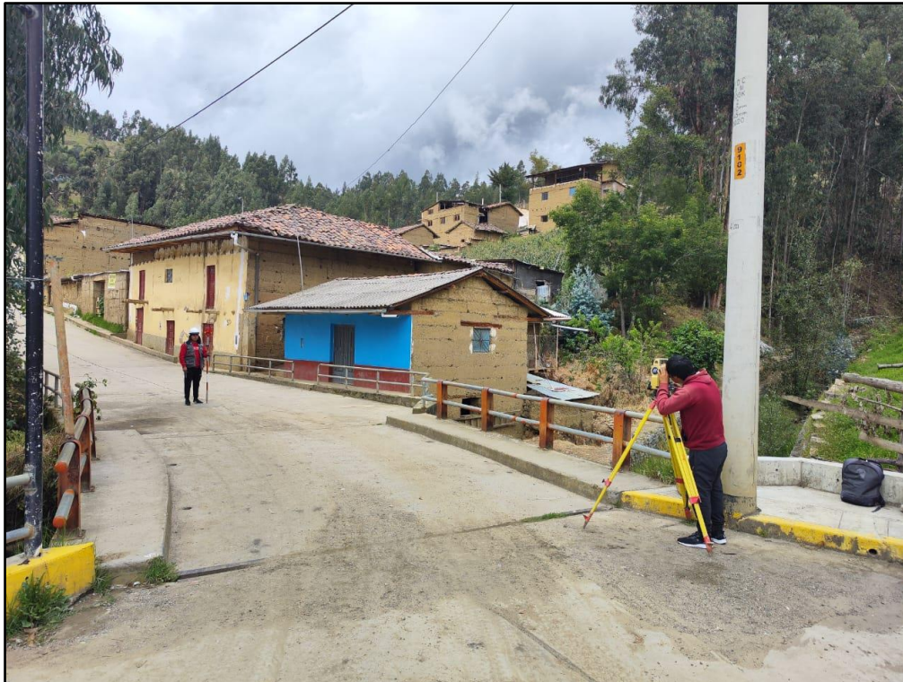
Figura 21: Realizando el levantamiento topográfico del muro de gavión del río Chaupirgra
