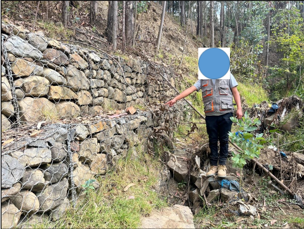
Figura 19: Evaluación estructural del muro de gavión del río Chaupiragra, segundo nivel, progresiva 900+1000
