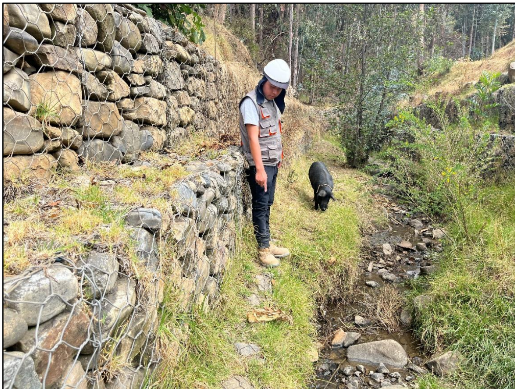
Figura 12: Evaluación estructural del muro de gavión del río Chaupiragra, primer nivel progresiva 600+700
