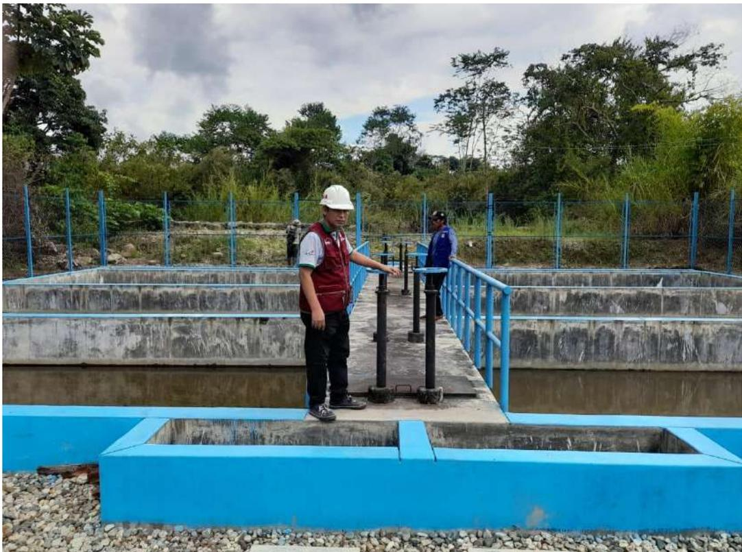
Figura 24: Se observa las válvulas instaladas en dicho Prefiltro - Filtro Lento en todo el tramo.
