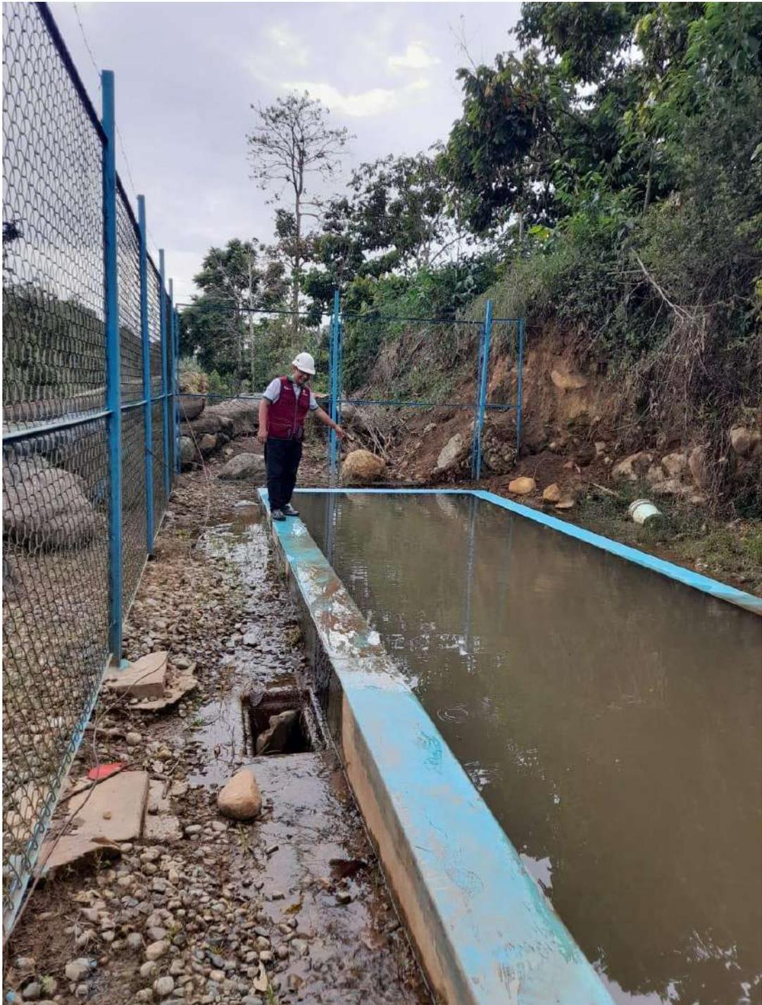
Figura 19: Se observa el desarenador, ubicado en el Km. 0+038 en la cota 957.28 msnm.
