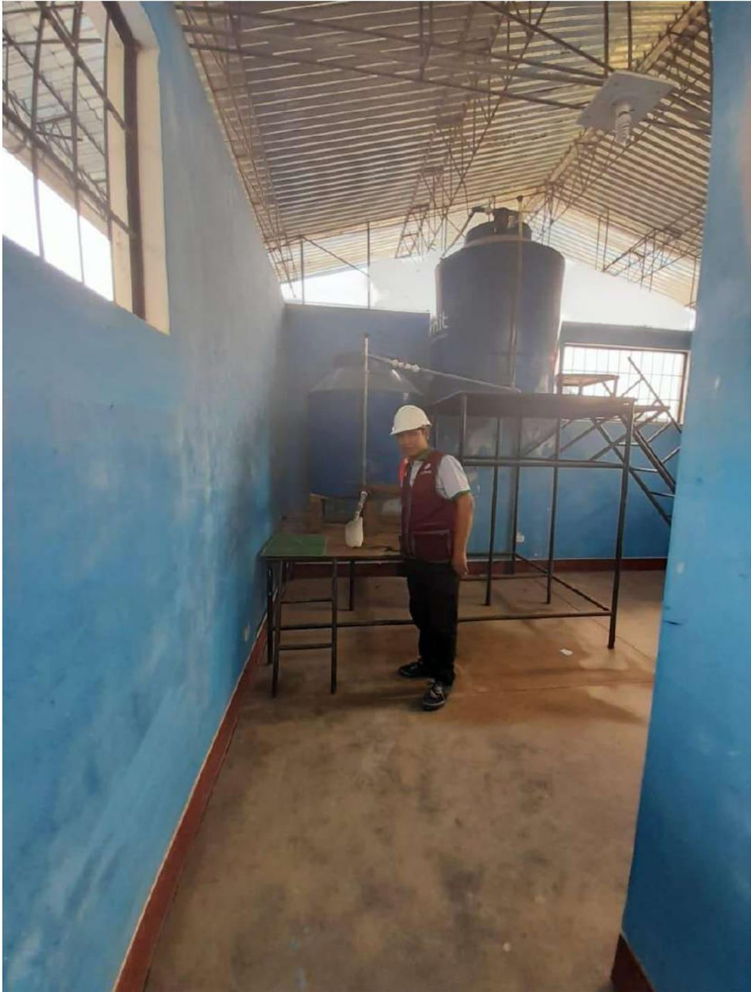
Figura 48: Se observa el mecanismo de los tanques para la cloración por goteo, ubicado en el 2do nivel.
