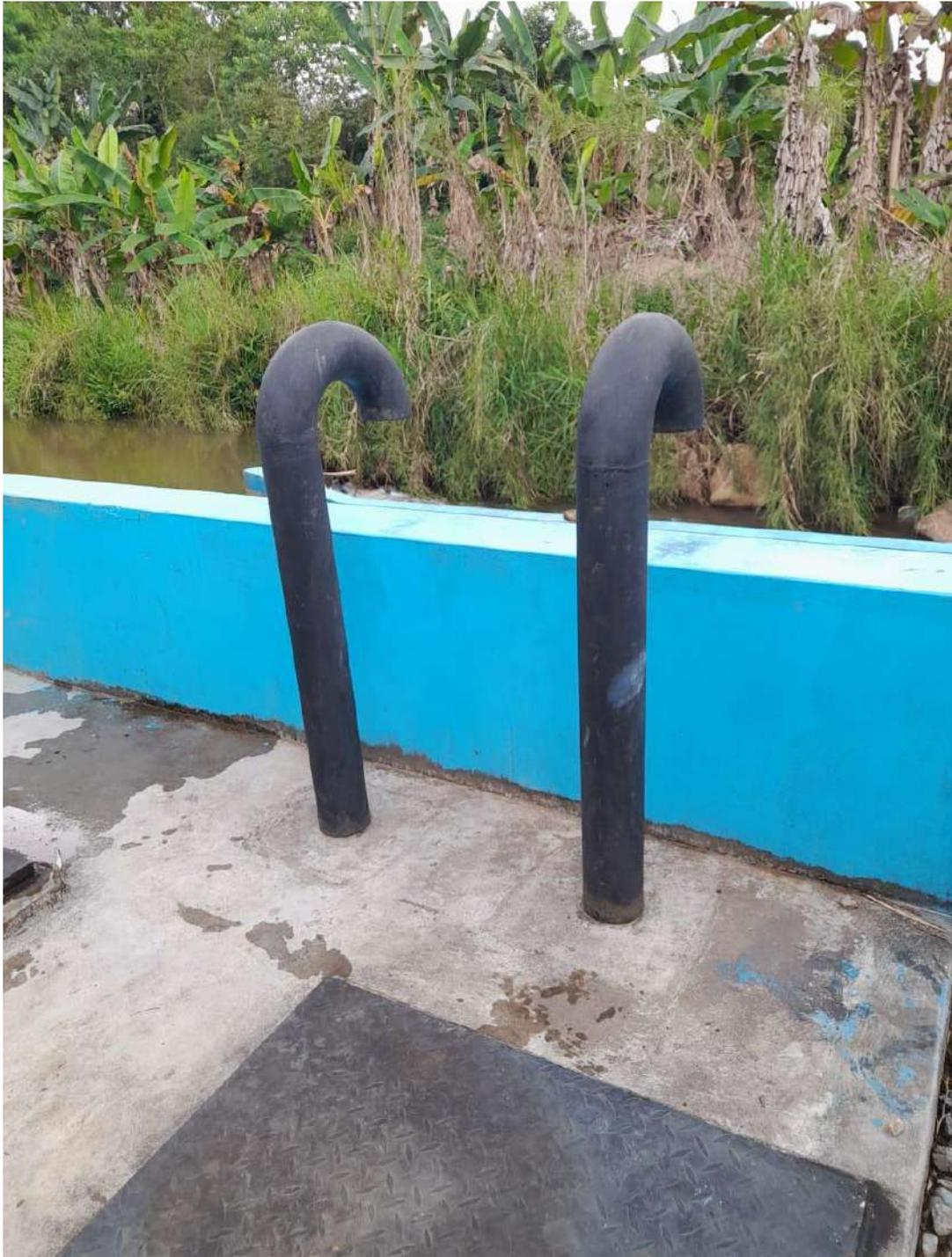
Figura 17: Se observa las tuberías de ventilación de las cámaras de válvulas.
