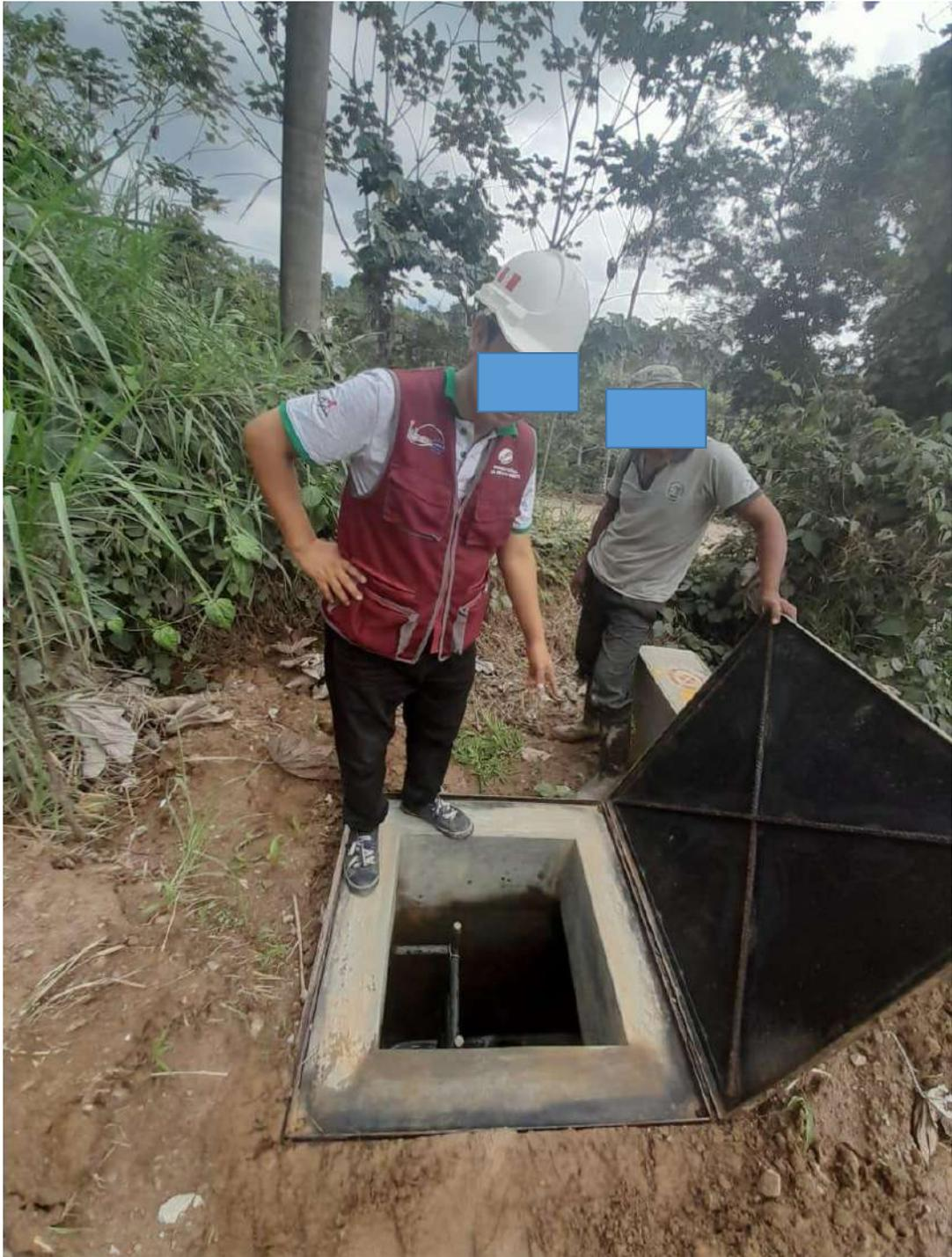
Figura 32: Vista panorámica de la cámara rompe presión N° 01, ubicada en el Km. 2+000 aprox. en la cota 916.17 msnm.
