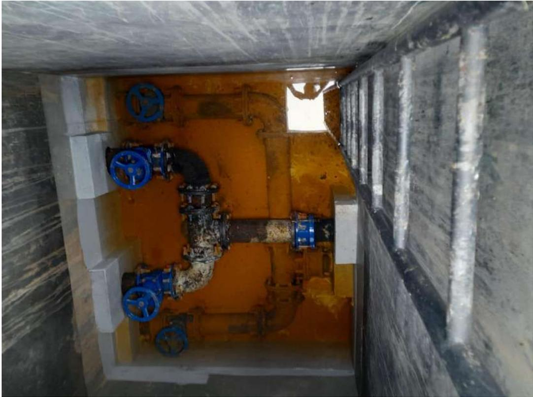
Figura 29: Se observa una serie de válvulas de compuerta.
