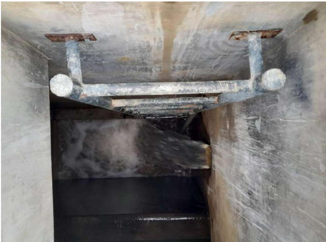
Figura 30: Se observa la salida del agua del Prefiltro - Filtro Lento.
