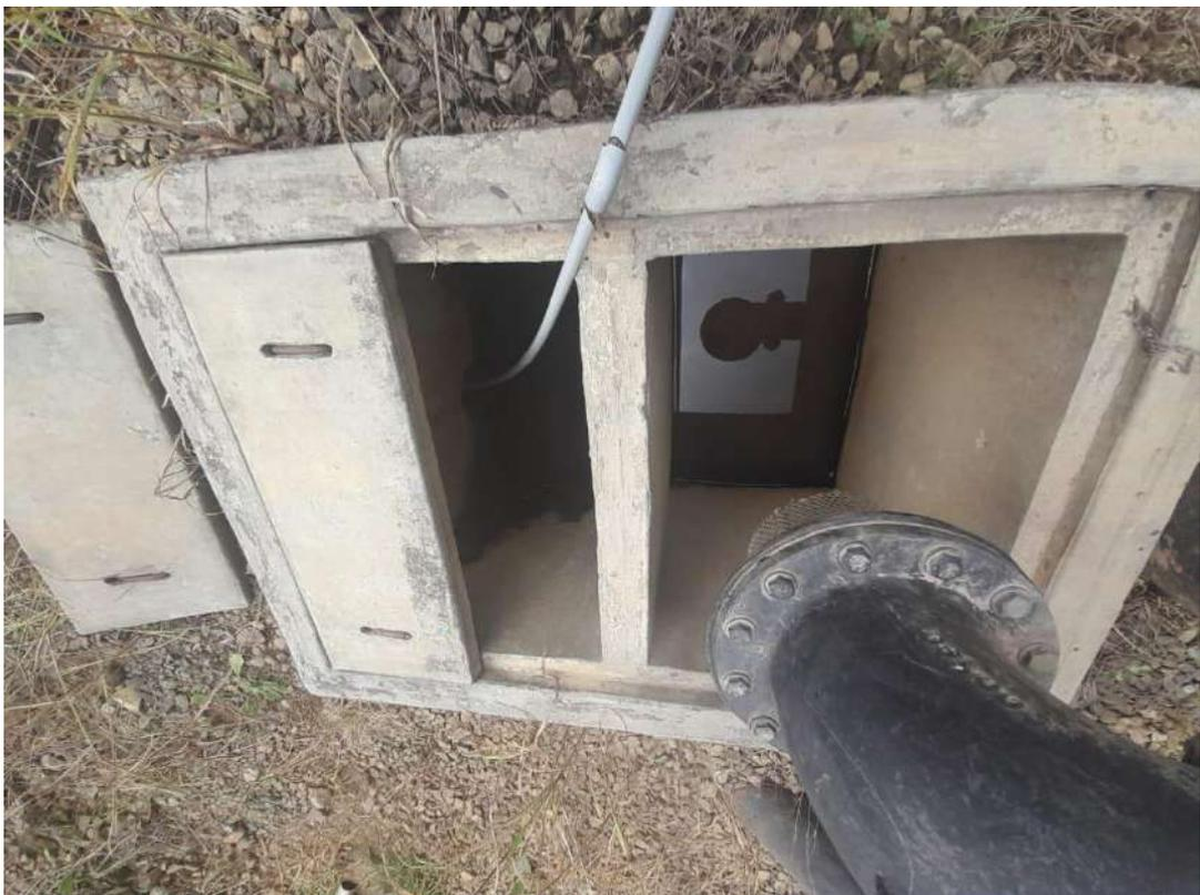
Figura 38: Se observa la tubería de limpieza y rebose con el respectivo filtro de salida.
