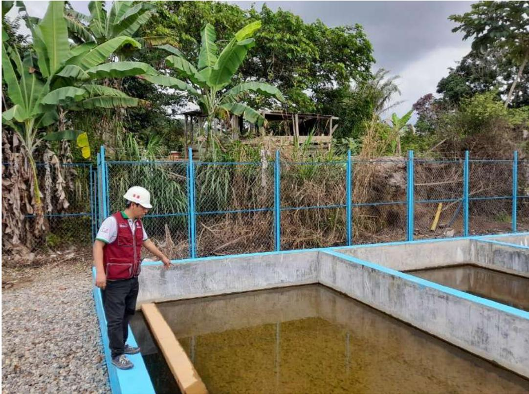
Figura 25: Se observa el 1er filtrado del agua en funcionamiento
