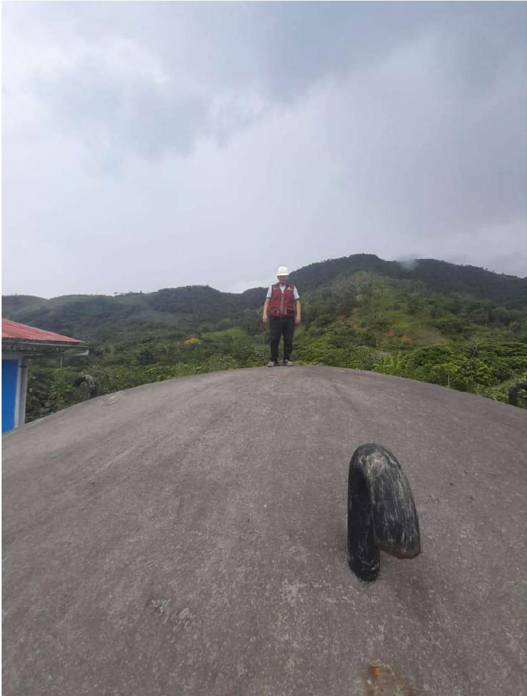
Figura 39: Se observa el techado del reservorio y la tubería de ventilación.
