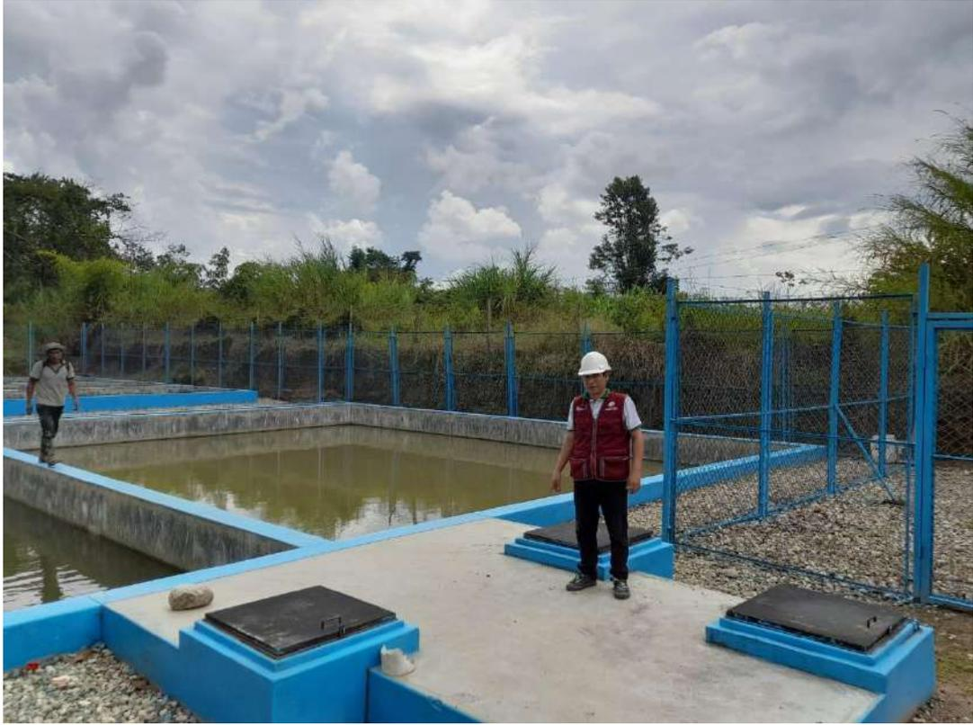
Figura 27: Se observa las 03 cámaras de filtrado,
