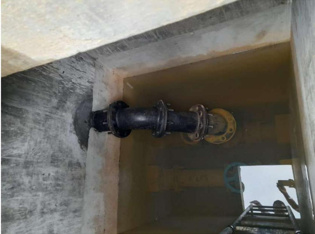
Figura 16: Se observa la tubería galvanizada negra de rebose y la válvula de compuerta.
