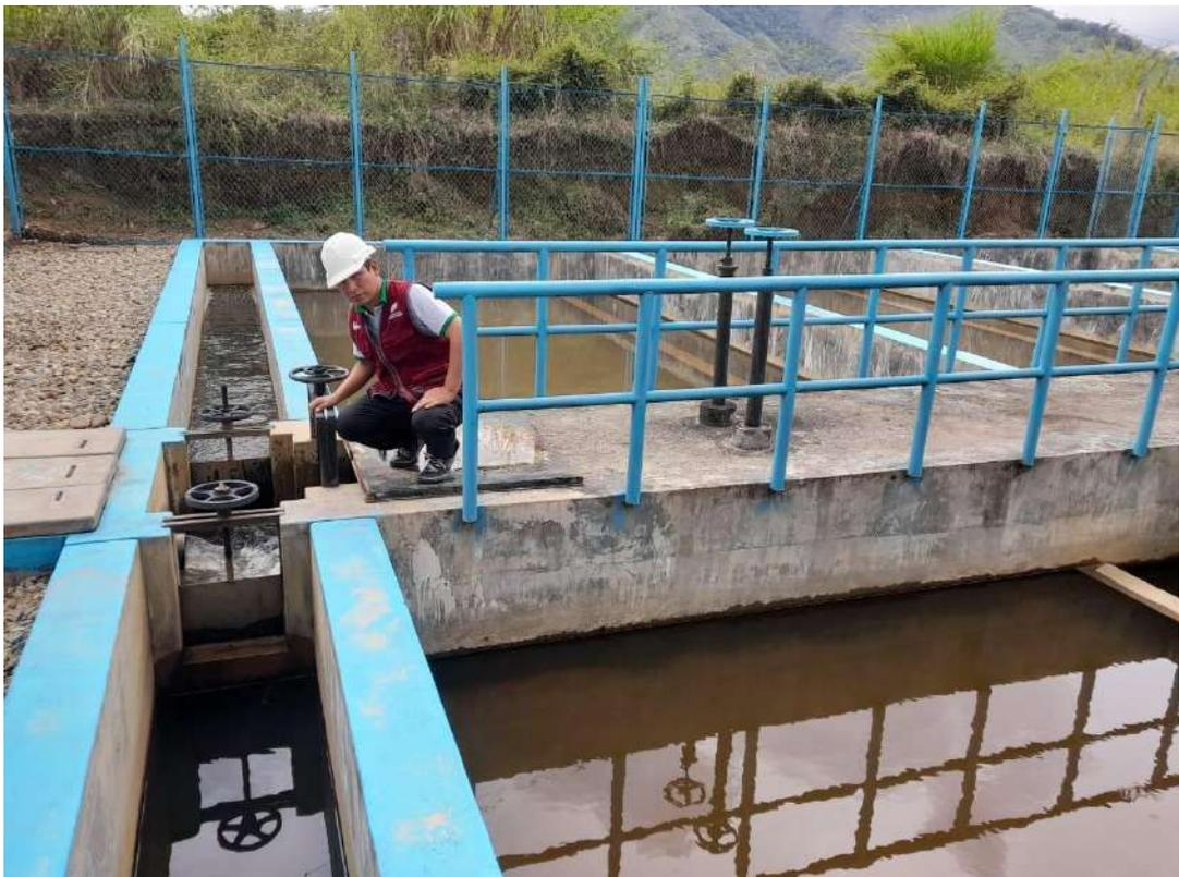
Figura 22: Se observa el ingreso del agua con 03 compuertas tipo tarjeta, ubicado en el km. 0+160 en la cota 954.30 msnm.
