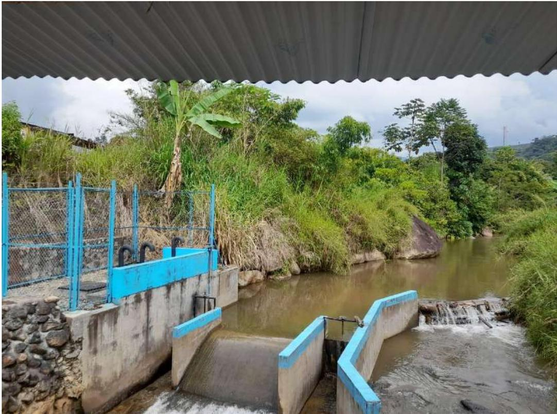
Figura 12: Vista del Barraje fijo y 02 compuertas tipo tarjeta de la captación.
