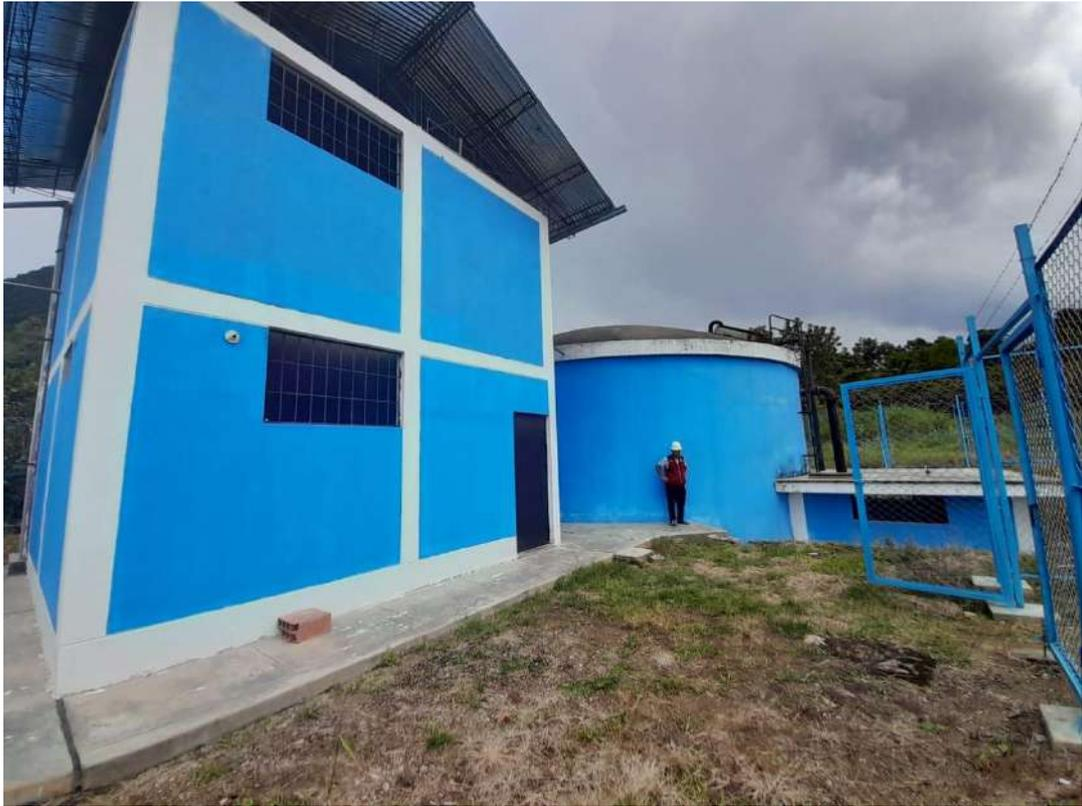
Figura 45: Se observa la caseta de cloración, el reservorio y caseta de válvulas.
