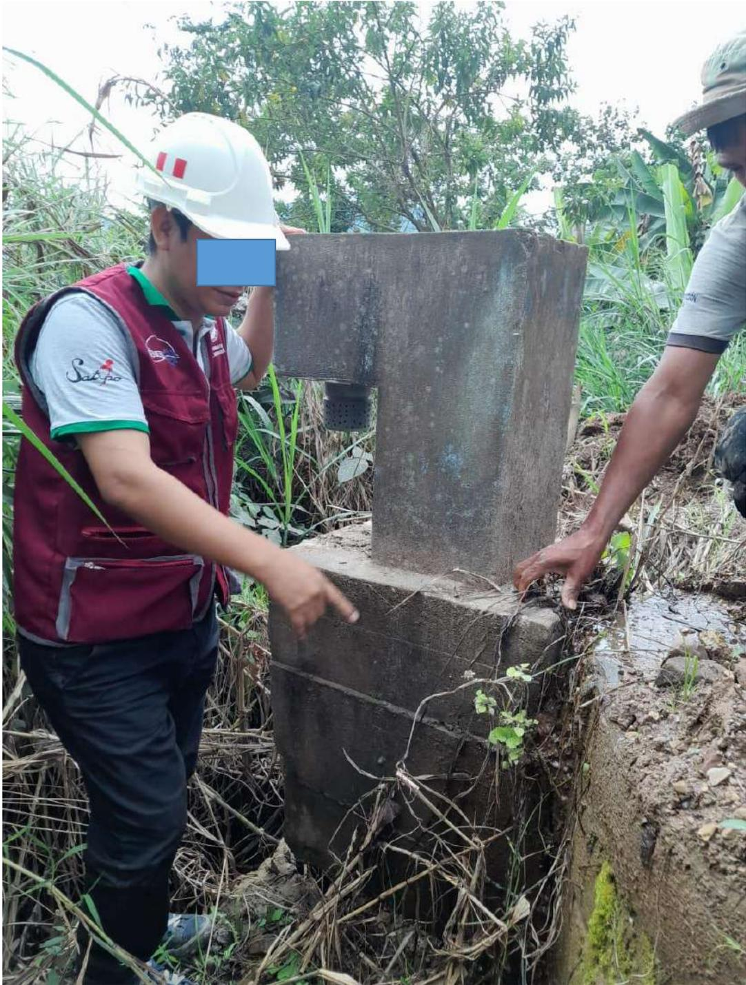
Figura 34: Se observa la cámara de válvula de purga, ubicada en el Km. 2+460 aprox. en la cota 890.89 msnm.
