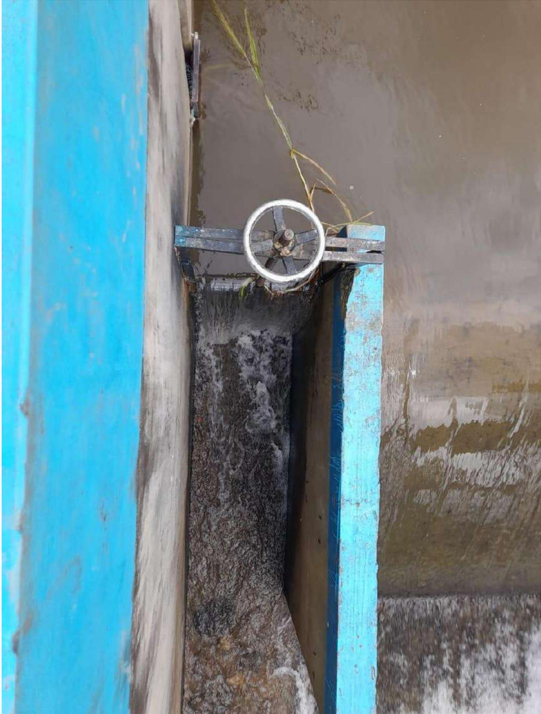
Figura 14: Vista de ingreso del agua a la cámara de alivio, como también se ve la compuerta tipo tarjeta.
