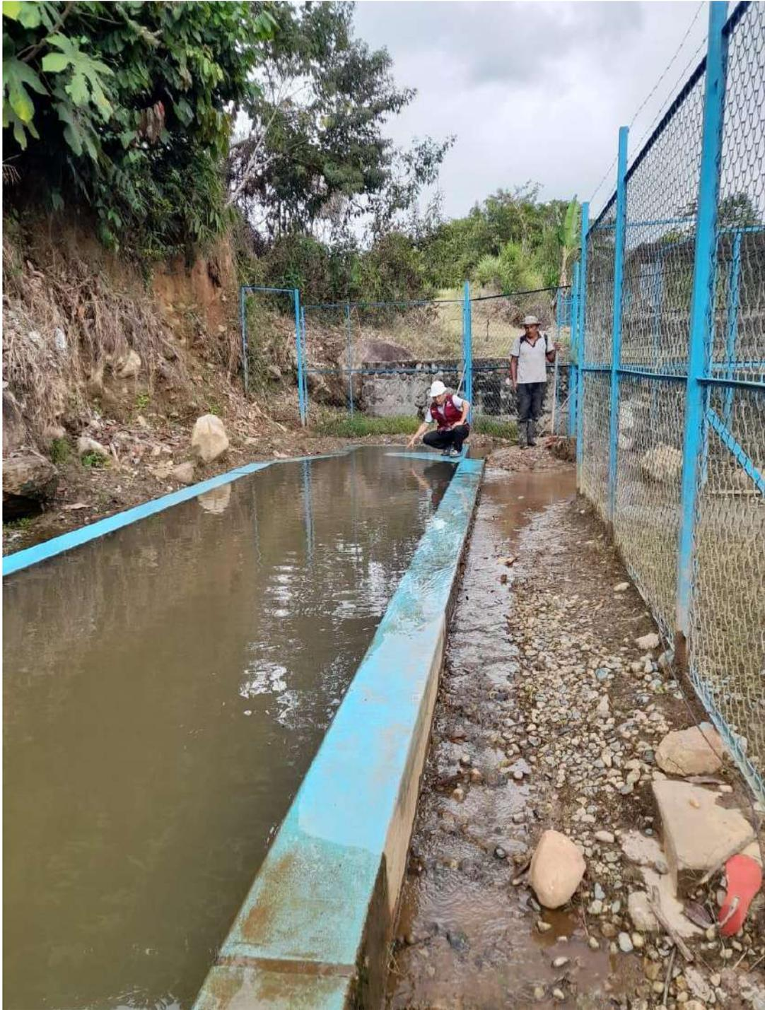
Figura 18: Se observa el desarenador, ubicado en el Km. 0+038 en la cota 957.28 msnm.
