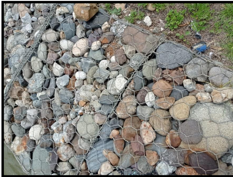
Figuras 12: Llenado de piedra. Fuente: Muro de gavión – Sector los libertadores
