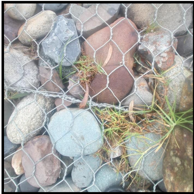
Figuras 19: Vegetación en la estructura. Fuente: Muro de gavión – Sector los libertadores
