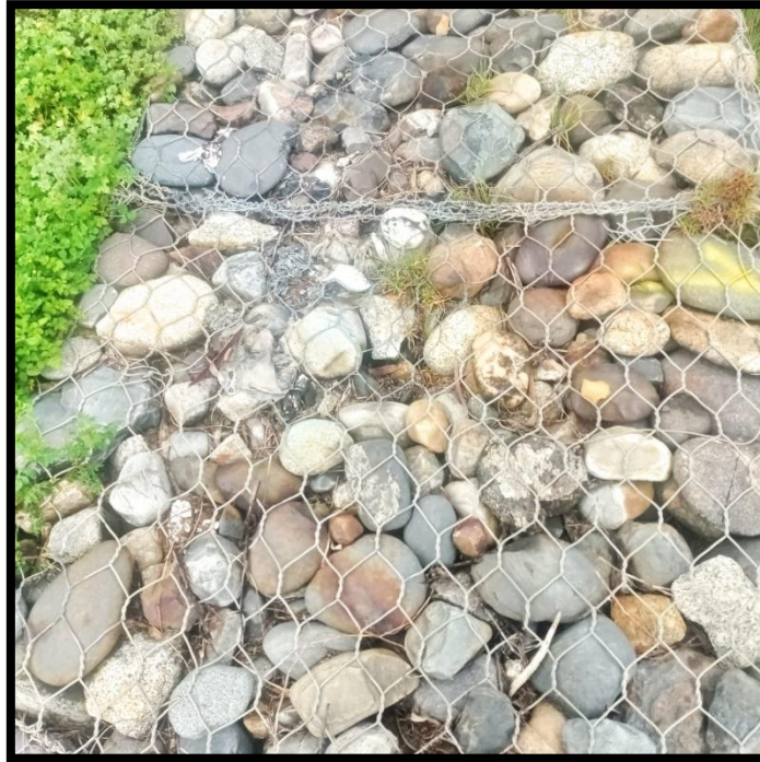
Figuras 13: Llenado de piedras. Fuente: Muro de gavión – Sector los libertadores
