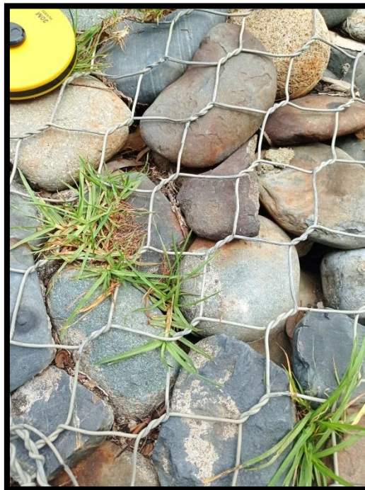
Figuras 10: Mallas del gavi3n. Fuente: Muro de gavi3n – Sector los libertadores
