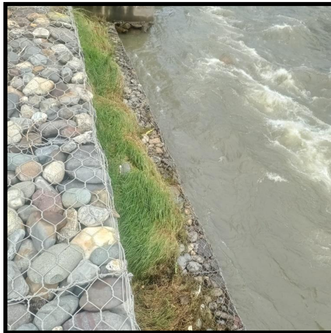
Figuras 17: Vegetación en la estructura. Fuente: Muro de gavión – Sector los libertadores
