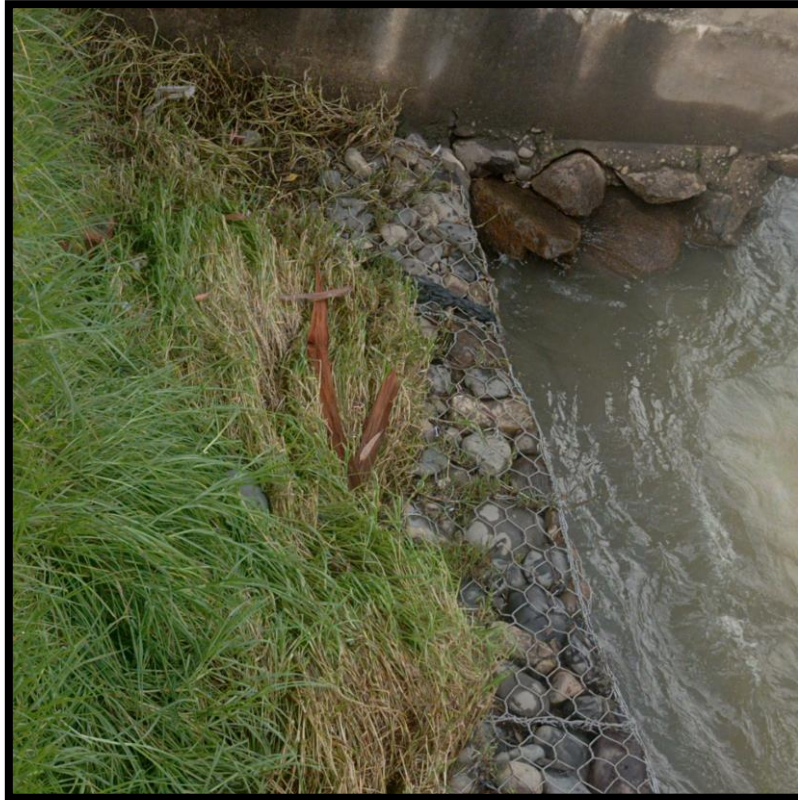
Figuras 16: Vegetación en la estructura Fuente: Muro de gavión – Sector los libertadores
