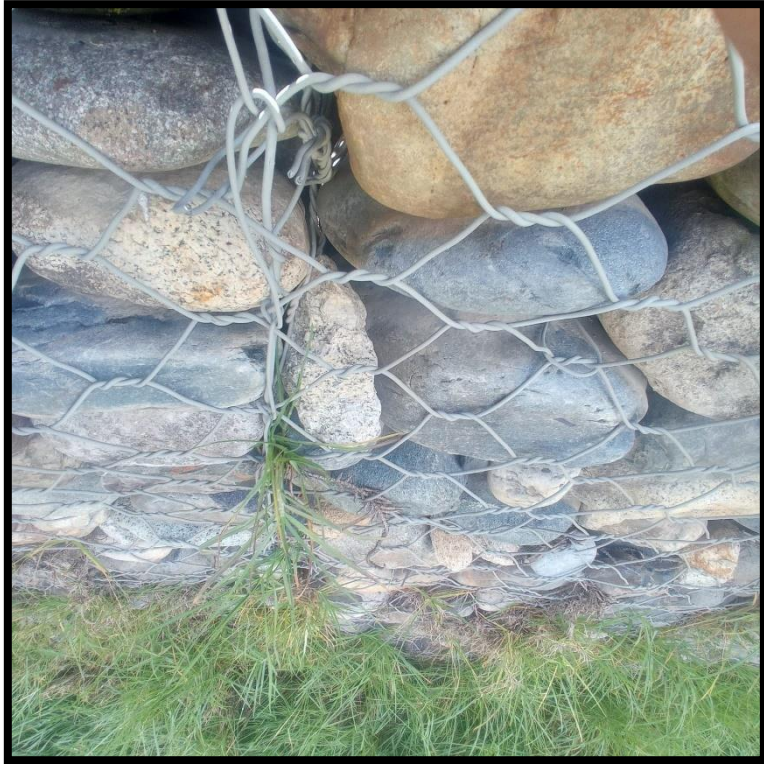
Figuras 20: Vegetación en la estructura. Fuente: Muro de gavión – Sector los libertadores
