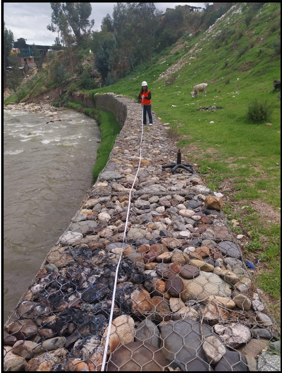
Figuras 6: Tramos del gavión. Fuente: Muro de gavión – Sector los libertadores
