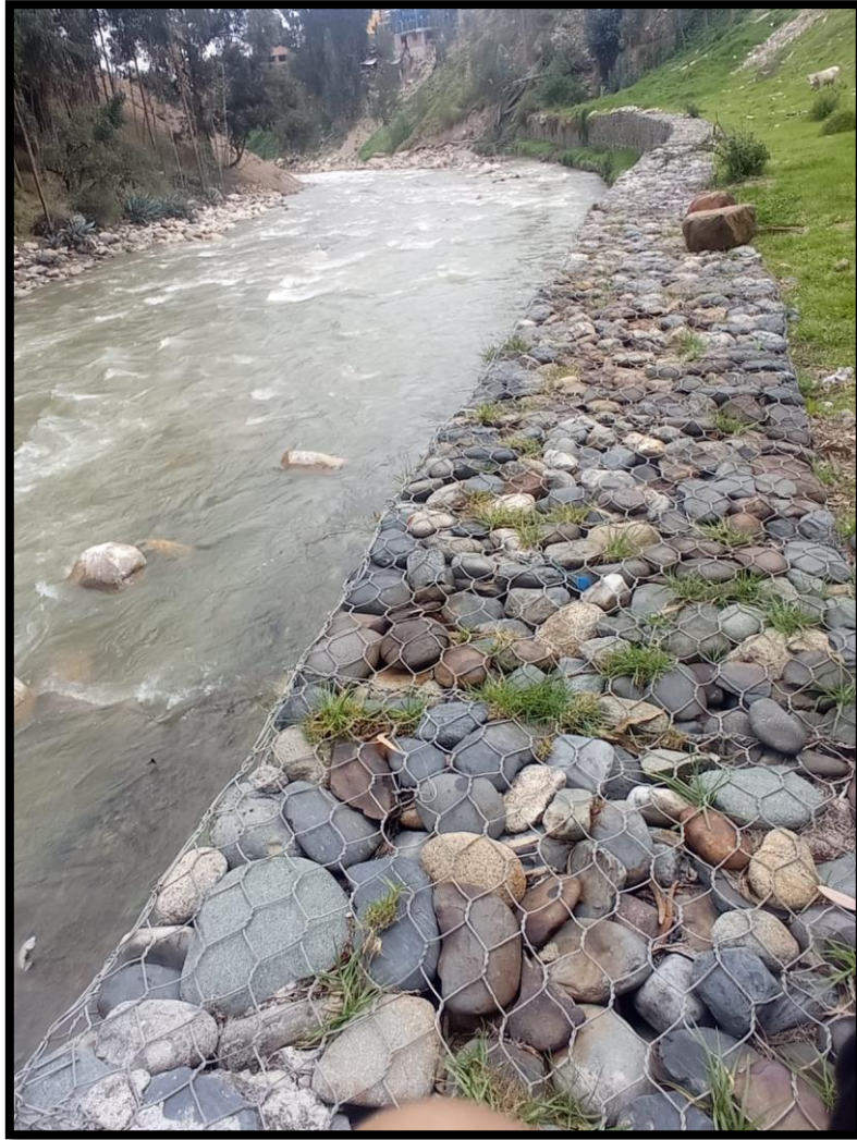
Figuras 15: Mallas del gavi3n. Fuente: Muro de gavi3n – Sector los libertadores
