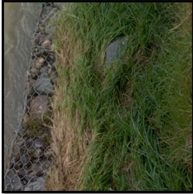
Figuras 18: Vegetación en la estructura. Fuente: Muro de gavión – Sector los libertadores
