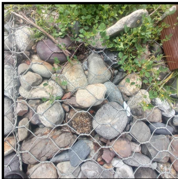
Figuras 2: Mallas del gavión. Fuente: Muro de gavión – Sector los libertadores
