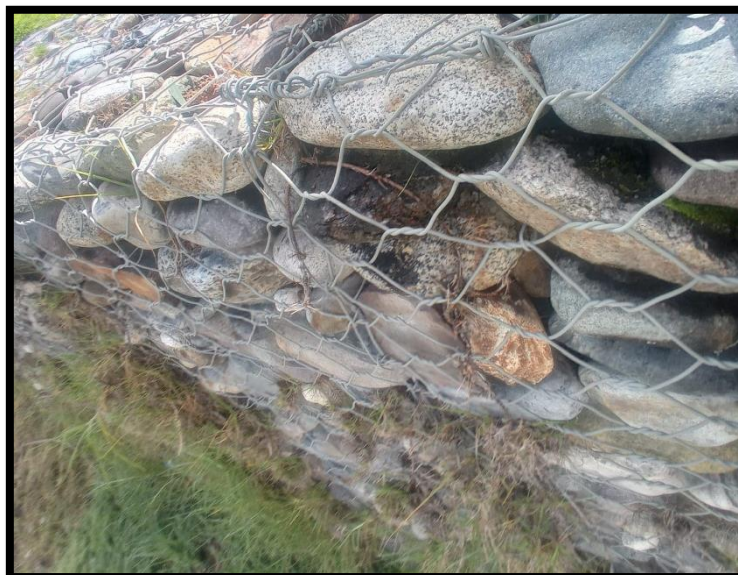
Figuras 1: Mallas del gavión. Fuente: Muro de gavión – Sector los libertadores
