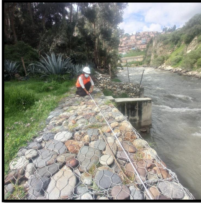
Figuras 11: Mallas del gavión. Fuente: Muro de gavión – Sector los libertadores
