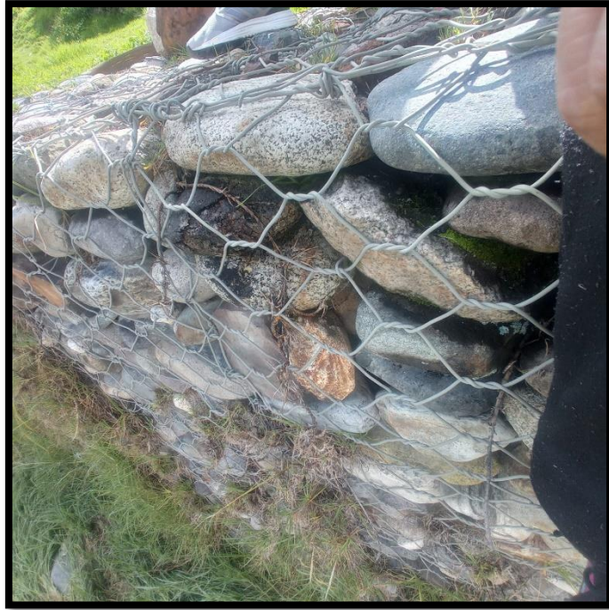
Figuras 3: Mallas del gavión. Fuente: Muro de gavión – Sector los libertadores
