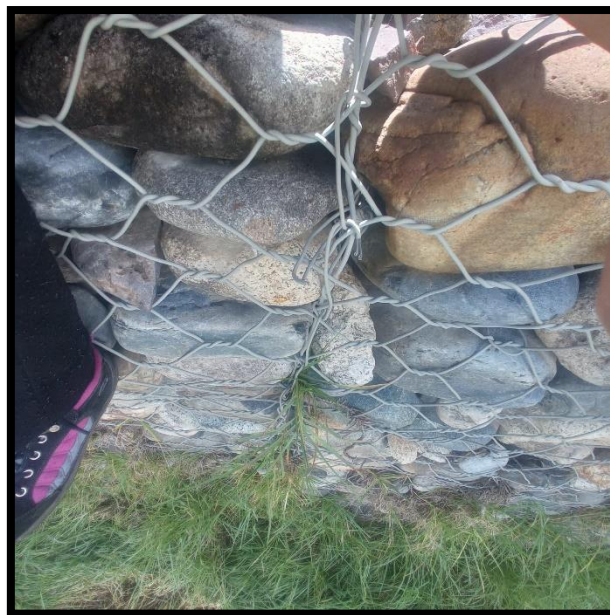
Figuras 4: Mallas del gavión. Fuente: Muro de gavión – Sector los libertadores
