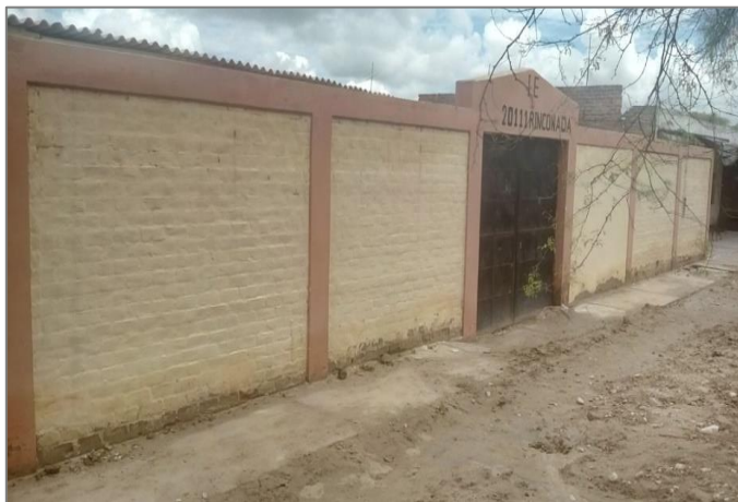
Imagen 9: Cerco perimétrico de institución educativa.
