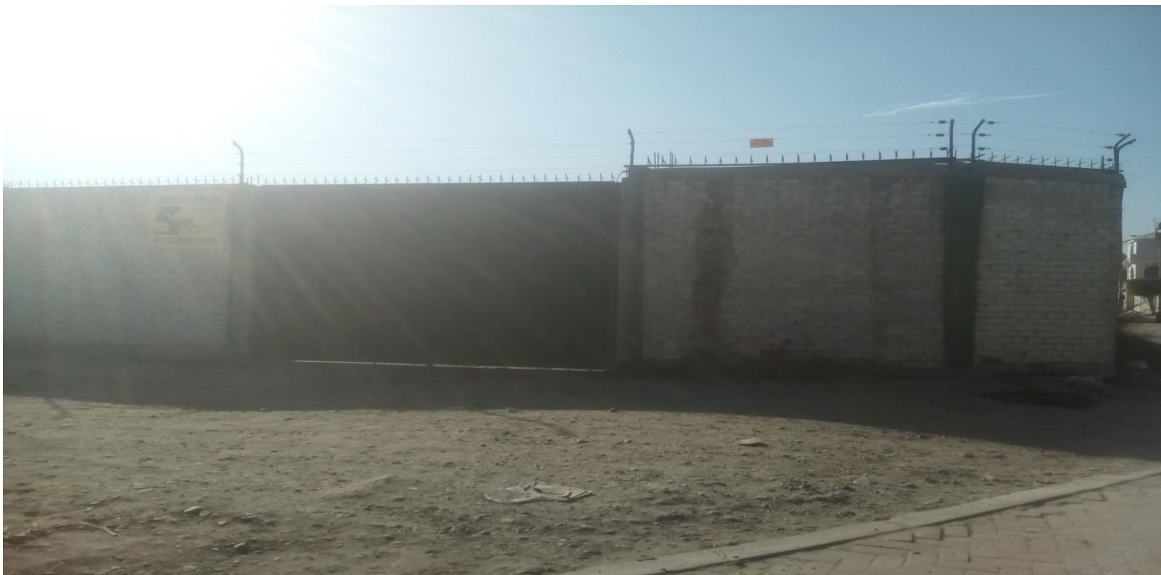
Imagen 16: vista panorámica del cerco perimétrico del taller INGELME E.I.R.L.
