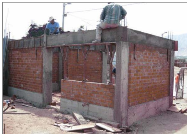
Imagen 4: Definición de albañilería confinada.
