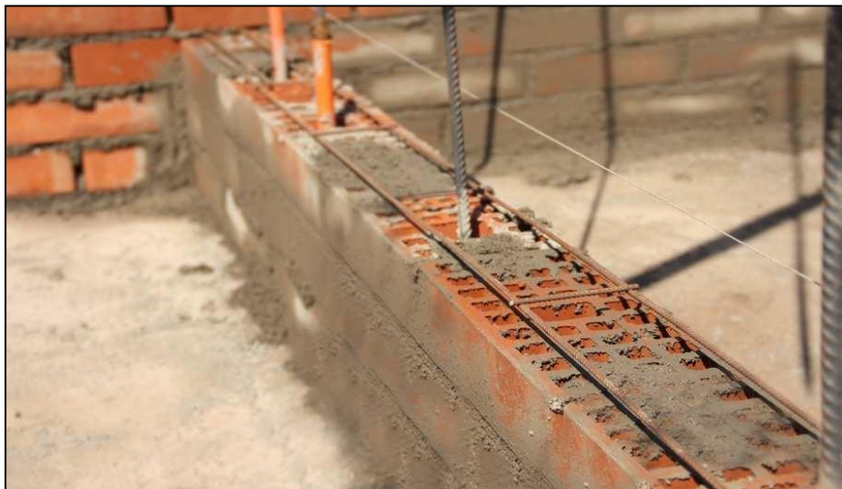
imágenes 2: de albañilería armada.
