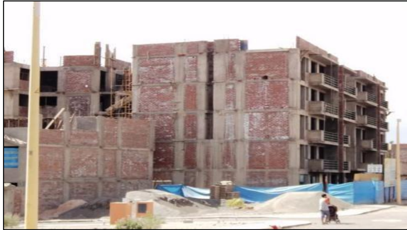
imágenes 11: de elemento estructural.
