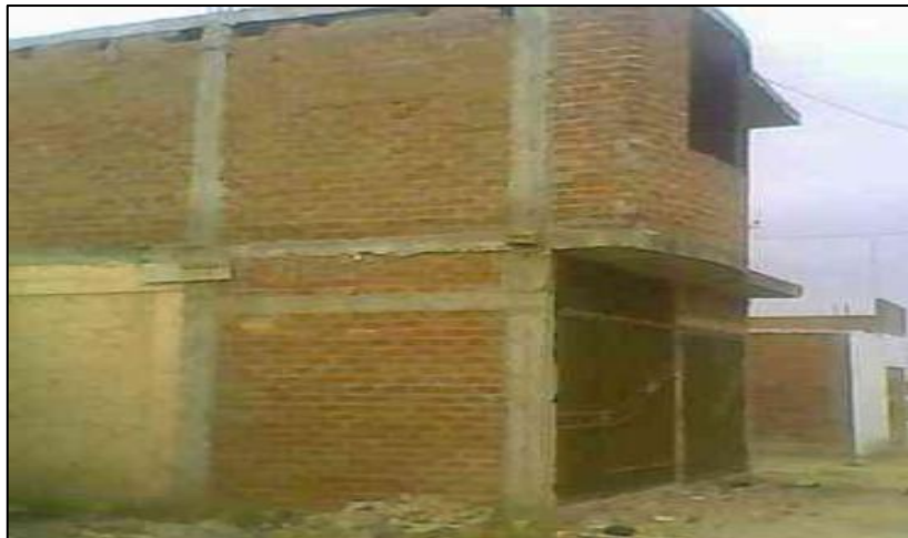
imágenes 10: de muros portantes.
