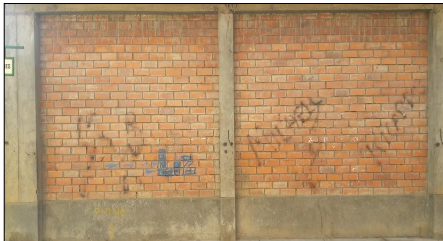
imágenes 5: de albañilería armada.
