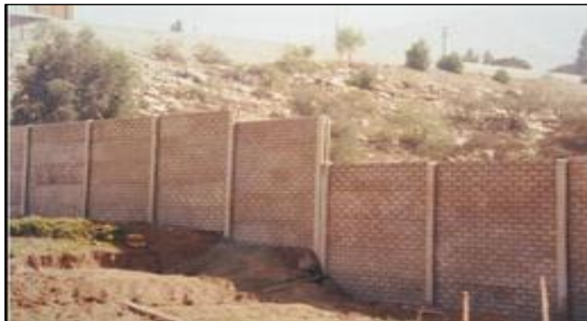
imágenes 9: de muros no portantes.
