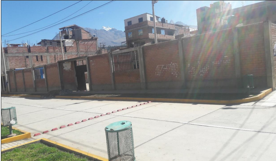
imágenes 43: vista frontal del cerco perimétrico de la losa deportivo los Ángeles.
