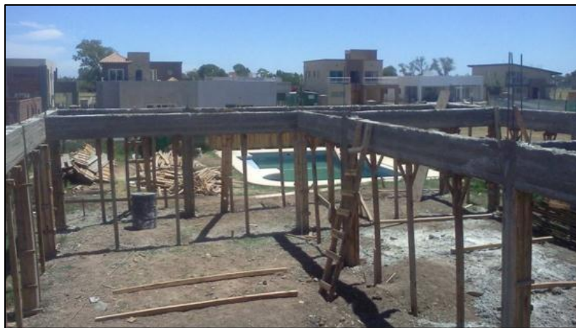
imágenes 16: Vigas de concreto armado.
