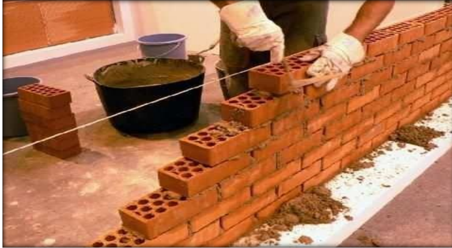
imágenes 1: Albañilería simple.
