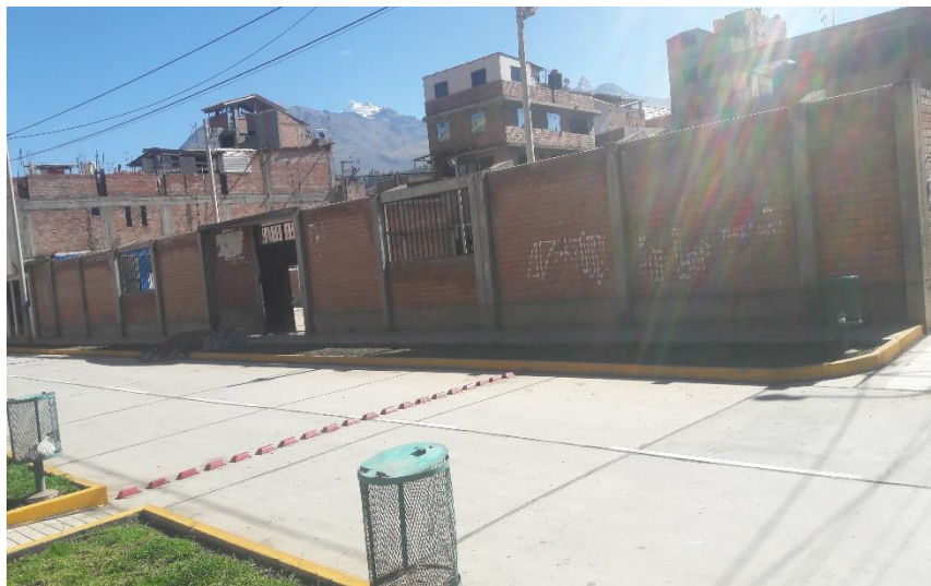
imágenes 8: Imagen de cerco perimétrico.
