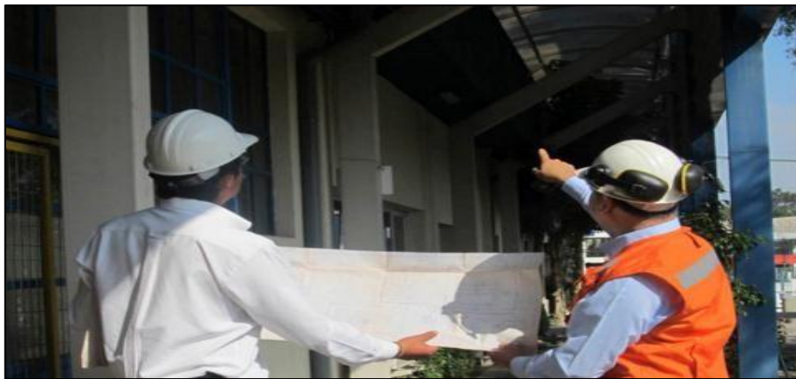
imágenes 35: Las patologías de diseño de la reparación.
