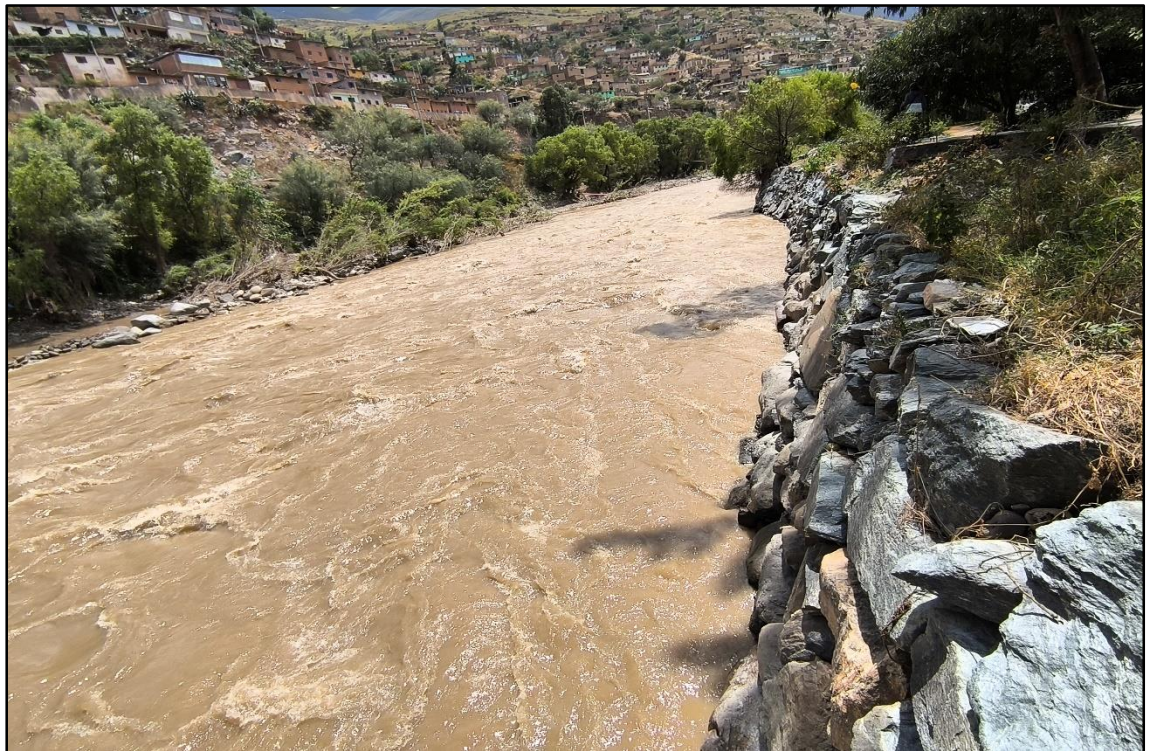
Fotografía 04: Zona 2, enrocado en buen estado.
