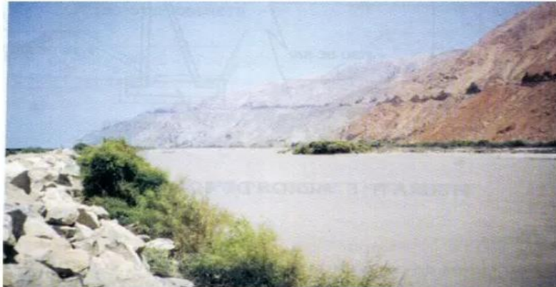
FOTO N° 2. DIQUE ENROCADO CONTINUO VALLE OCOÑA Q_{MAX} 3100 \text{ m}^3/\text{seg.}
