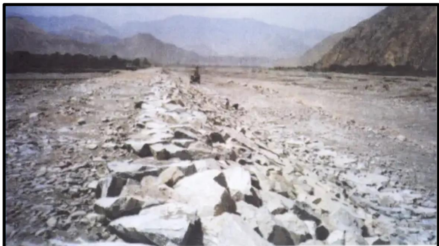
Figura 3: Enrocado con roca colocada Fuente: Extraído del libro de Terán (15).
