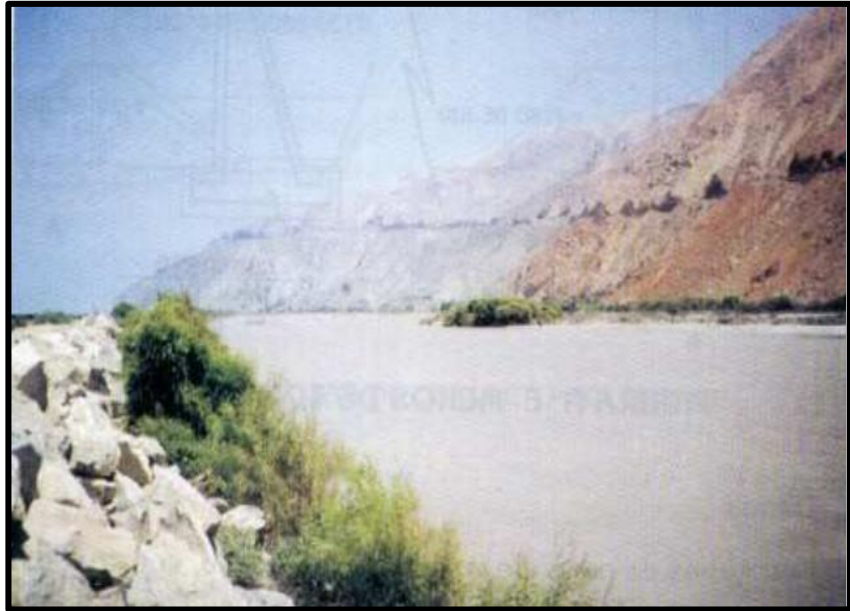
Figura 2: Enrocados con roca al volteo Fuente: Terán (15).
