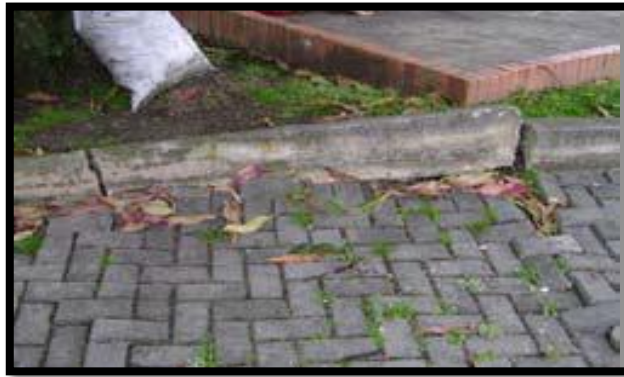
FIGURA N° 11: FRACTURAMIENTO CONFINAMIENTOS EXTERNOS
