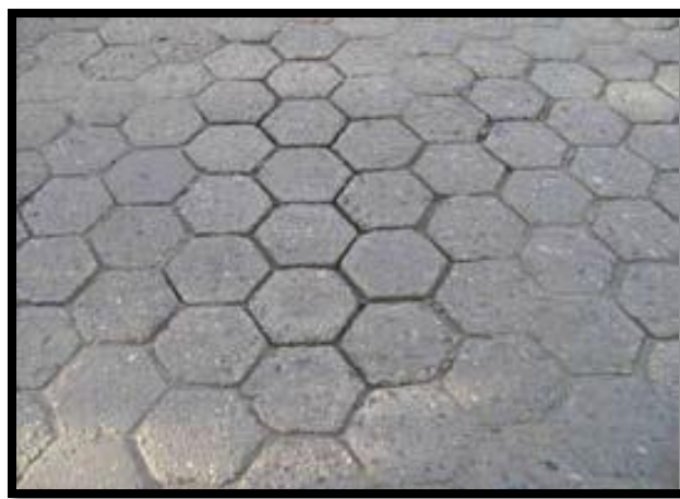
FIGURA N° 15: JUNTAS ABIERTAS
