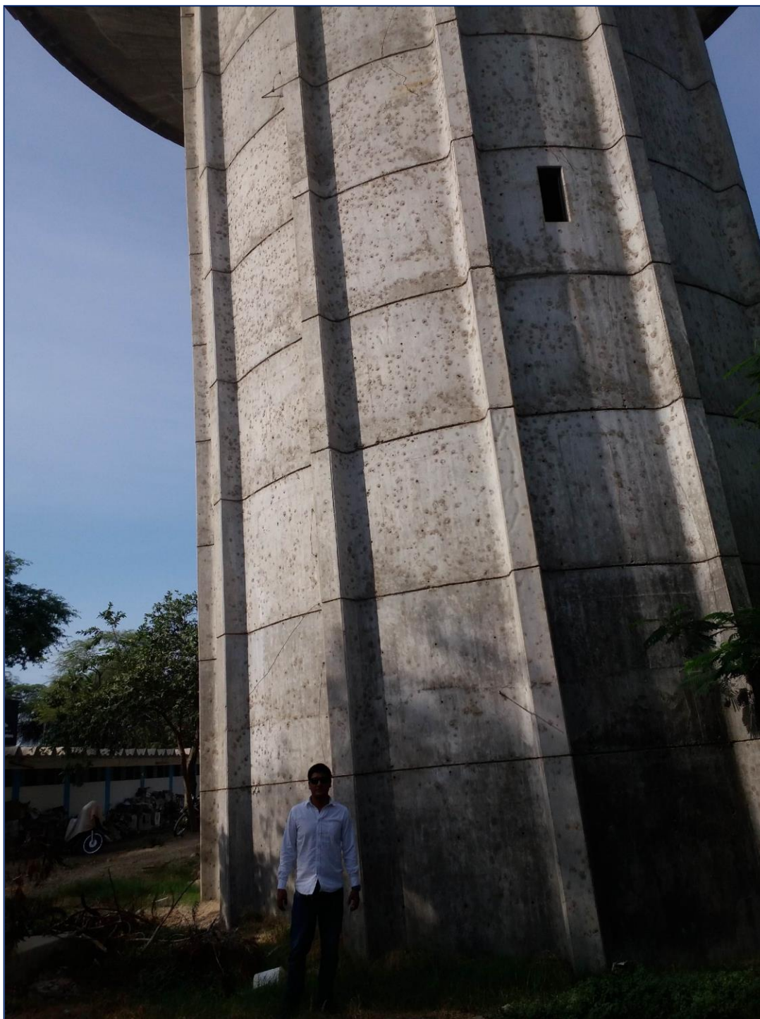
INSPECCIÓN DE ESTRUCTURA DE SOPORTE DEL RESERVORIO R7 - PACHITEA
