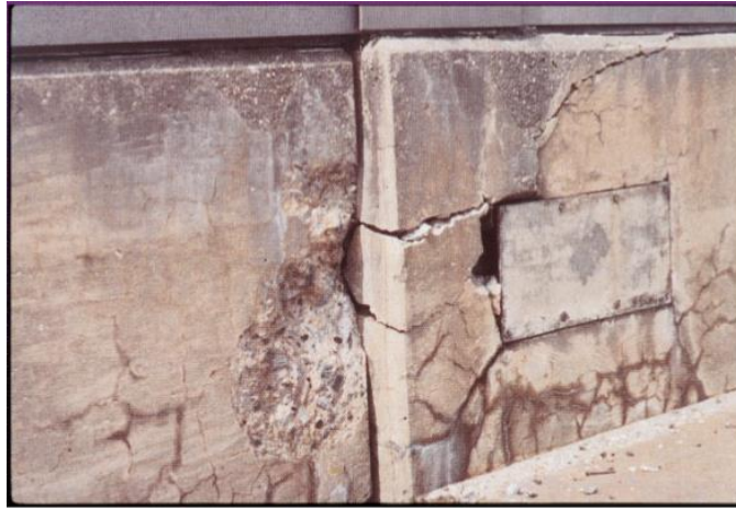
Gráfico N° 14: Distorsión en concreto.
