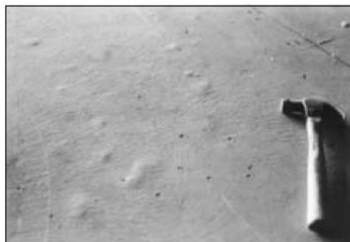
Gráfico N° 05: Formación de ampollas en el concreto.
