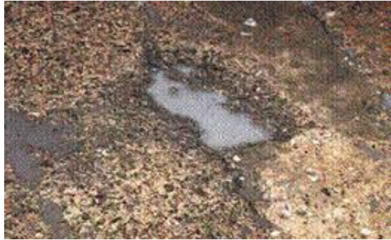
Gráfico N° 19: Ataque por soluciones acidas.
