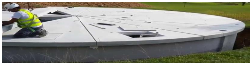
Gráfico N° 01: Reservorio enterrado o Subterráneo.
