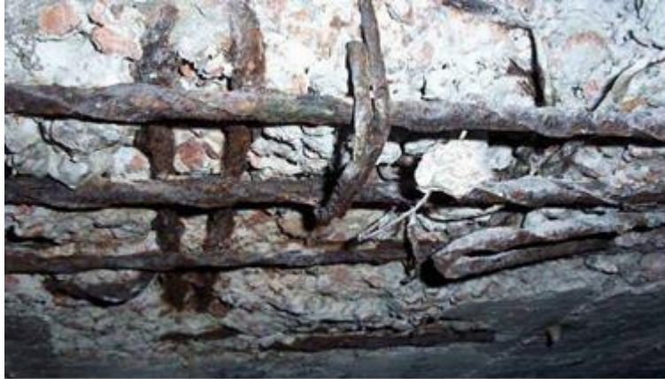
Gráfico N° 20: Corrosión.
