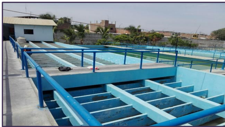
Foto N°12: Modulo N° 01 de la Planta de Tratamiento-Sullana
