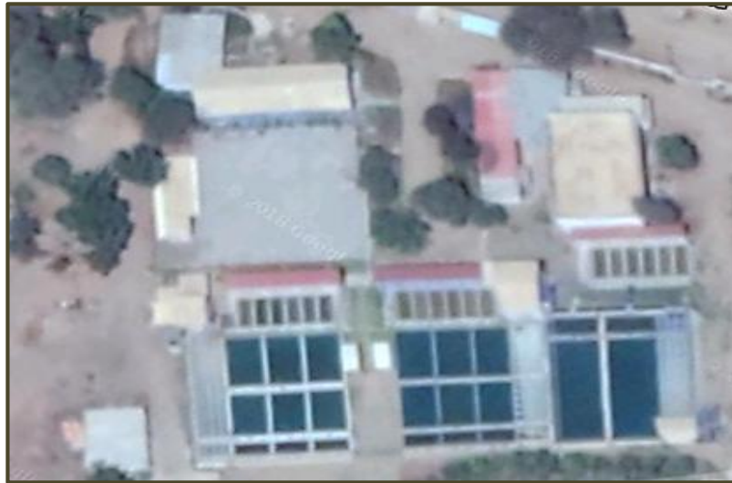
Figura N°11: Cisterna de la Planta de Tratamiento de Agua Potable
