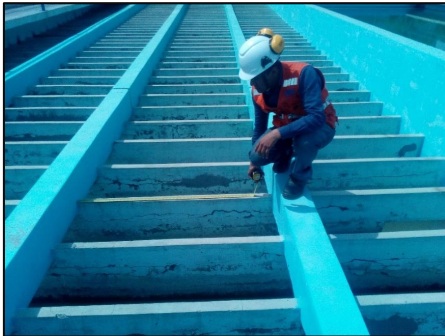
Foto N° 20: Tomando medidas de la pantalla del Floculador
