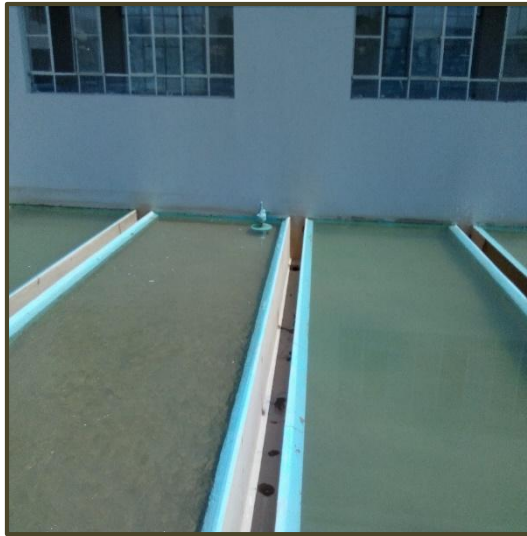
Foto N°03: Filtros del Módulo I
