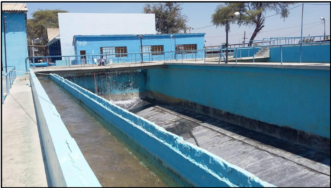
Foto N° 16: Decantador en mantenimiento
