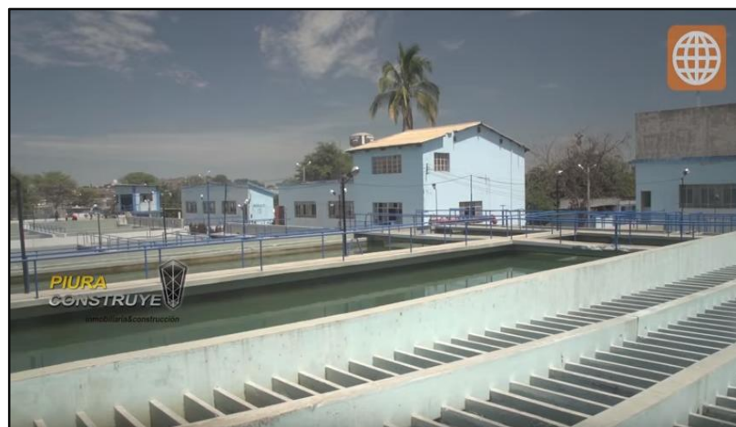
Figura N° 07: Planta de Tratamiento de Agua Potable-Sullana
