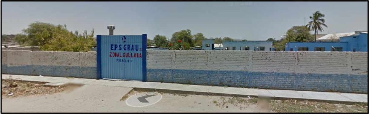
Foto N° 15: Ingreso a la Planta de Tratamiento
