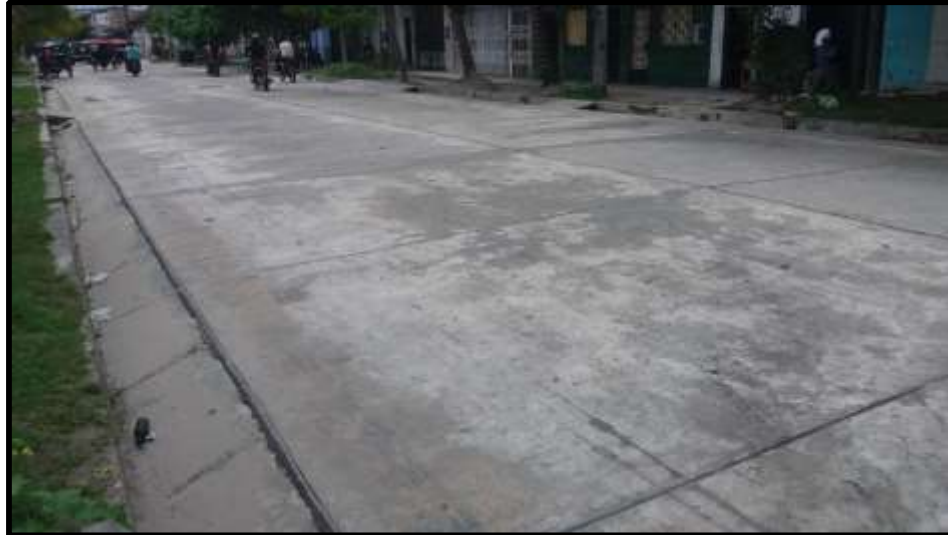
Figura 55, Vista panorámica de la Ca. Bolognesi /Jr. Bermúdez
