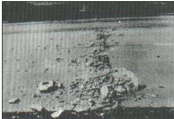
Figura 04. Falla Blow Up /Blucklin.
