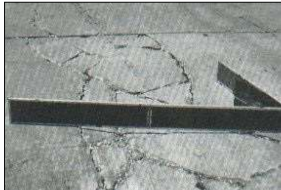
Figura 07, Falla Punzonamiento
