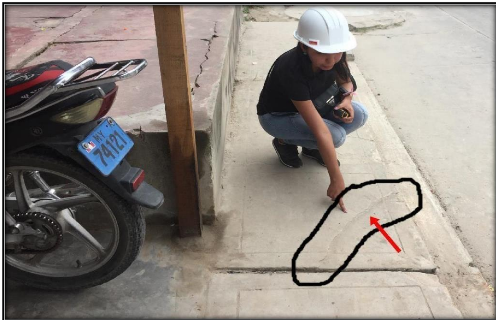
Figura 136: Vista fotográfica UMI -I, superficie del pavimento de vereda presenta un tipo de falla Grieta de Esquina de severidad alta. (Calle Iquitos, cdra. 12)
