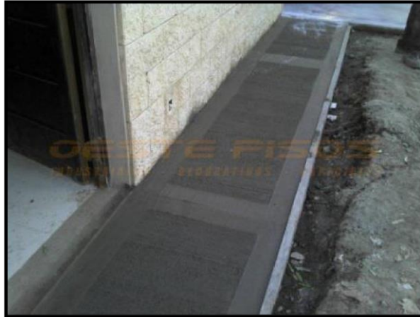
Figura 8. Vereda de Hormigón Peinado
