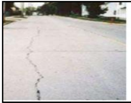
Figura 12. Fisuración Longitudinal
