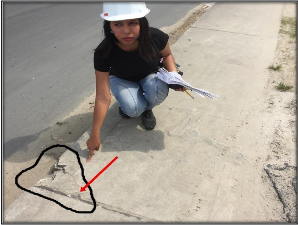
Figura 136: Vista fotográfica UMI -I, superficie del pavimento de vereda presenta un tipo de falla Grieta de Esquina de severidad alta. (Calle Iquitos, cdra. 12)
