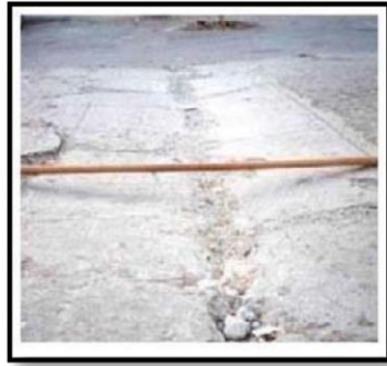
Figura 21. Hundimiento.
