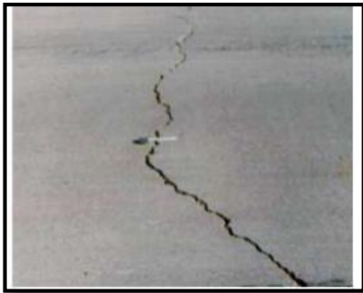
Figura 11. Fisuración transversal
