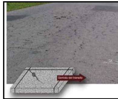
Figura 20. Fisura inducida.
