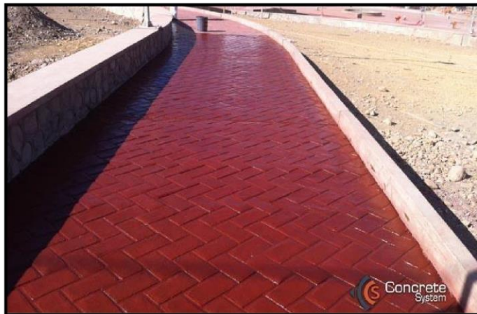
Fuente: Catalogo de Concreto System Figura 7. Vereda Adoquinada
