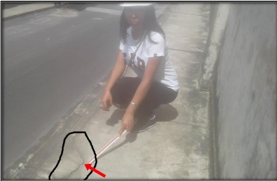
Figura 150: Vista fotográfica UM3-D, superficie del pavimento de vereda presenta un tipo de falla Grieta Lineal severidad baja. (Calle Iquitos, cdra. 14)
