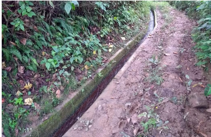
Gráfico 4: Canal de concreto.
