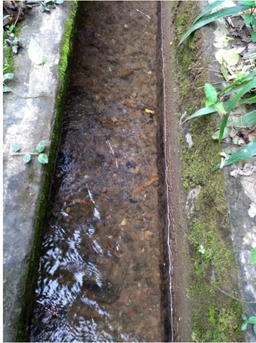
Gráfico 144: Erosión en el fondo del canal sublateral San Cristóbal Bajo
