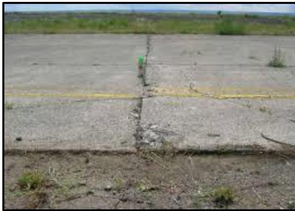
**Figura 6** Blowup / buckling de baja severidad
