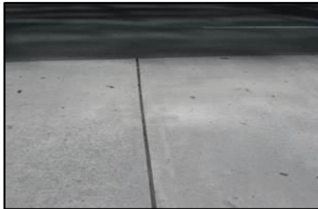
**Figura 21** Daño del sello de junta de severidad baja
