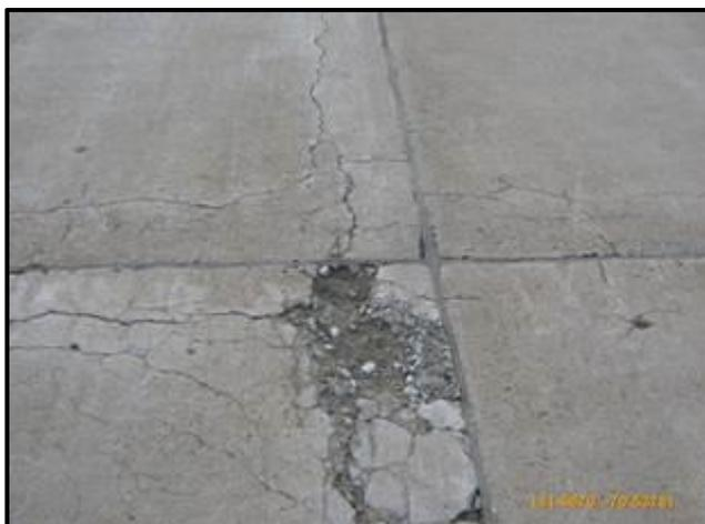
**Figura 17 Grieta de durabilidad de severidad alta**
