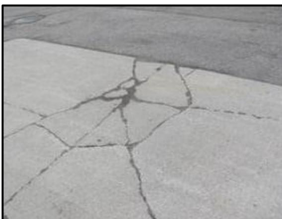
**Figura 42 Punzonamiento de alta severidad**
