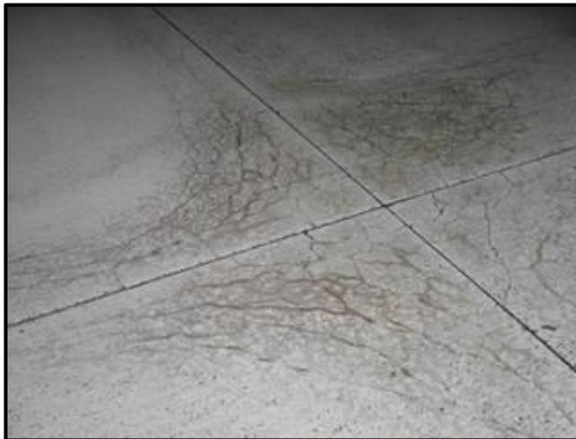
**Figura 16 Grieta de durabilidad de severidad media**
