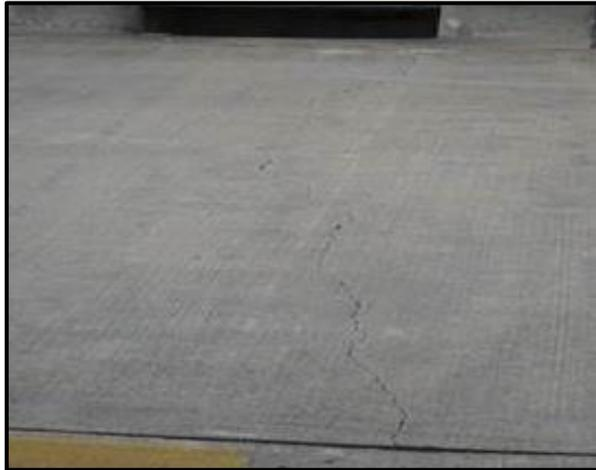
**Figura 27 Grietas lineales de baja severidad**
