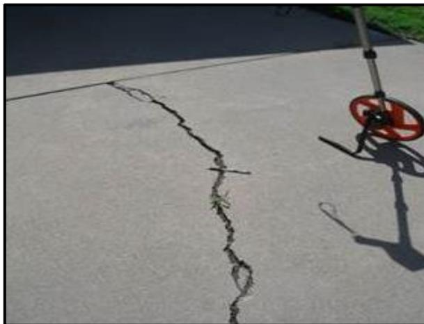
**Figura 28 Grietas lineales de severidad media**
