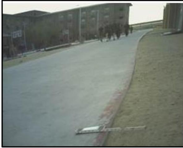
**Figura 24** Desnivel Carril/Berma de baja severidad
