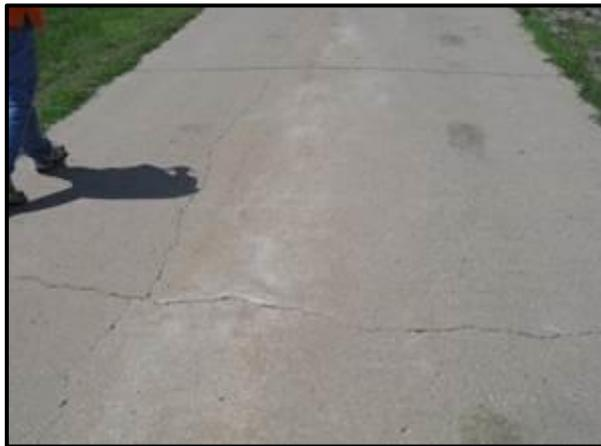
**Figura 12 Losa dividida de baja severidad**
