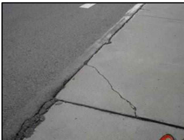
**Figura 9** Grieta de esquina de baja severidad
