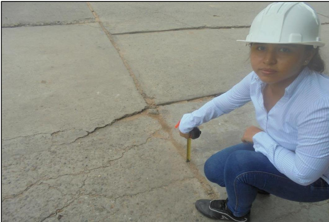
**Figura 130. Se observa la Escala de severidad media**
