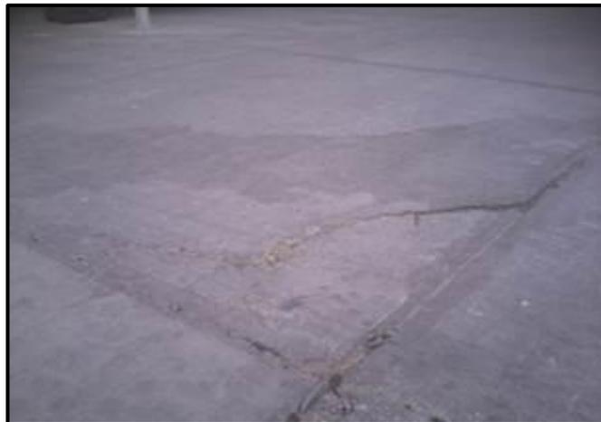
**Figura 11 Grieta de esquina de alta severidad**
