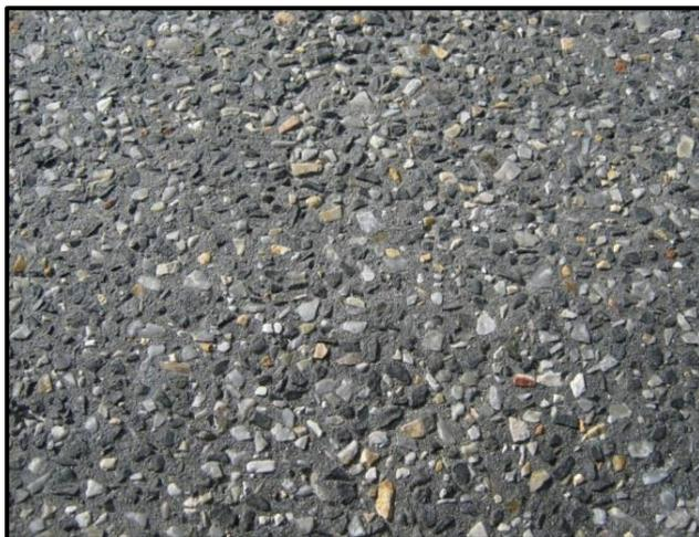
**Figura 36 Pulimento de agregados**
