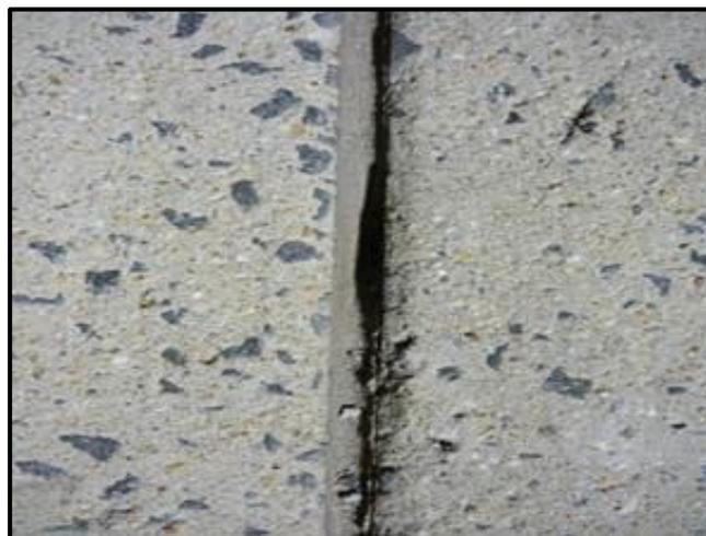
**Figura 22** Daño del sello de junta de severidad media
