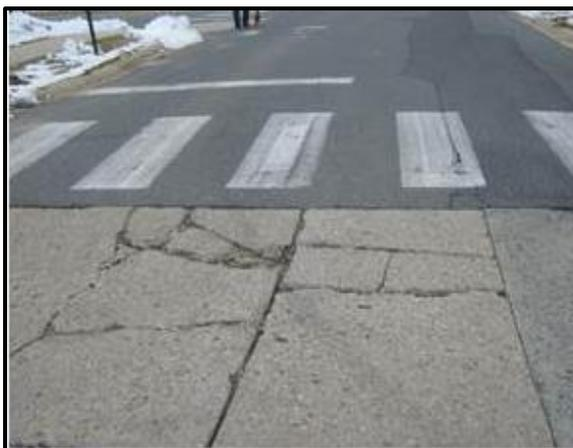
**Figura 41 Punzonamiento de severidad media**
