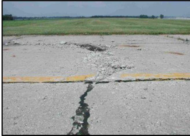
**Figura 8 Blowup / bluckling de alta severidad**
