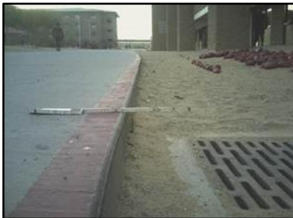
**Figura 26** Desnivel Carril/Berma de alta severidad
