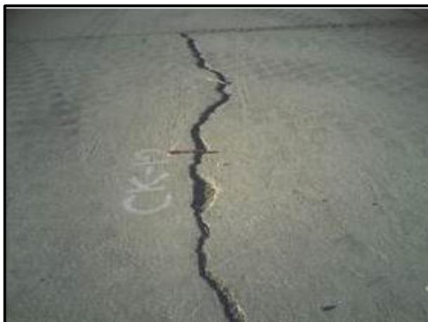
**Figura 29 Grietas lineales de alta severidad**
