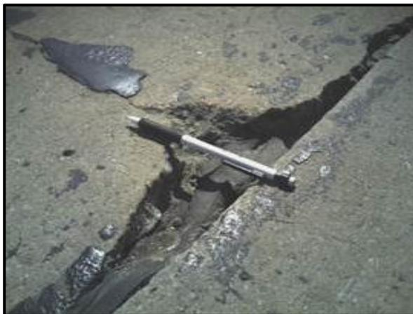
**Figura 53** Descascaramiento de junta de severidad media
