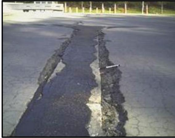
**Figura 54 Descascaramiento de junta de alta severidad**
