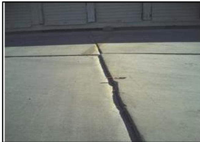
**Figura 20** Escala de alta severidad
