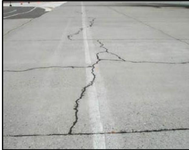
**Figura 13 Losa dividida de severidad media**
