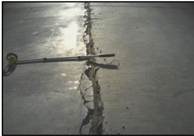
**Figura 19** Escala de severidad media
