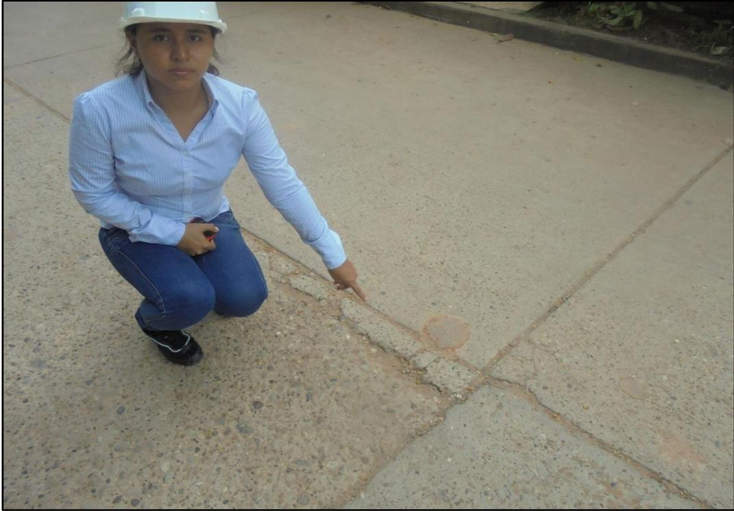
**Figura 152. Se observa el Descascaramiento de junta con severidad media**
