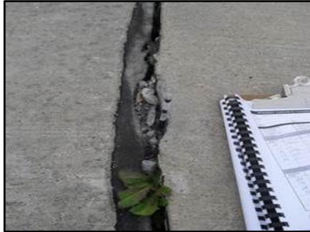
**Figura 23 Daño del sello de junta de alta severidad**
