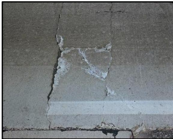
**Figura 40 Punzonamiento de baja severidad**
