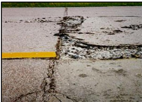
**Figura 7** Blowup / buckling de media severidad
