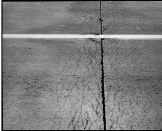
**Figura 15 Grieta de durabilidad de baja severidad**
