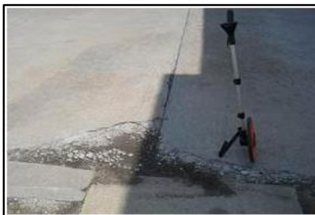
**Figura 51 Descascaramiento de esquina de alta severidad**
