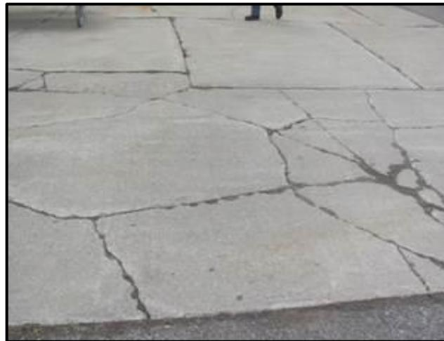
**Figura 14 Losa dividida de alta severidad**
