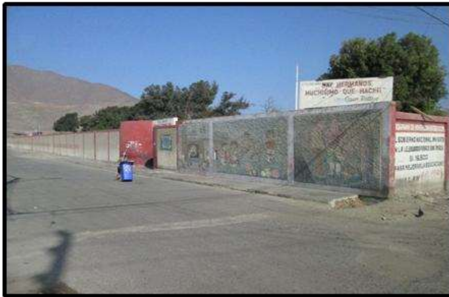
Fotografía 01 - Vista Panorámica exterior del cerco perimétrico de la Institución Educativa "Eduardo Ferrick Ring".
