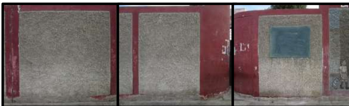
Fotografía 08 - Vista Panorámica de la Muestra 6 (Exterior) del Cerco Perimétrico de la Institución Educativa "Eduardo Ferrick Ring".
