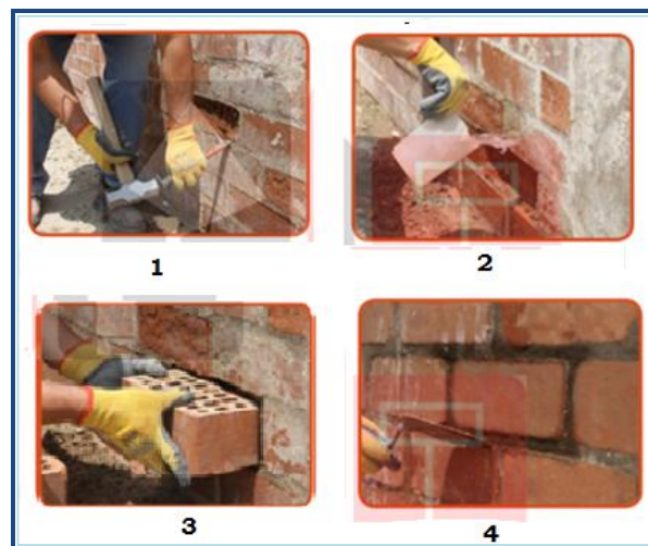
Figura 08. Reparación de muro con erosión
