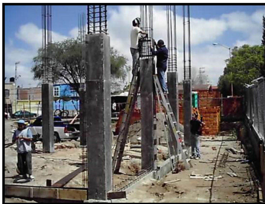
Figura 04. Imagen de columna
