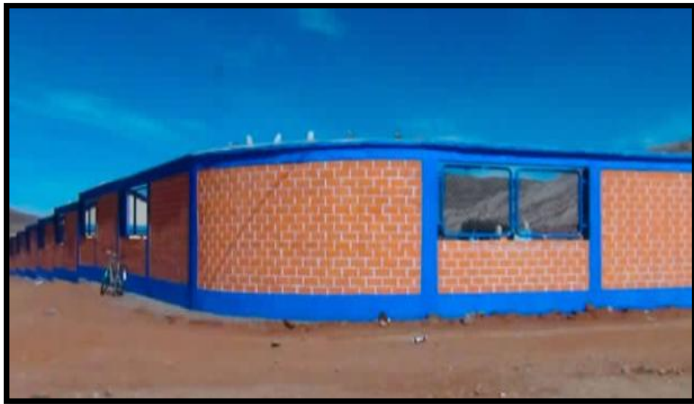
Figura 06. Imagen de cerco perimétrico
