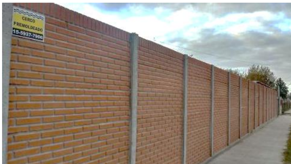
Figura 03. Imagen de muro
