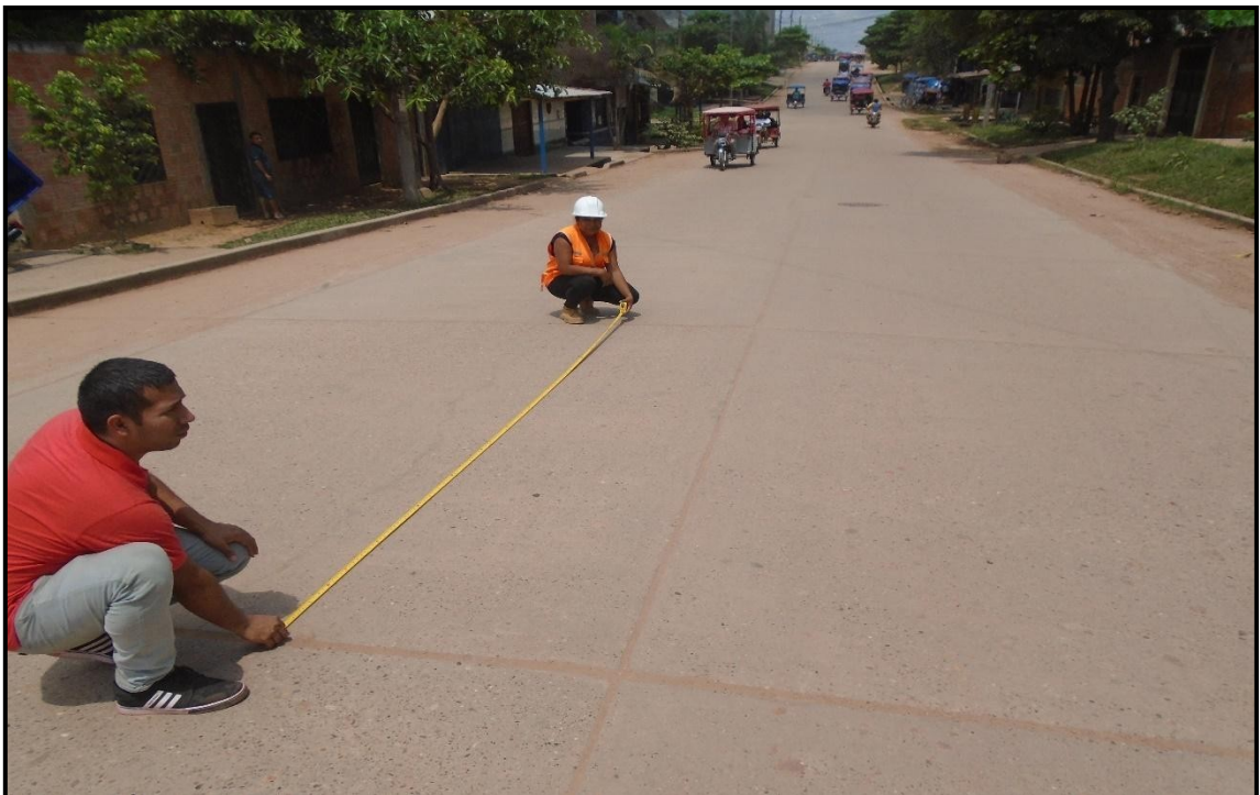
Figura 98: Vista daño Grieta Lineal de severidad Baja
