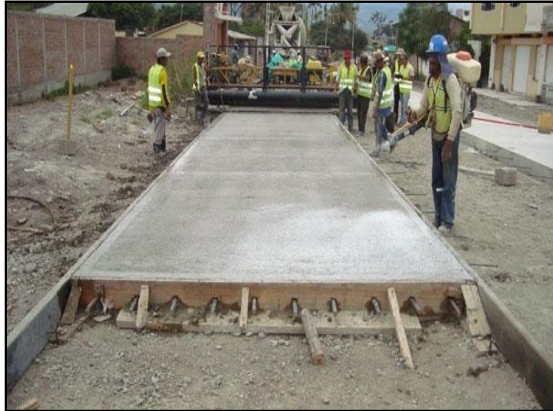
Figura 4: Esquema real de un pavimento rígido
