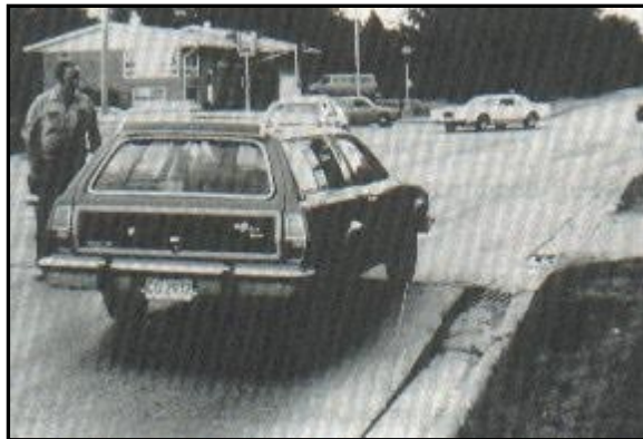
Figura 25: Falla por blowups-bickles de sereridad.
