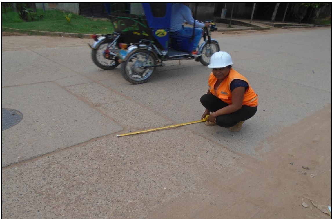
Figura 100: Vista daño Grieta Lineal severidad Baja
