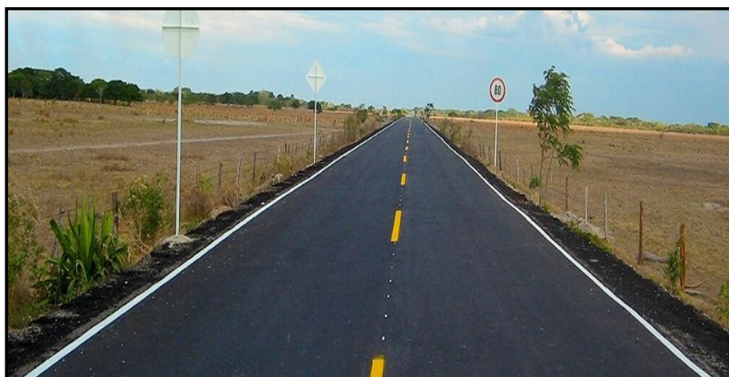
Figura 1: Pavimentos Flexibles - superficie bituminosa
