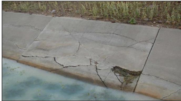
Figura 20: Fisuras como consecuencia de movimiento en el suelo de fundación.
