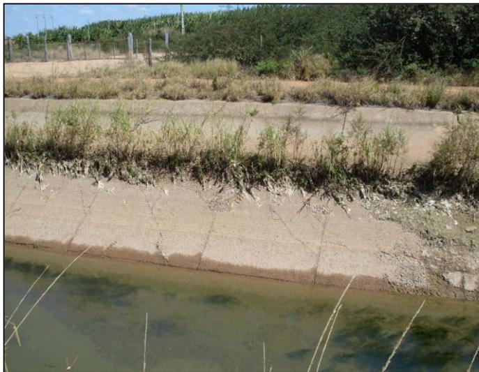
Figura 26: Crecimiento de vegetación en junta longitudinal.
