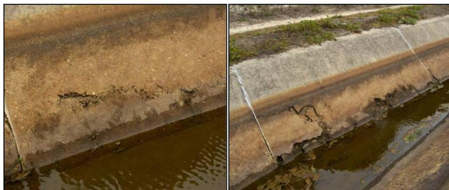
Figura 23: Degradación del revestimiento del concreto.
