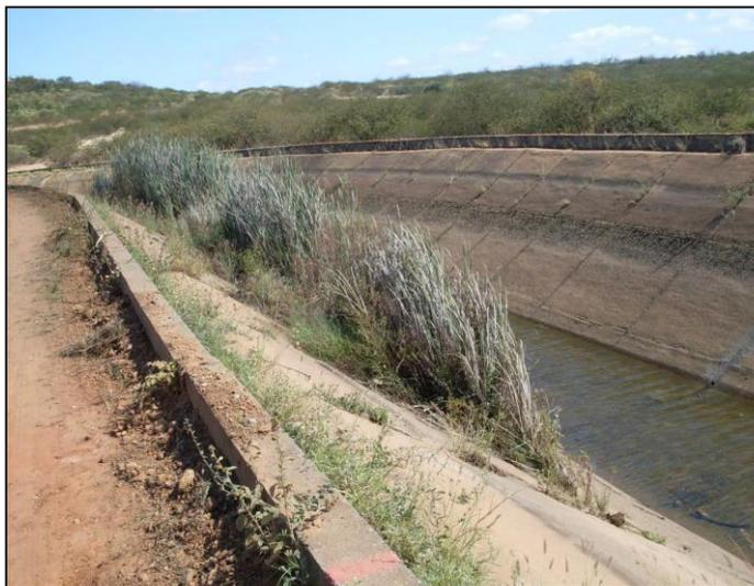
Figura 27: Crecimiento de vegetación de grandes dimensiones en talud.
