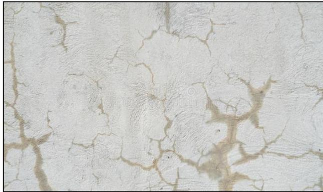
Figura 29: Resquebrajamiento de la superficie del concreto.
