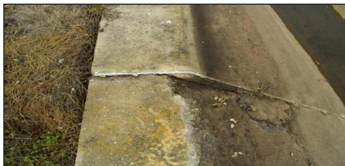
Figura 22: Desplazamiento de paneles en talud.
