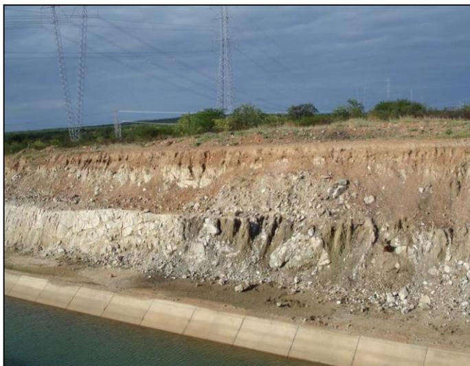
Figura 28: Procesos erosivos en talud de sección en corte profundo.
