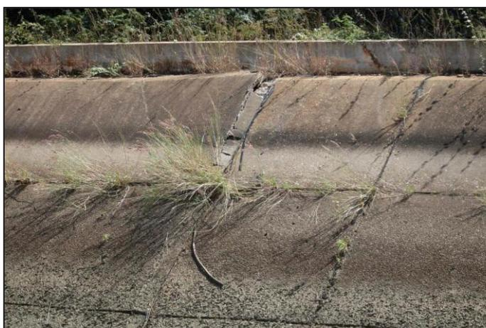
Figura 24: Aspecto de juntas con alto nivel de degradación.
