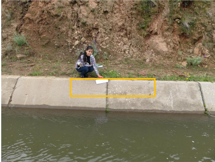
Fotografía 41: Fisuras longitudinales en dos paños de la unidad de muestra 49.
