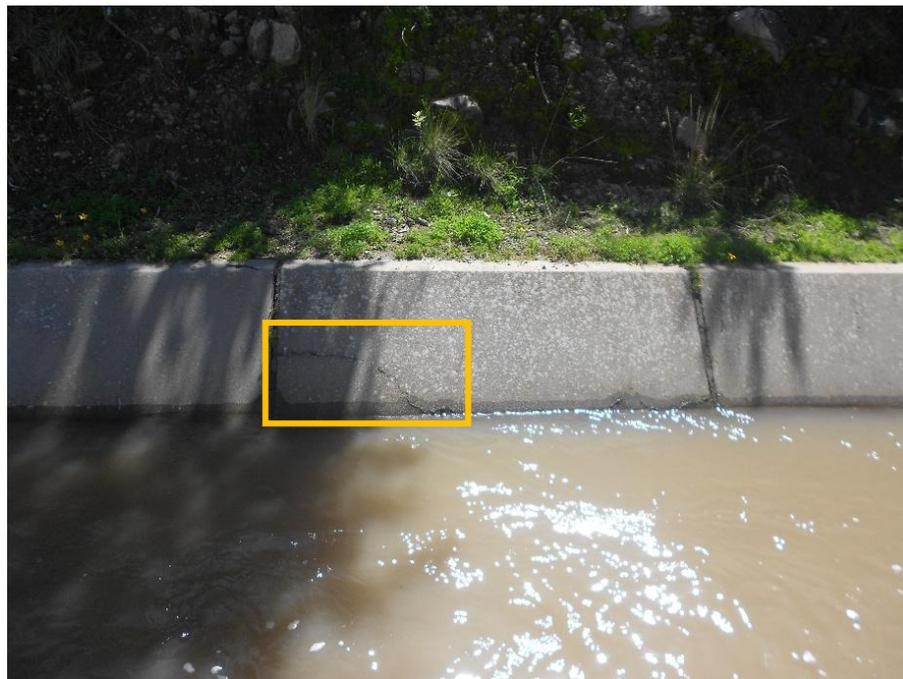
Fotografía 28: Fisuras de nivel de severidad moderado, en la unidad de muestra 32.
