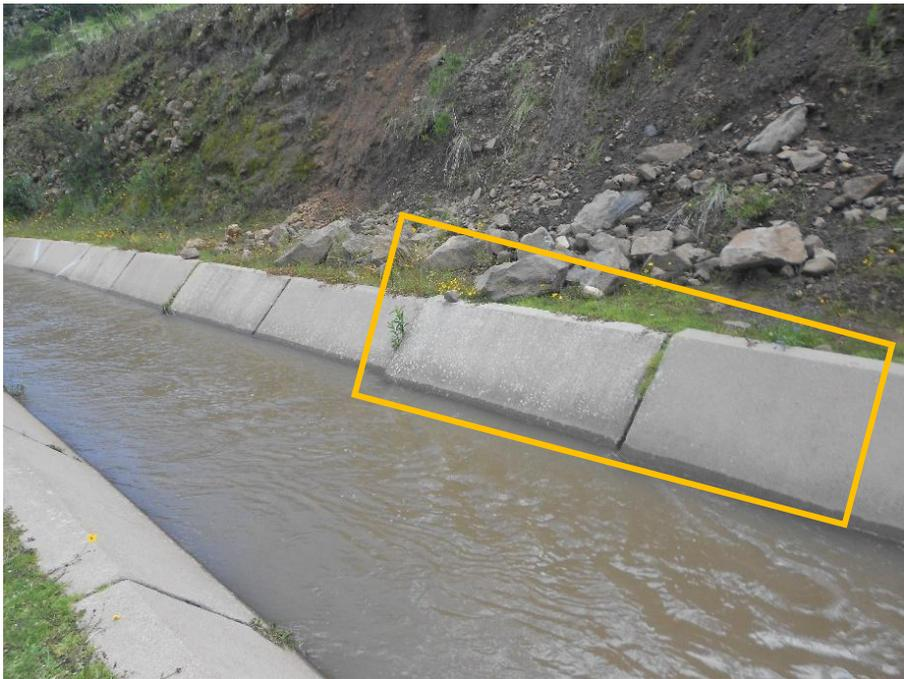
Fotografía 14: Desplazamiento de tres paneles, en la unidad de muestra 14.
