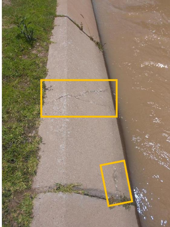
Fotografía 2: Fisuras de nivel de severidad moderado, en la unidad de muestra 6.
