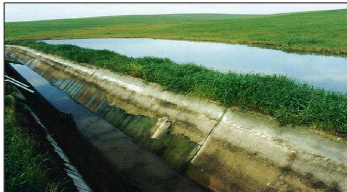
Figura 19: Fisuras en el revestimiento como consecuencia de la subpresión.
