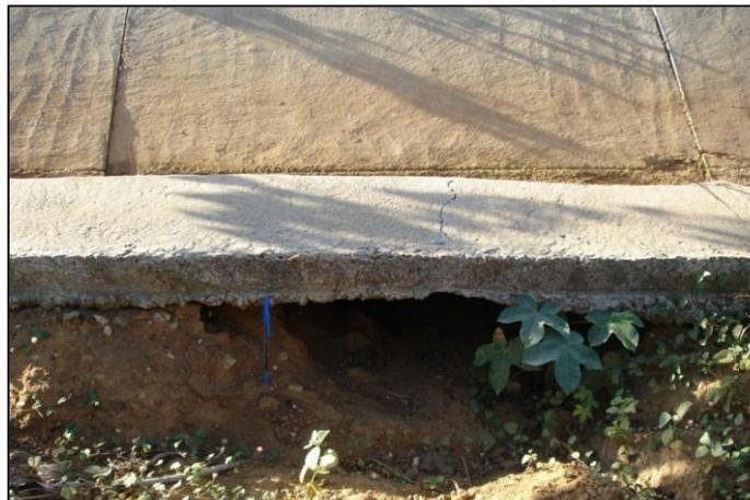
Figura 18: Cavidad de gran tamaño por detrás de revestimiento del concreto.
