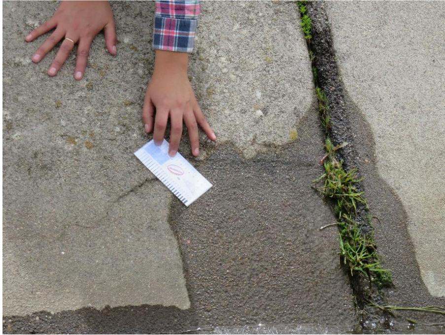
Fotografía 31: Fisuras en la unidad de muestra 37.
