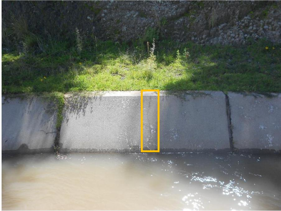
Fotografía 25: Microfisuras en la unidad de muestra 30.
