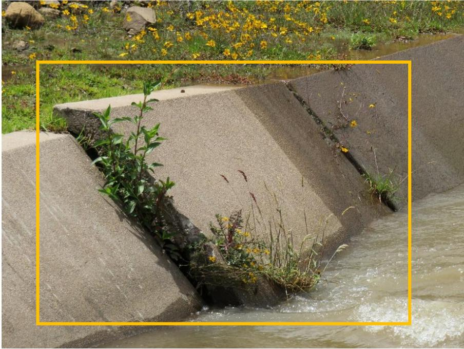
Fotografía 13: Desplazamiento de panel, nivel de severidad alto en la unidad de muestra 14.
