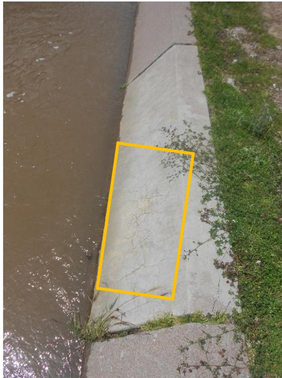
Fotografía 20: Resquebrajamiento de nivel de severidad leve, en la unidad de muestra 21.
