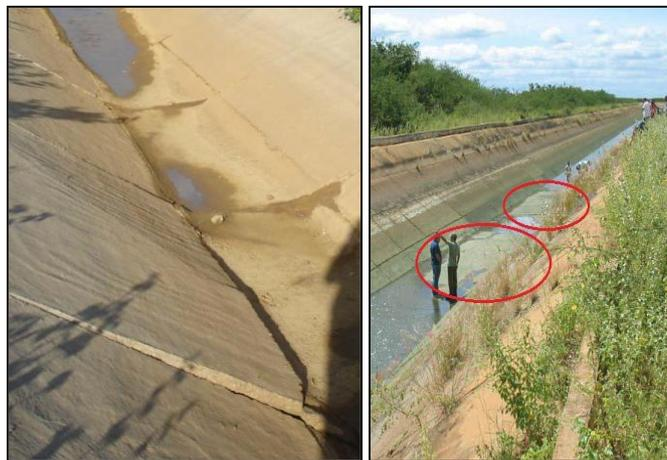
Figura 21: Desplazamiento de paneles causado por subpresión – talud.
