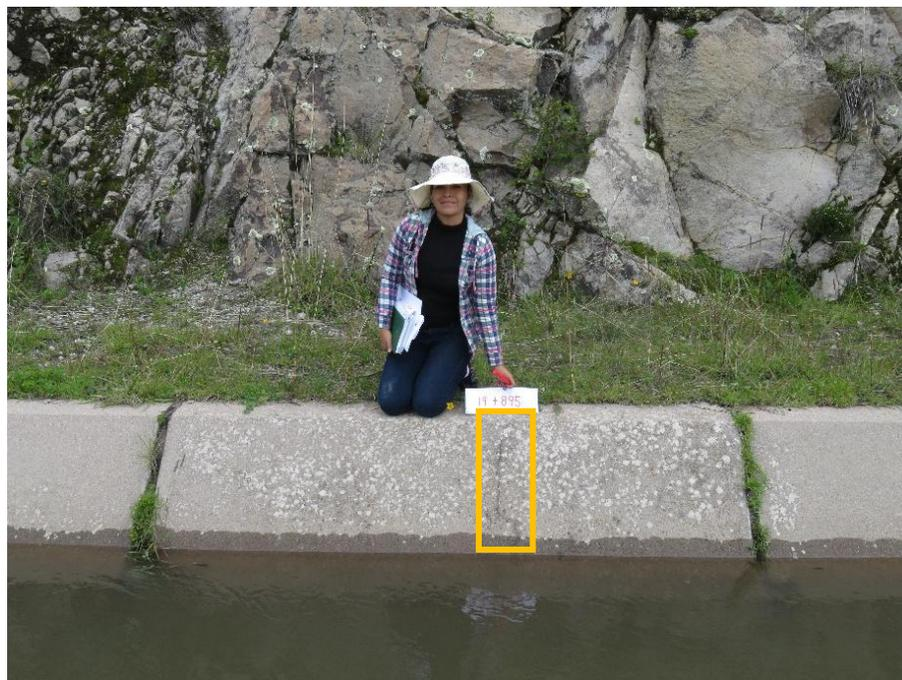
Fotografía 43: Presencia de fisuras en el km. 19+895, de la unidad de muestra 50.
