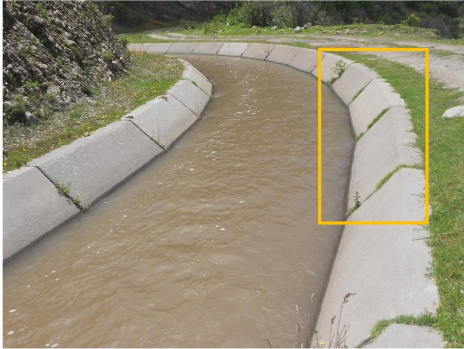
Fotografía 9: Presencia de vegetación en las juntas, de la unidad de muestra 12.
