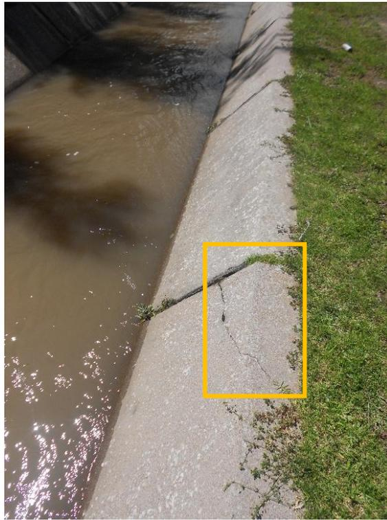
Fotografía 29: Fisuras en la unidad de muestra 33.
