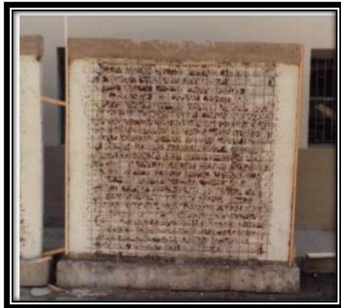
Imagen N°01: Preparación manual del muro
