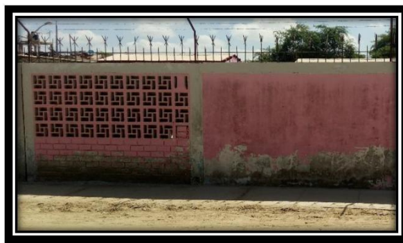
Fotografía N°04: Vista del tramo de la Muestra N°02 del cerco perimétrico de la Institución Educativa Inicial N°754”
