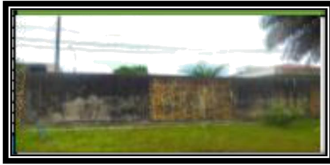
Imagen N°11: Cerco Perimétrico de la I.E 342
