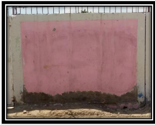
Fotografía N°09: Vista del tramo de la Muestra N°07 del cerco perimétrico de la Institución Educativa Inicial N°754”
