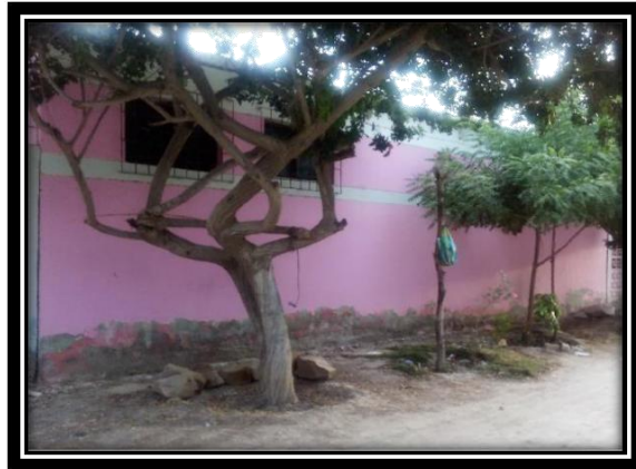
Fotografía N°18: Vista del tramo de la Muestra N°16 del cerco perimétrico de la Institución Educativa Inicial N°754”
