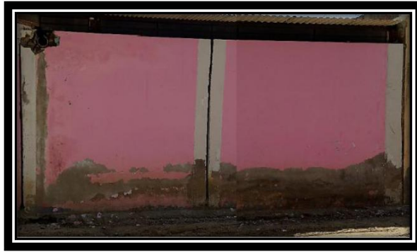
Fotografía N°12: Vista del tramo de la Muestra N°10 del cerco perimétrico de la Institución Educativa Inicial N°754”
