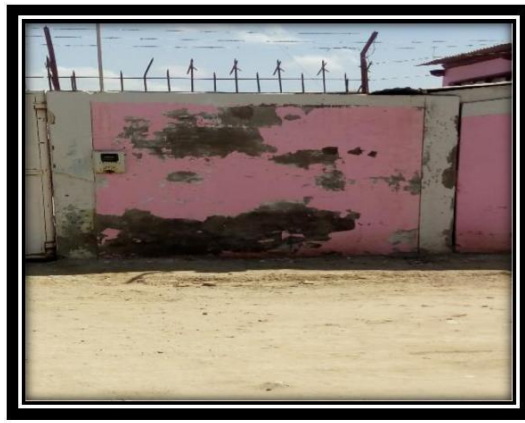
Fotografía N°10: Vista del tramo de la Muestra N°08 del cerco perimétrico de la Institución Educativa Inicial N°754”
