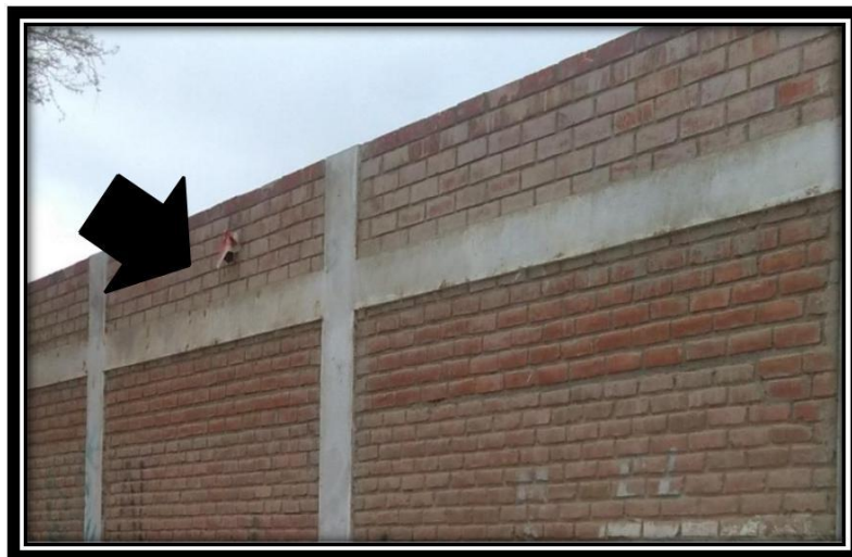
Imagen N°18: Viga solera
