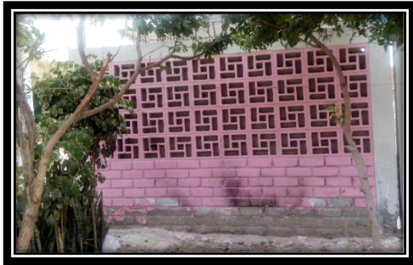
Fotografía N°21: Vista del tramo de la Muestra N°19 del cerco perimétrico de la Institución Educativa Inicial N°754”
