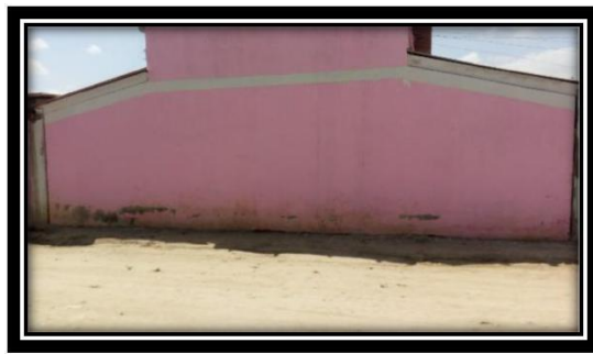
Fotografía N°11: Vista del tramo de la Muestra N°09 del cerco perimétrico de la Institución Educativa Inicial N°754”
