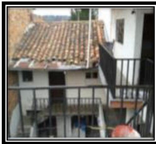
Imagen N°04: Cubierta de la vivienda Bermeo Alarcón
