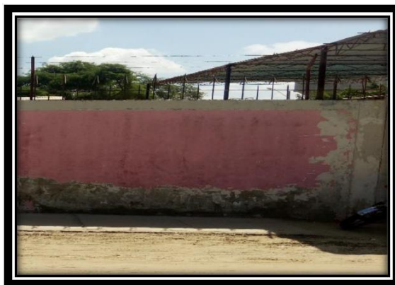
Fotografía N°03: Vista del tramo de la Muestra N°01 del cerco perimétrico de la Institución Educativa Inicial N°754”
