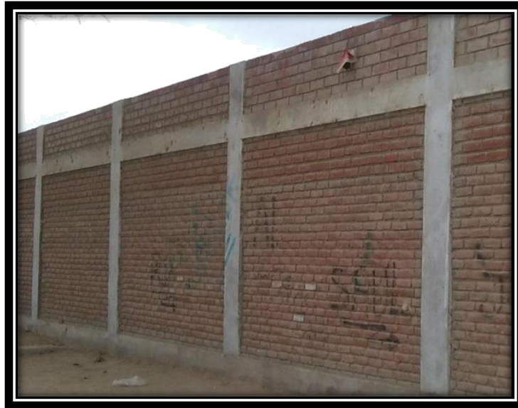
Imagen N°16: Cerco de albañilería confinada
