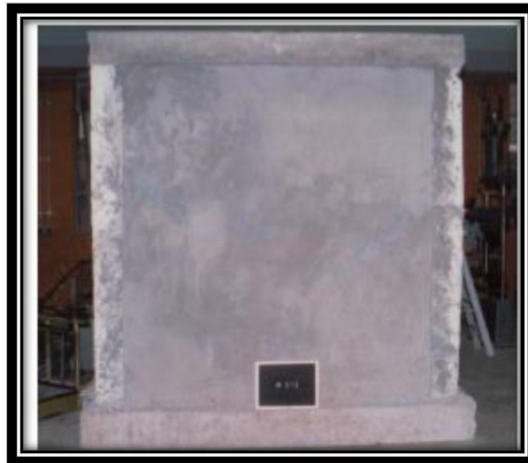
Imagen N°03: Cara frontal de muro reparado
