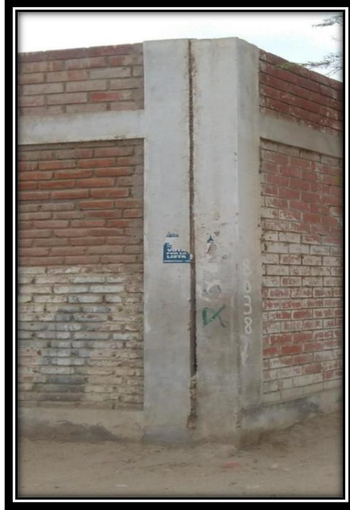
Imagen N°19: Columnas de confinamiento
