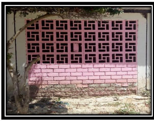
Fotografía N°16: Vista del tramo de la Muestra N°14 del cerco perimétrico de la Institución Educativa Inicial N°754”
