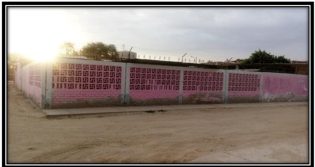
Fotografía N°02: Vista Este del cerco perimétrico de la Institución Educativa Inicial N°754”
