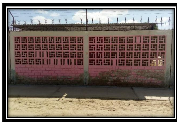
Fotografía N°05: Vista del tramo de la Muestra N°03 del cerco perimétrico de la Institución Educativa Inicial N°754”
