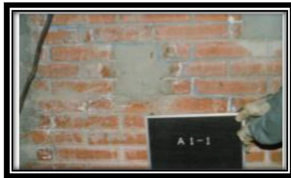
Imagen N°02: Taco de mortero reparado
