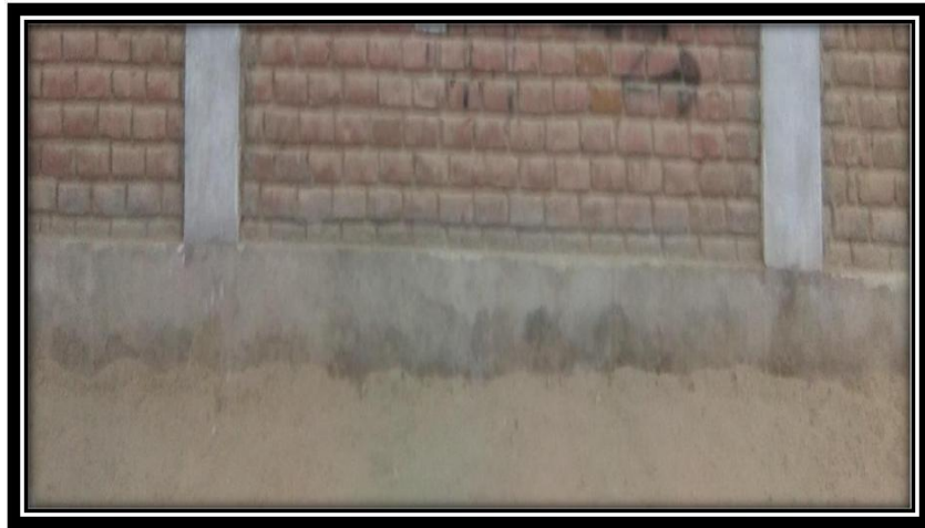
Imagen N°20: Sobrecimiento visible
