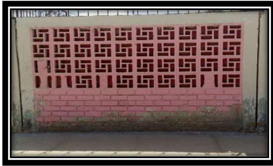
Fotografía N°06: Vista del tramo de la Muestra N°04 del cerco perimétrico de la Institución Educativa Inicial N°754”
