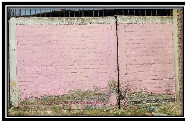
Fotografía N°13: Vista del tramo de la Muestra N°11 del cerco perimétrico de la Institución Educativa Inicial N°754”
