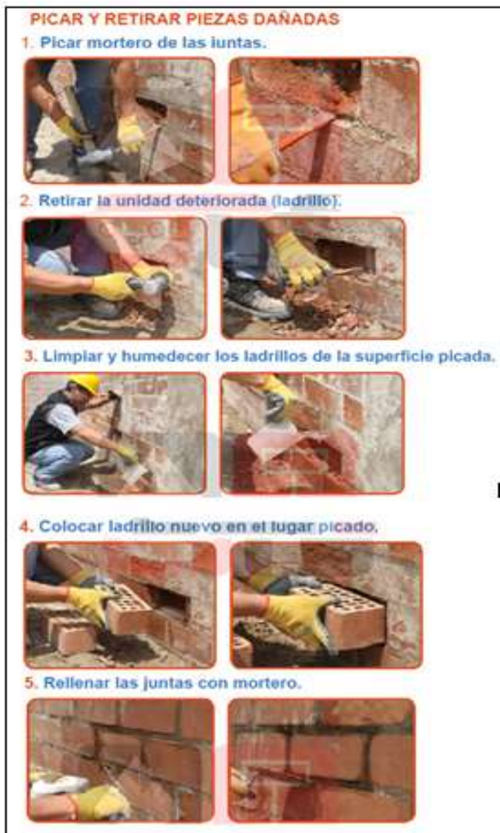
Figura 18. Reparación de muro con erosión.
