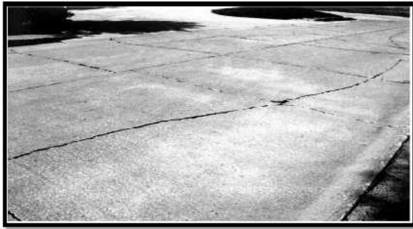
Figura 11. Losa dividida
