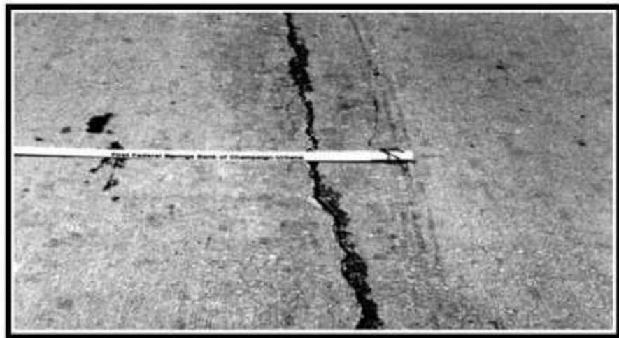
Figura 16. Grieta lineal
