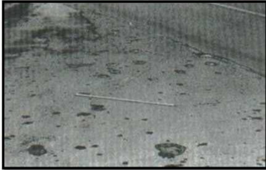
Figura 20. Desprendimiento
