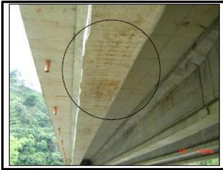
**Figura 109. Evidencia de manchas de óxido en la superficie del concreto.**
