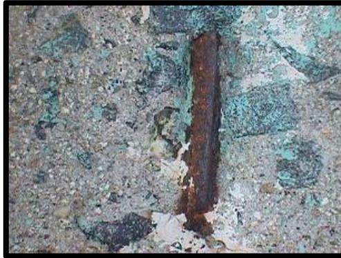
**Figura 104. Ataque de ácidos al concreto**
