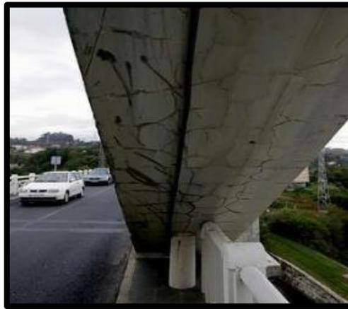
**Figura 90. Grietas en el concreto de un puente.**
