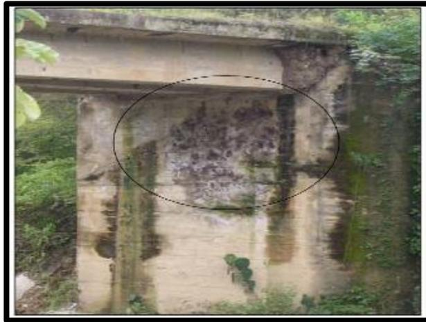
**Figura 68- Porosidad en el concreto en puentes**
