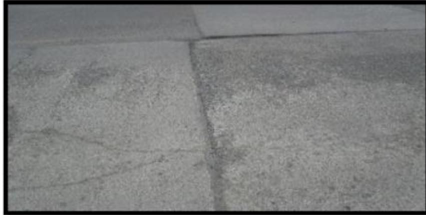
**Figura 76- Desgaste por abrasión en la losa del puente**
