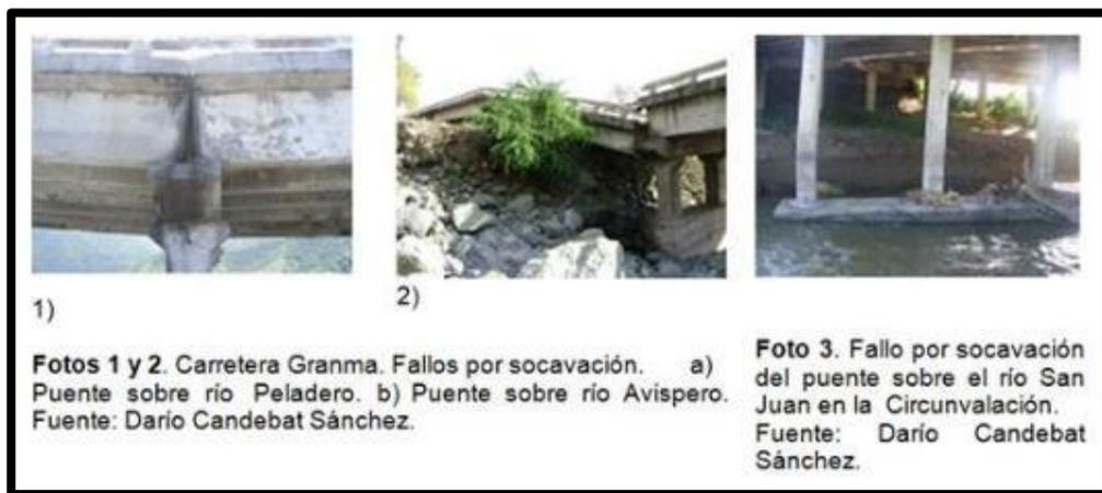
**Figura 72- Lesiones mecánicas de un puente**
