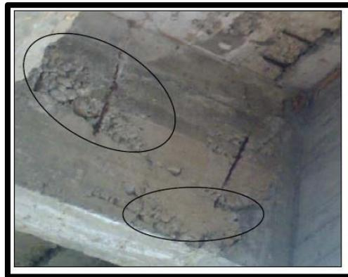
**Figura 106. Presencia de hormigueros en la viga cabezal**
