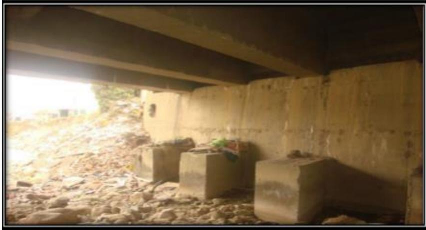
**Figura 10. Deterioro de los Estribos – Puente Confraternidad**
