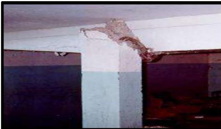
**Figura 77- Erosión por abrasión en las vigas**
