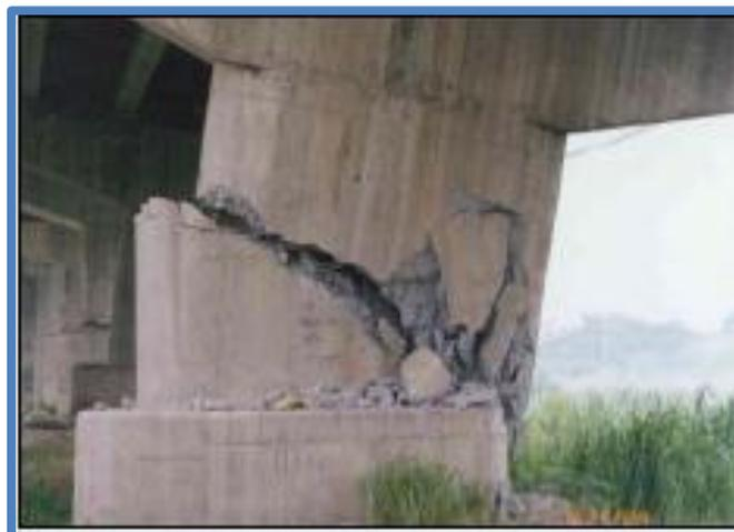
**Figura 84- Fractura por cortante en la Pila**
