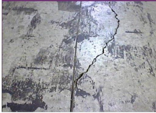
**Figura 86. Fisura por retracción hidráulica.**
