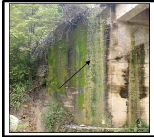
**Figura 113. Contaminación del concreto de las aletas de un Puente**
