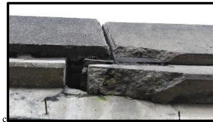
**Figura 73- Desprendimiento del concreto en las vigas.**
