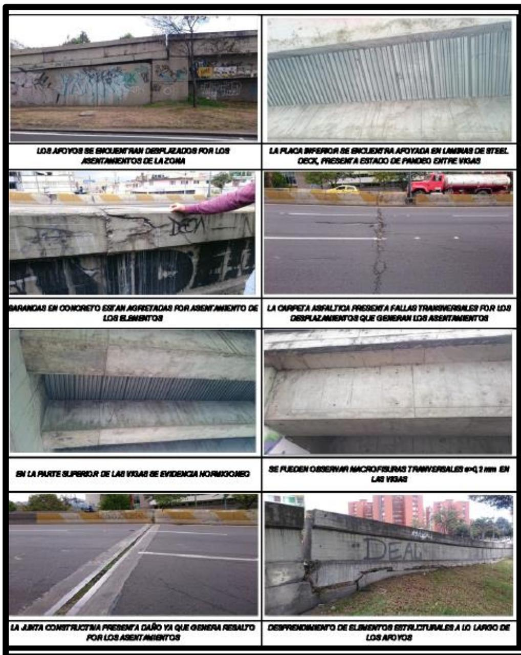
Figura 02. Daños en la estructura de los Puentes de la Localidad de Fontibón,
