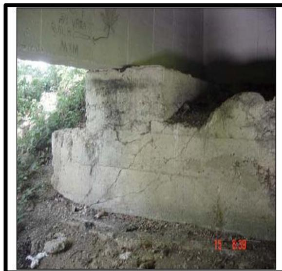
**Figura 89. Fracturas por aplastamiento en la viga de cimentación**
