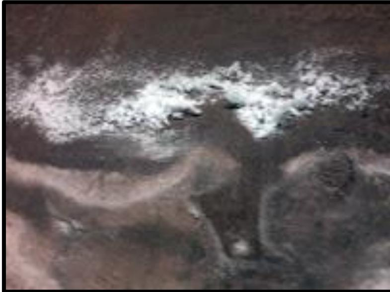
**Figura 108. Eflorescencia en el concreto**
