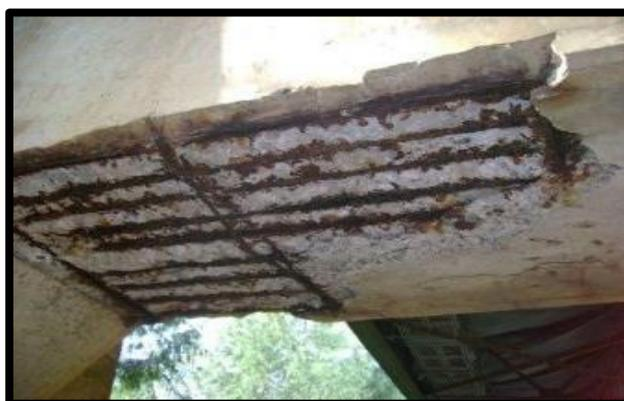
**Figura 111. Corrosión en el acero de refuerzo de las vigas**
