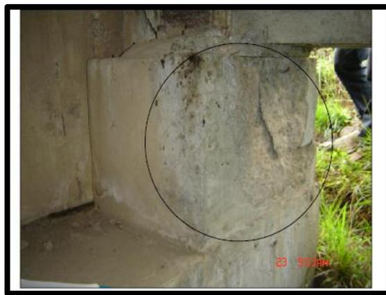
**Figura 88. Fractura por aplastamiento en el pedestal**
