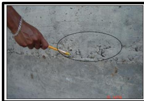
**Figura 105. Segregación en el concreto**
