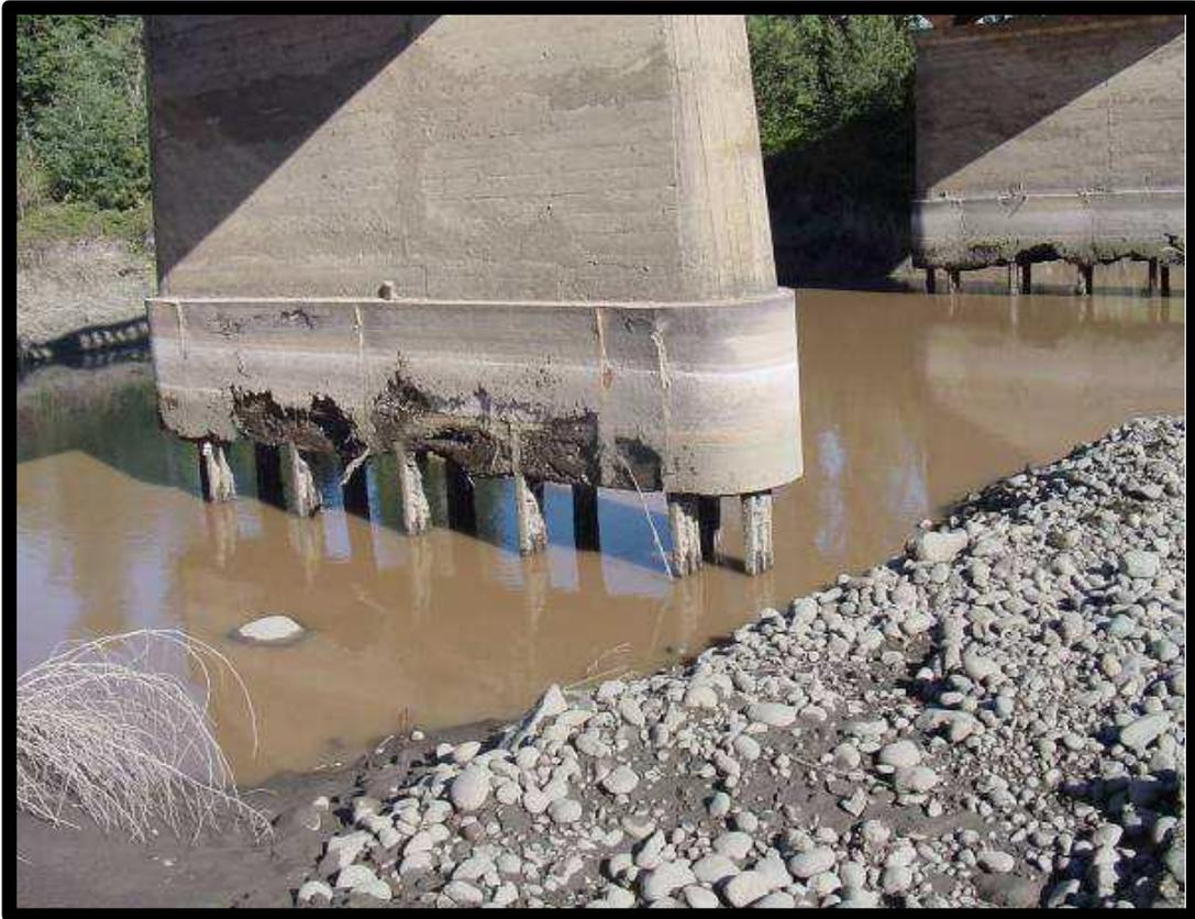
**Figura 04. Daños en las pilas centrales y laterales**
