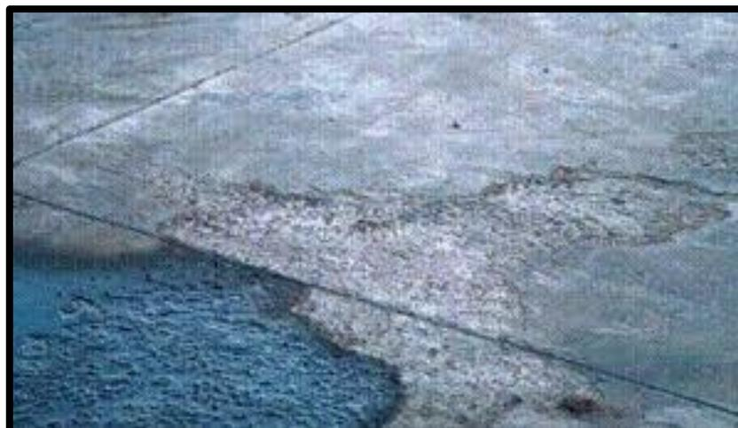
**Figura 102. Filtración en el concreto armado**
