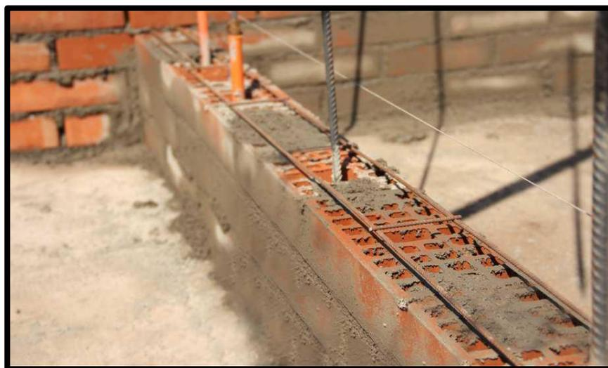
Figura 03. Imagen de albañilería armada
