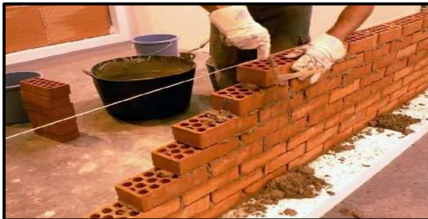
Figura 02. Albañilería simple
