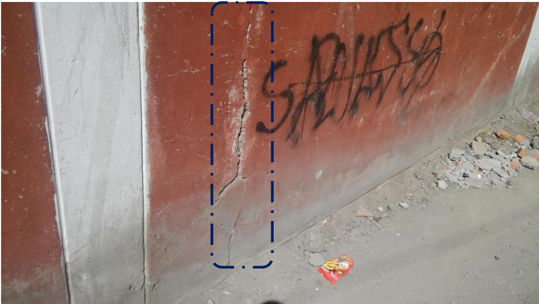
Figura 62: **Imagen de Fisura del muro** en varias unidades muestrales; identificar en los planos.
