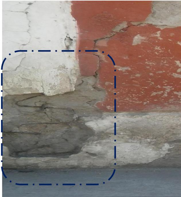
Figura 66: **Imagen de desprendimiento columna** en varias unidades muestrales; identificar en los planos.
