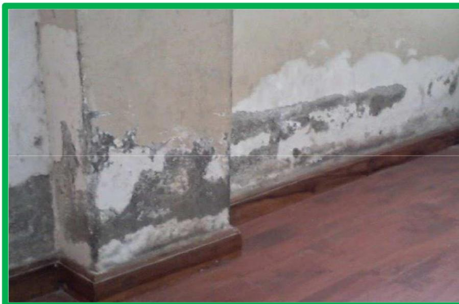
Figura 11. Imagen de eflorescencia en paredes.
