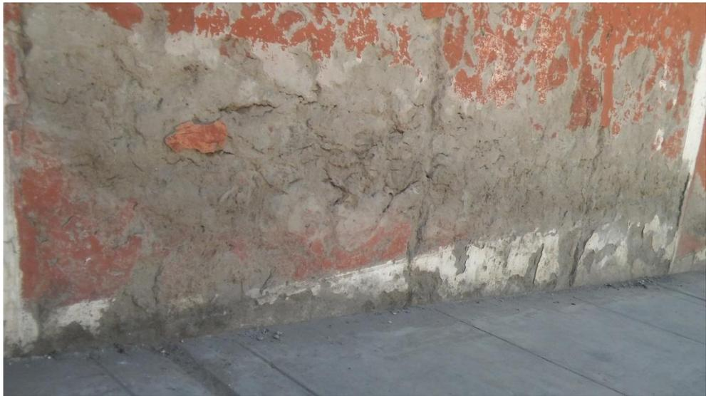
Figura 08. Imagen de erosión en paredes.
