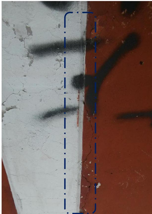
Figura 65: **Imagen de Fisura muro** en varias unidades muestrales; identificar en los planos.
