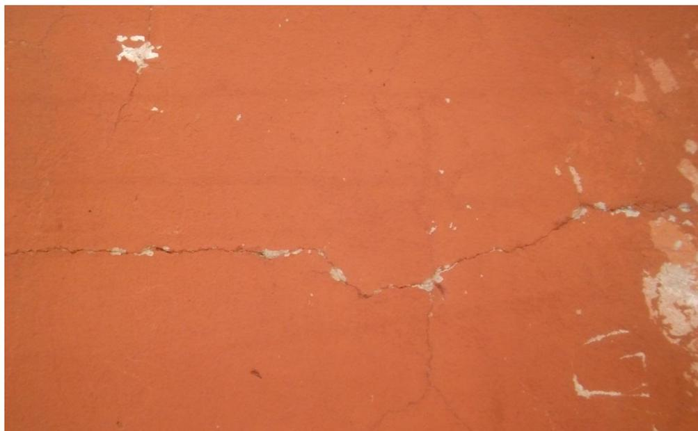
Figura 15. Imagen de fisura en muro.
