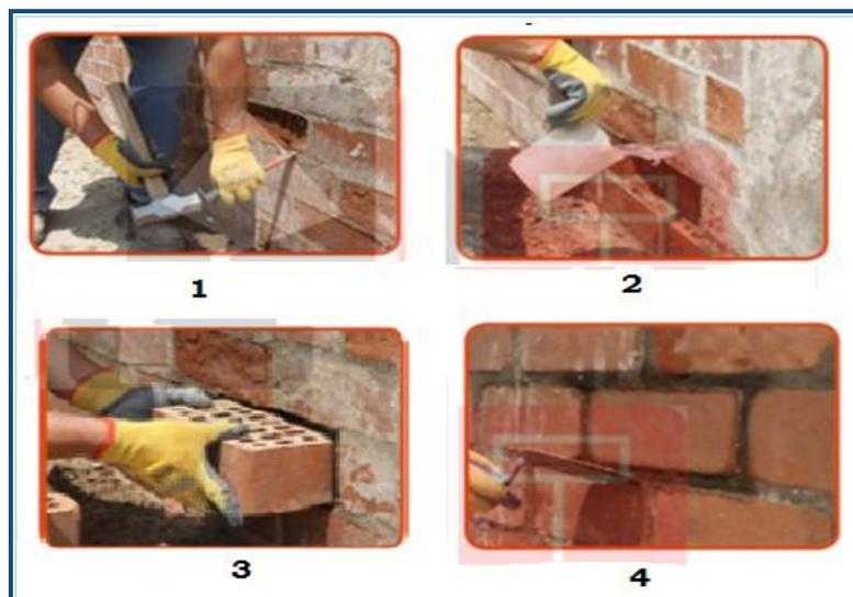
Figura 09. Reparación de muro con erosión.
