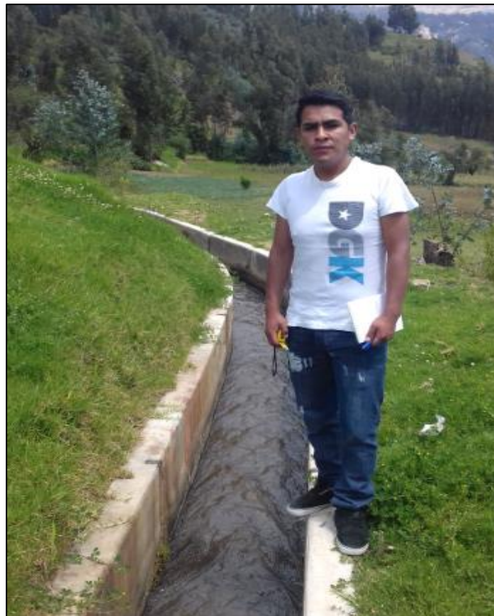
Imagen 10: Vista del canal Lucma progresivas 1+000-2+000, punto de partida
