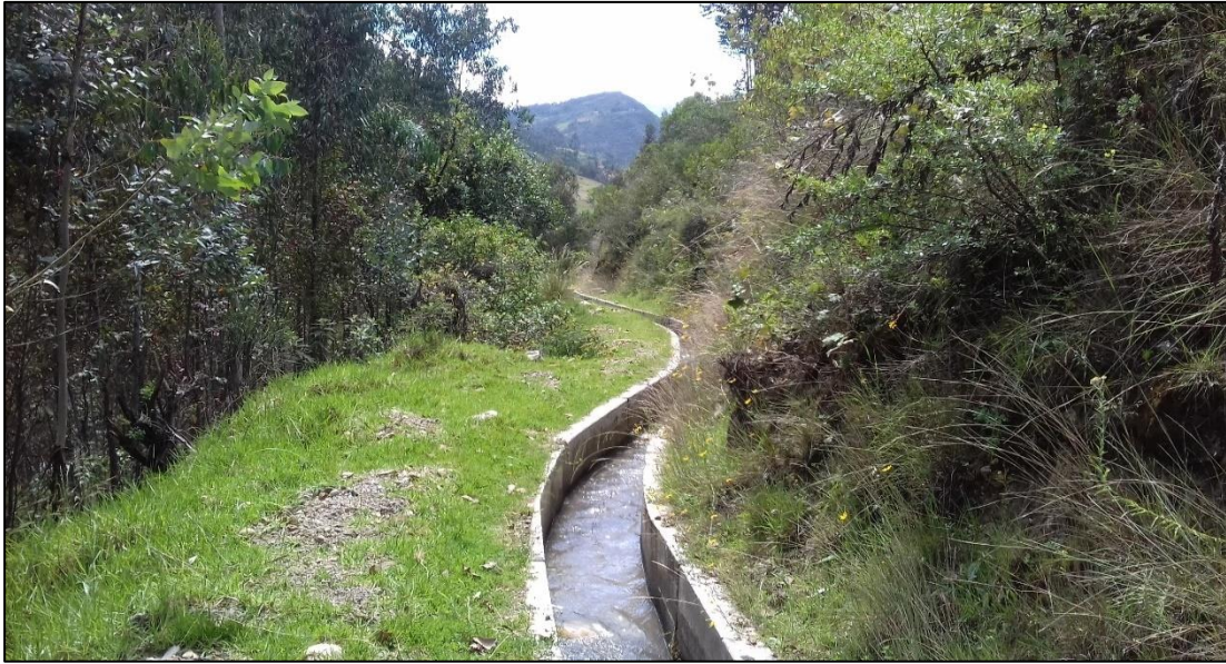
Imagen 09: Vista panorámica del canal de riego Lucma.
