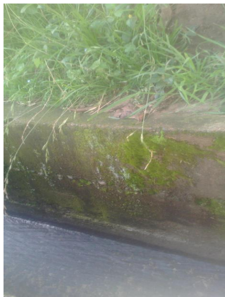
Imagen 14- Vegetación en canales
