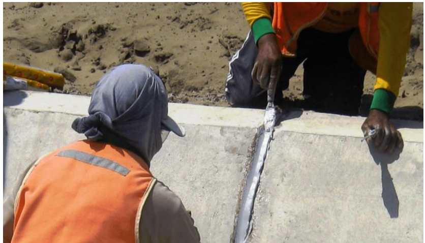
Imagen 15- Sello de junta en el canal
