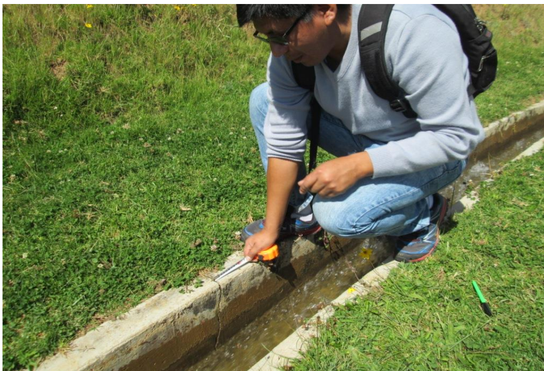
Inspección de patologías y toma de datos
