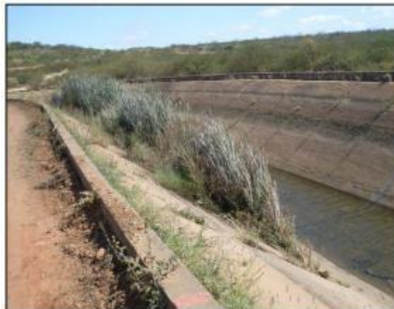
Figura 13: Crecimiento de vegetación acuática en el fondo del canal.
