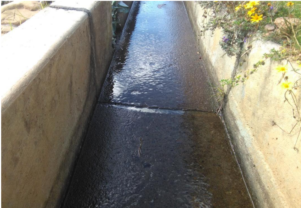
En esta fotografía se puede apreciar la patología hundimiento una severidad moderada.
