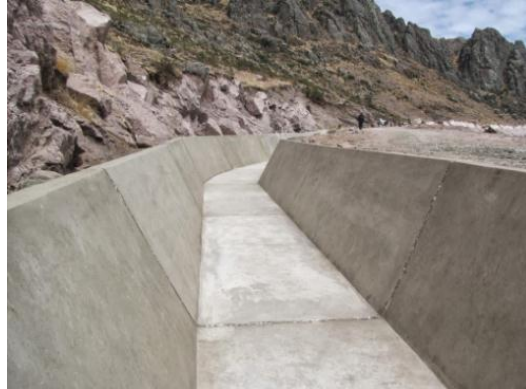
Figura 8: concreto en canal.
