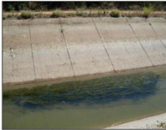
Figura 13: Crecimiento de vegetación acuática en el fondo del canal.
