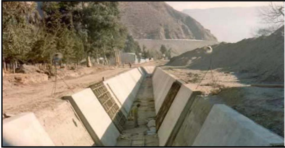
*Figura 6: Canal artificial de Secciones transversales trapecial*
