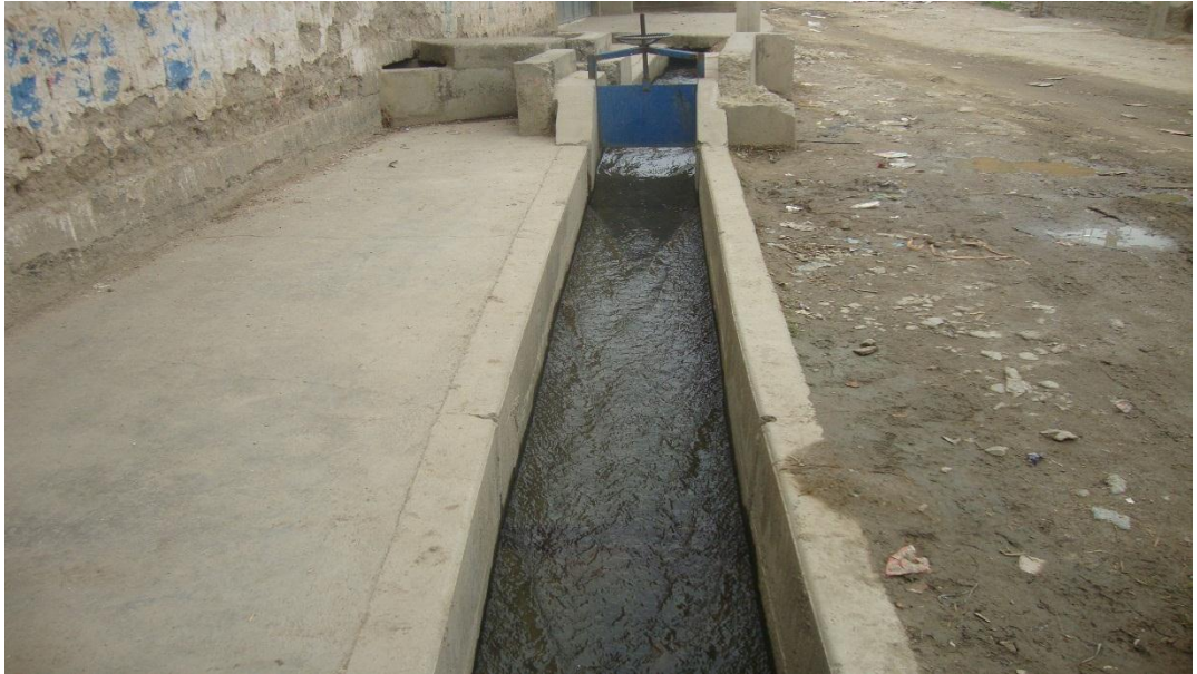
FOTO N° 02: Fotografía del Canal “Chahua Ruri” al margen izquierda derecha se visualiza eflorescencia.
