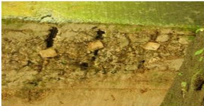
Figura 12. Refuerzo expuesto, descascaramiento
