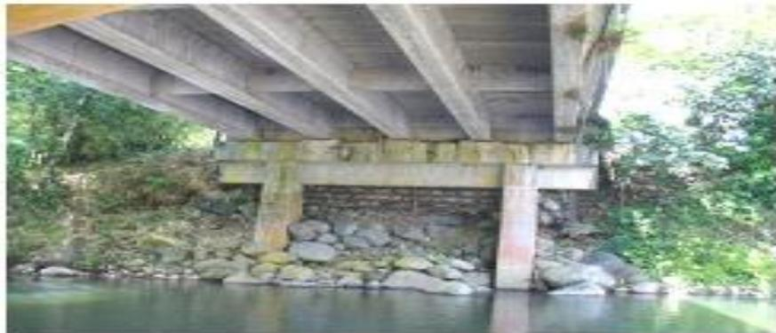
Figura 14. Socavación en la Fundación.
