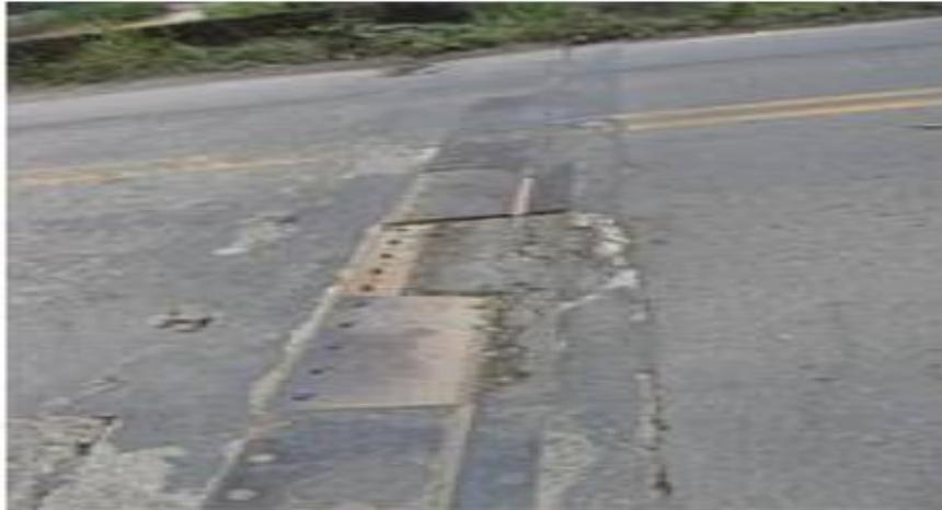
Figura 10. Faltante o deformación de la junta de expansión
