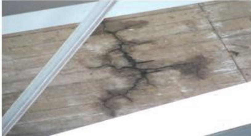
Figura 11. Grietas en dos direcciones de losa del puente
