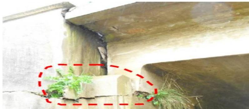
Figura 15. grietas y fisuras del puente
