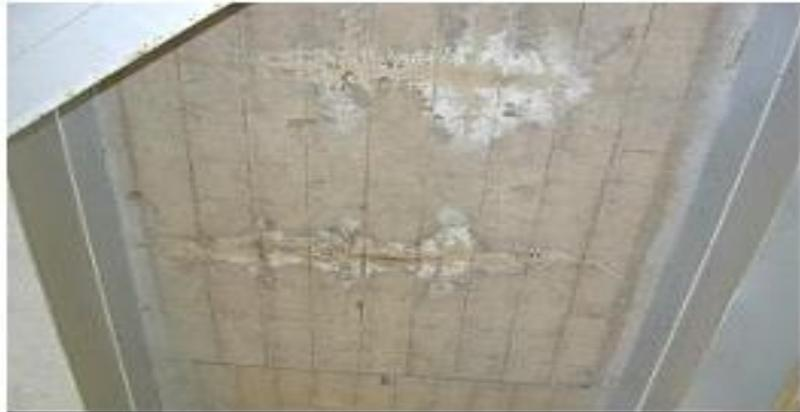
Figura 13. Eflorescencia debajo de la losa de concreto
