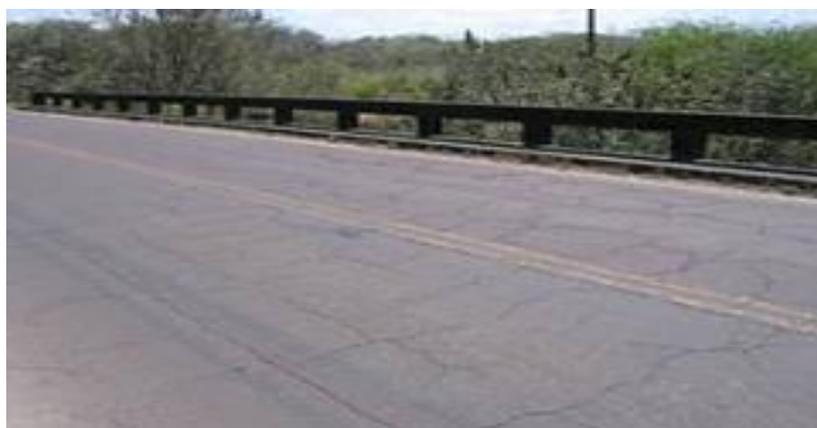
Figura 7. Grietas de la Capa Asfáltica.
