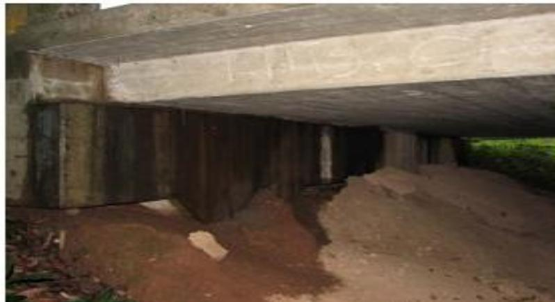
Figura 9. Filtración de agua por la junta de expansión
