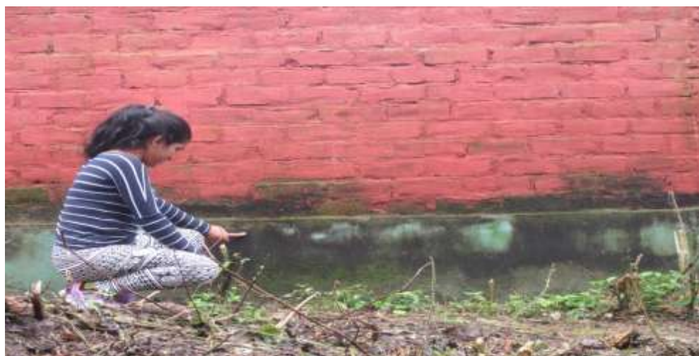
Gráfico 113: Humedad y moho en el sobrecimiento del cerco perimétrico. Fuente: Elaboración propia.
