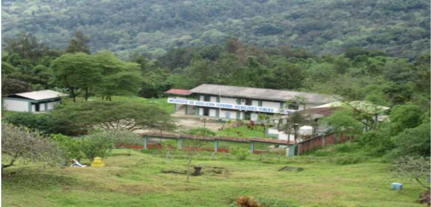
Gráfico 111: Vista panorámica del Instituto de Educación Superior Tecnológico-Canchaque-Huancabamba-Piura. Fuente: Elaboración propia.
