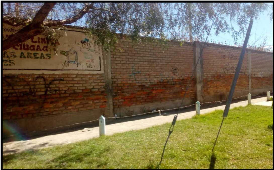
Fotografía 06: vista panorámica del cerco perimétrico de la I.E. publica 38928 barrio San Melchor San Juan Bautista – Huamanga.
