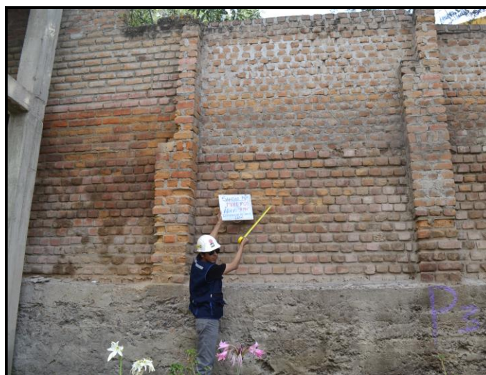
Imagen 16. Muro no portante. Fuente: Elaboración propia (2018).
