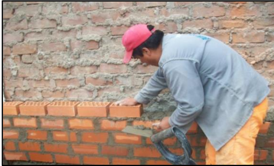
Imagen 5. Albañilería. Fuente: (Zambrano R.2009).
