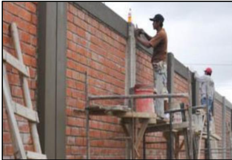
Imagen 8. Albañilería Confinada. Fuente: (Guipúzcoa I 2011)
