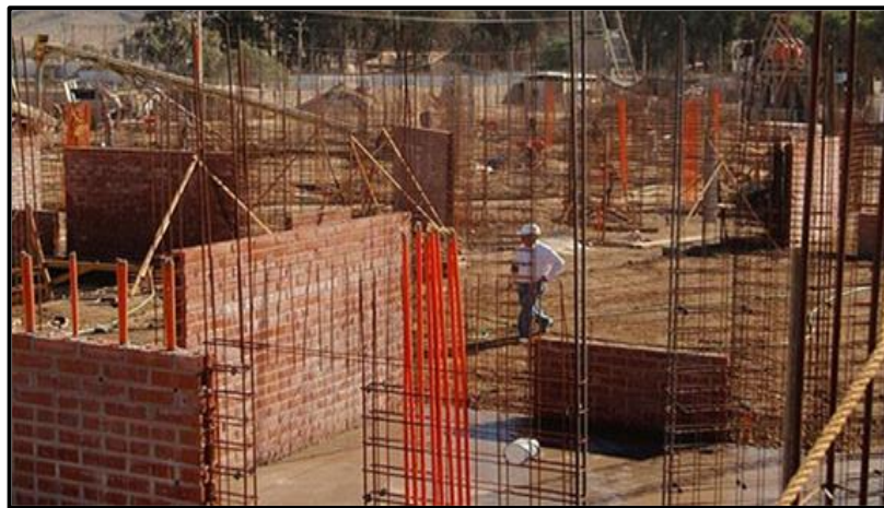
Imagen 7. Albañilería Armada. Fuente: (Guipúzcoa I 2011)
