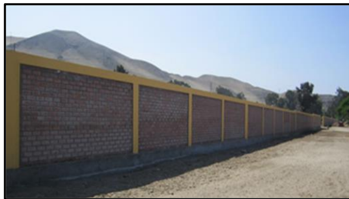
Imagen 14. Cerco perimétrico de albañilería confinada. Fuente: Elaboración Propia (2018).
