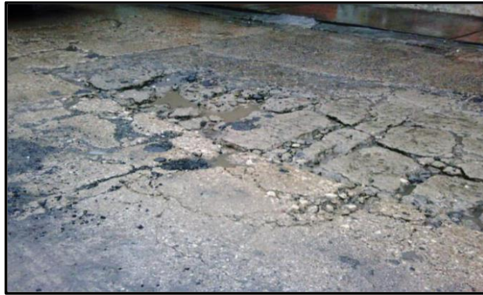
Imagen 20. Desintegración. Fuente: (Vivar M.2015)
