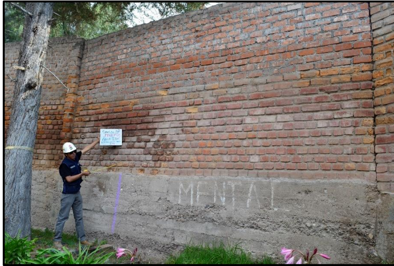
Imagen 6. Albañilería simple. Fuente: Elaboración propia (2018).
