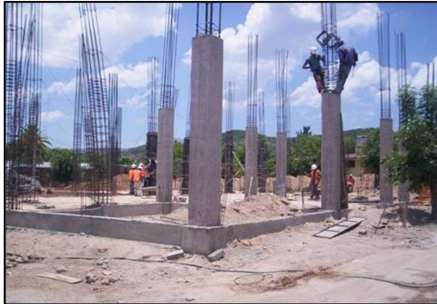
Imagen 11. Columna de Concreto. Fuente: (Fernández M 2011)
