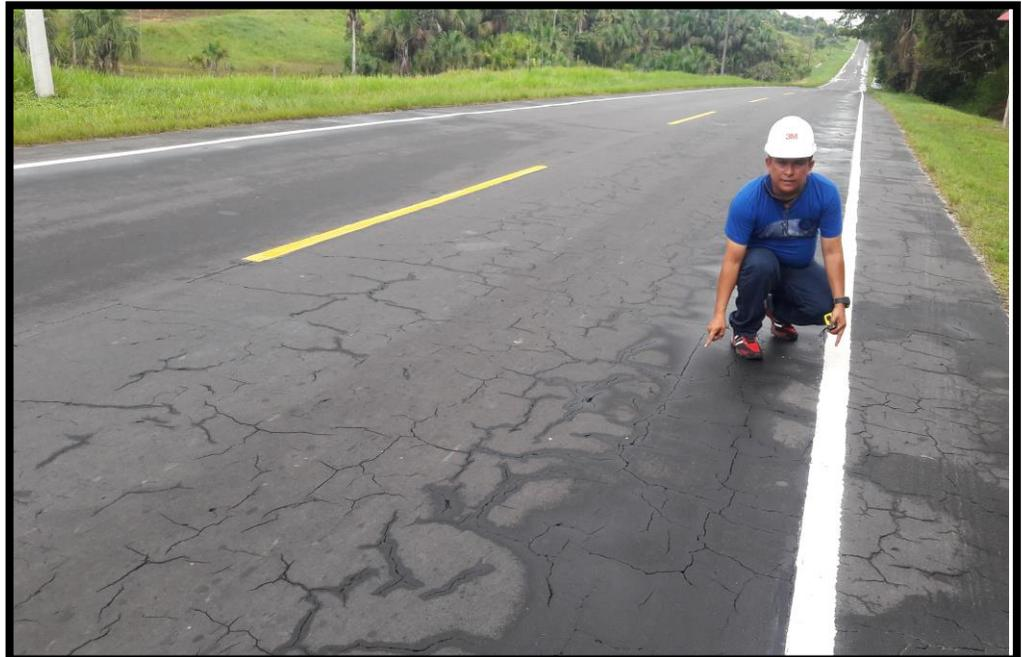
**se observa Agrietamiento de bloque moderado.**
