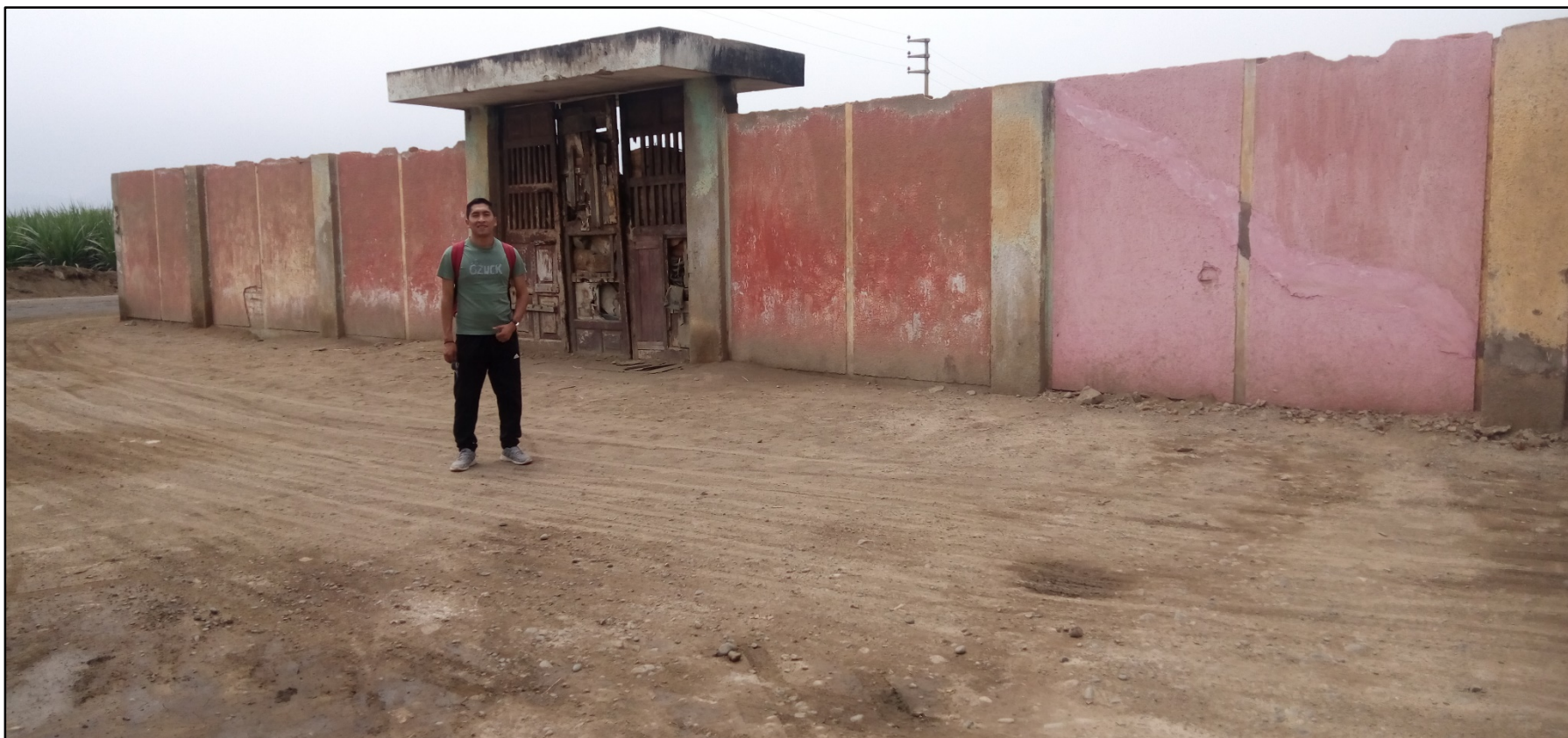
Fotografía 4: Tramo P6-P7 del cerco perimétrico de la I. E. 20502 César Vallejo en el asentamiento humano Las Delicias.
