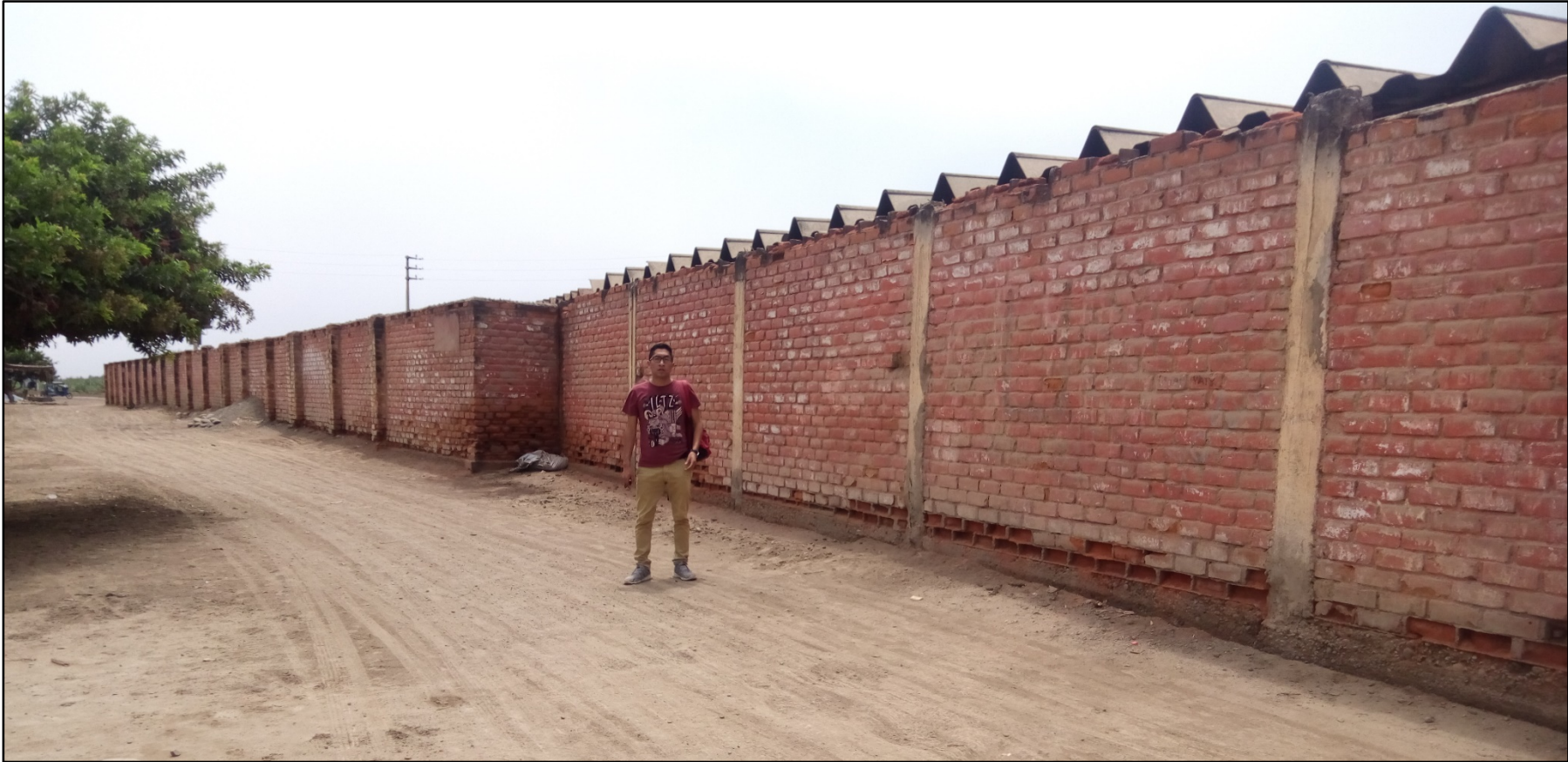
Fotografía 3: Tramo P4-P5 y P5-P6 del cerco perimétrico de la I. E. 20502 César Vallejo en el asentamiento humano Las Delicias.
