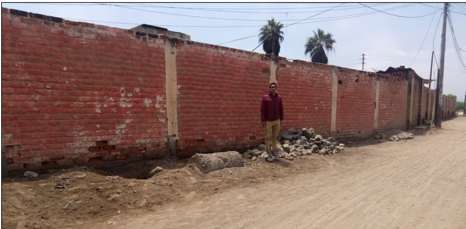
Fotografía 2: Tramo P2-P3 y P3-P4 del cerco perimétrico de la I. E. 20502 César Vallejo en el asentamiento humano Las Delicias.
