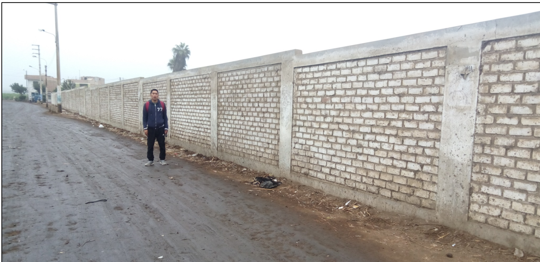
Fotografía 5: Tramo P7-P1 del cerco perimétrico de la I. E. 20502 César Vallejo en el asentamiento humano Las Delicias.
