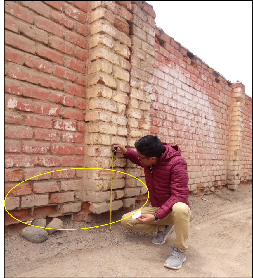
Fotografía 7: Medición del área afectada por erosión (físico-química) en la estructura de albañilería simple del cerco perimétrico de la UM-14.
