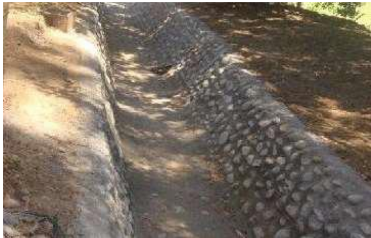
Imagen 04: Canal revestido con mampostería de piedra.
