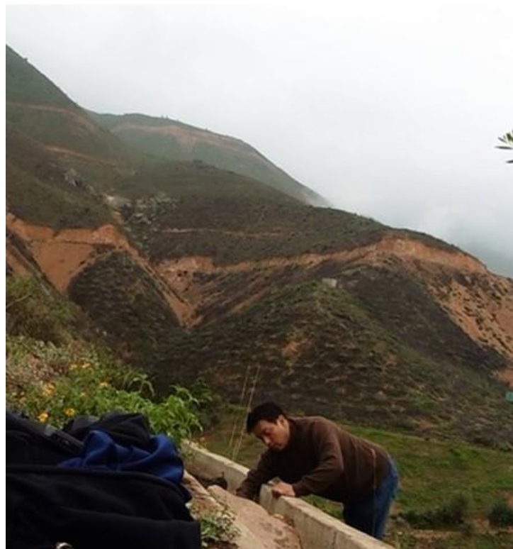
Fotografía 5: Tierras agrícolas que se encuentran bajo riego por el canal Ampip-San Isidro entre las progresivas 0+500 – 1+000.
