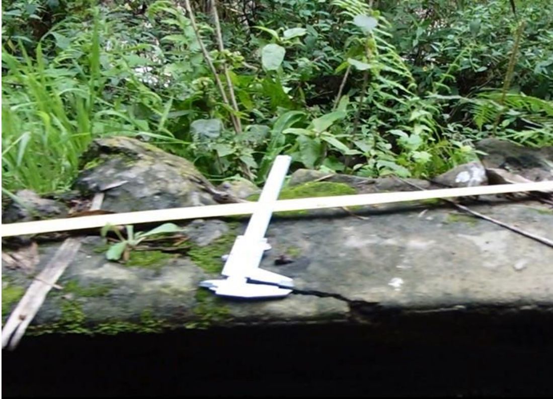
Fotografía 4: Herramientas usados para registrar los datos en las respectivas fichas técnicas de evaluación, de canal Ampip-San Isidro entre las progresivas 0+500 – 1+000.
