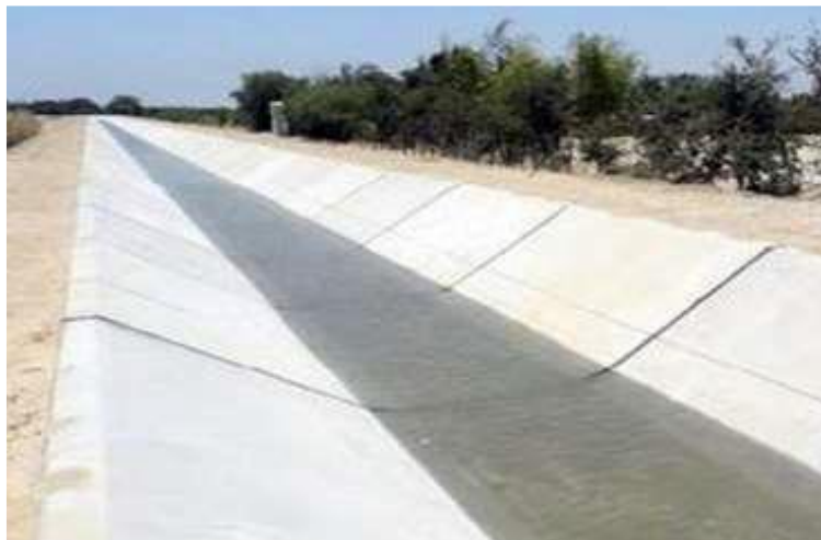
Imagen 05: Canal revestido de concreto.
