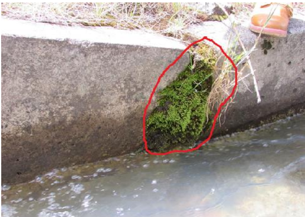
Figura 125: Identificación de patología fisura en el margen derecho del canal.
