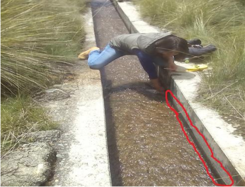
Figura 123: Identificación de patología erosión del margen derecho.
