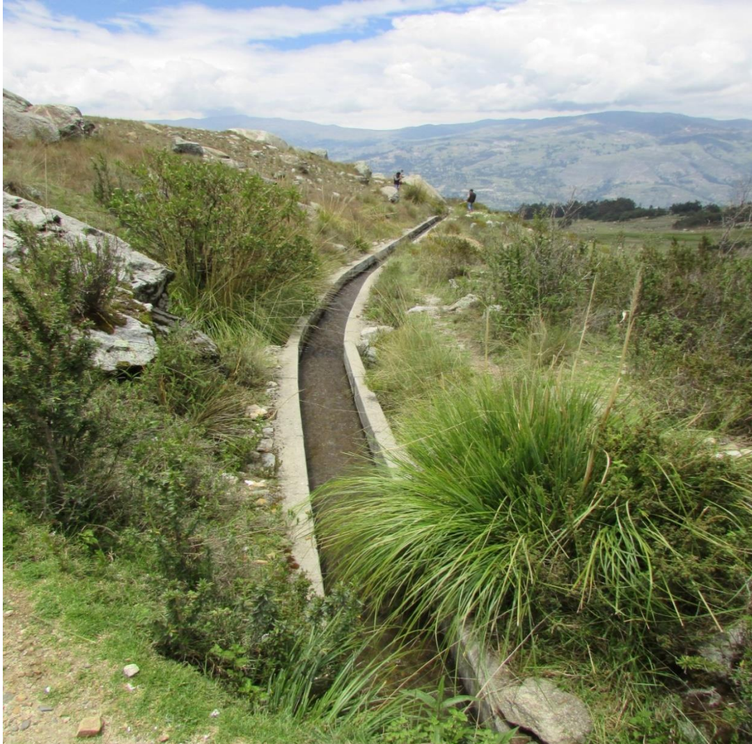
Figura 117: Panorámica del canal de Yurac Yacu
