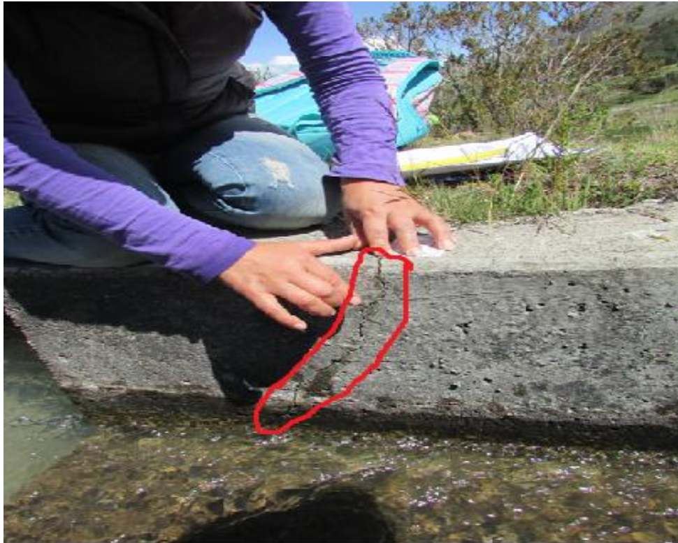
Figura 125: Identificación de patología fisura en el margen derecho del canal.
