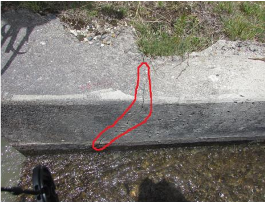
Figura 123: Identificación de patología erosión del margen derecho.
