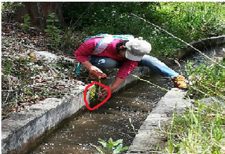
Figura 121: Identificación de patología grieta canal Yurac Yacu margen izquierdo.
