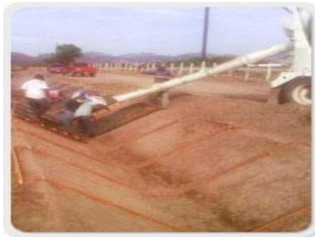
Figura 5: Revestimiento canal de concreto
