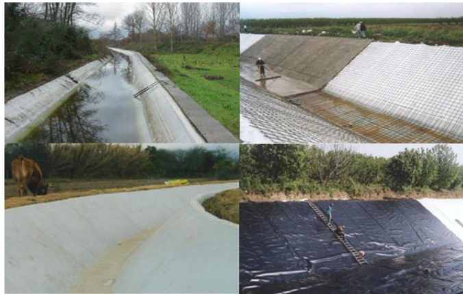
Figura 4: Reducción de pérdidas por filtración.
