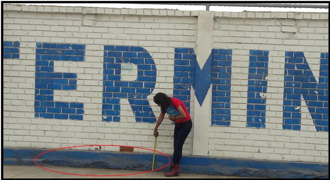
Fotografía 06: Vista donde el sobrecimiento es afectado por erosión de la unidad de la muestra 02 del cerco perimétrico del Terminal Portuario Supe.
