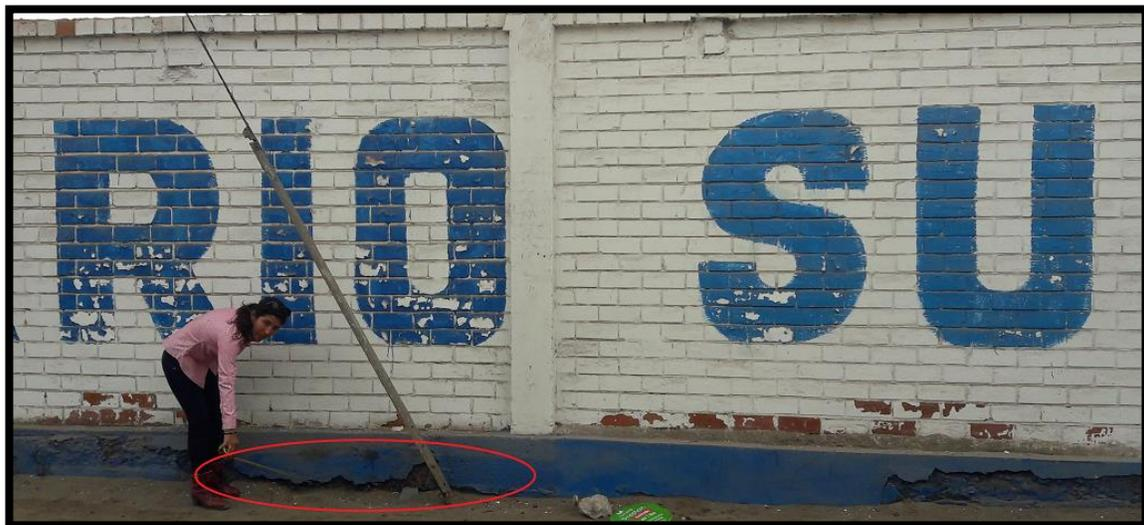
Fotografía 08: se realiza la medición de profundidad de la zona afectada por erosión del sobrecimiento de la unidad de la muestra 03 del cerco perimétrico del Terminal Portuario Supe.
