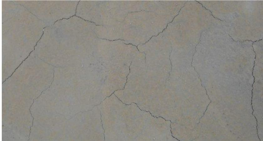
*Imagen 4.* Recubrimiento del muro afectada por la patología tipo Fisura.
