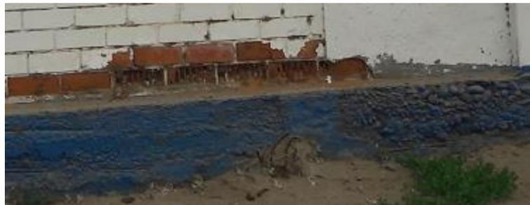
**Imagen 1.** Muro y sobrecimiento de albañilería afectada por la patología tipo erosión.
