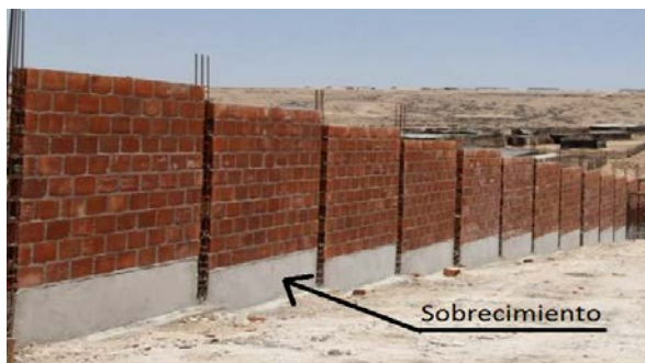
Figura 11. Sobrecimientos de concreto simple.
