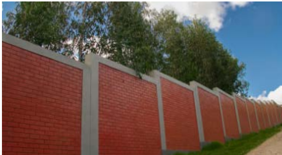
Figura 13. Cerco perimétrico de albañilería confinada.
