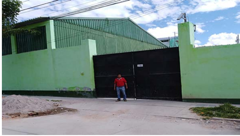
Fotografía 22: Vista de fachada principal de la infraestructura de Empresa
