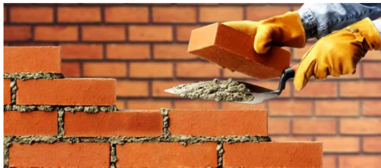
Figura 02. Muro de albañilería simple de ladrillos King Kong Artesanal.
