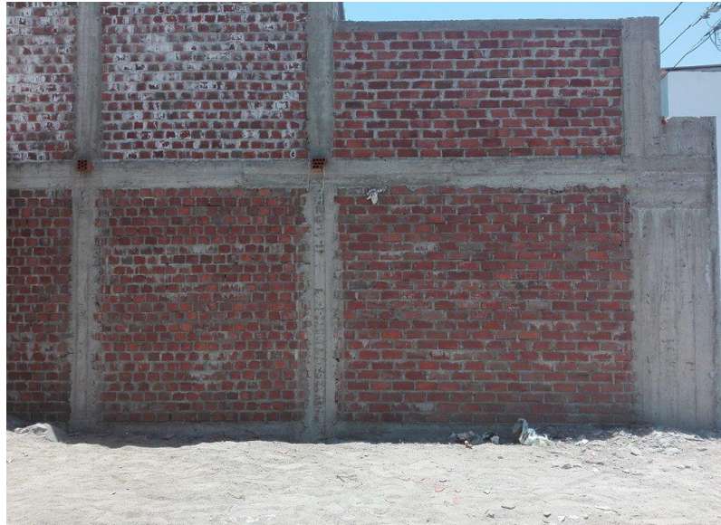
Imagen 02: Columnas de amarre de albañilería confinada.
