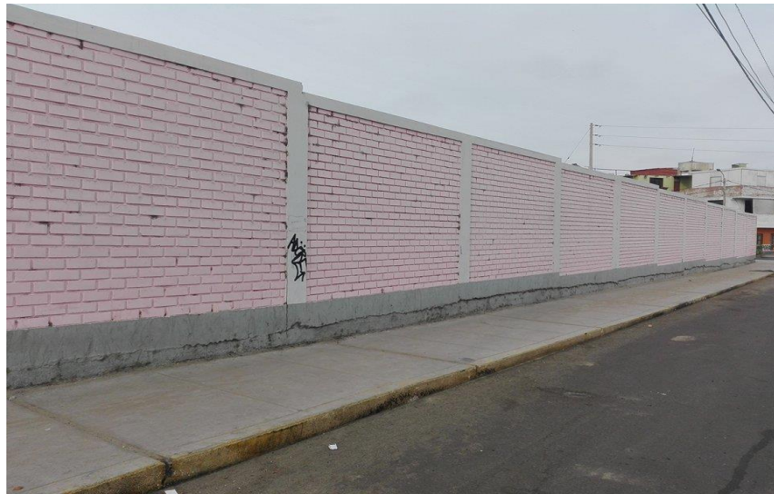
Imagen 10: Vista lateral de un cerco perimétrico de albañilería confinada.
