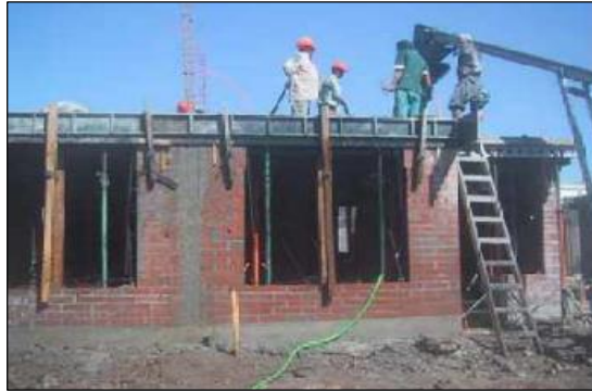
Imagen 3. Albañilería Confinada Nota Fuente: Universidad de Chile (8)
