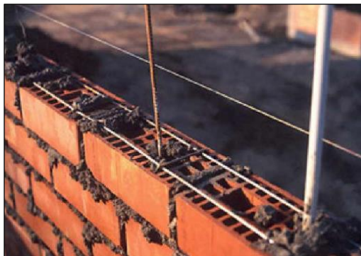
Imagen 4. Albañilería Armada Nota Fuente: Universidad de Chile (8)
