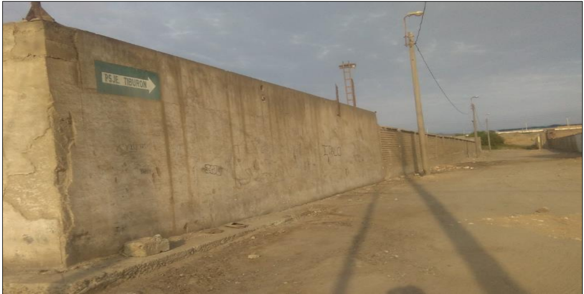
Foto 2: Panorámica del tramo 8 - 15 del cerco perimétrico de la Industria Veinte Veinte S.A.C
