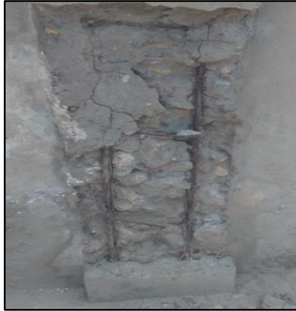
Imagen 27. Corrosión
