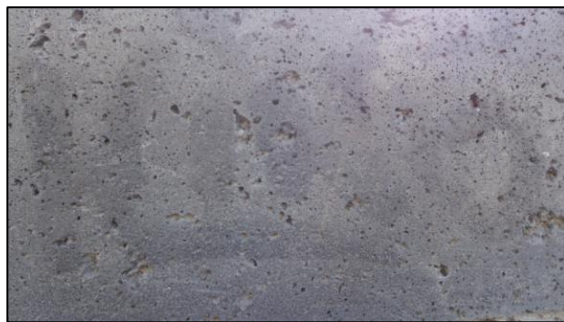
Imagen 18. Concreto Nota. Fuente: Villarino Alberto (16)
