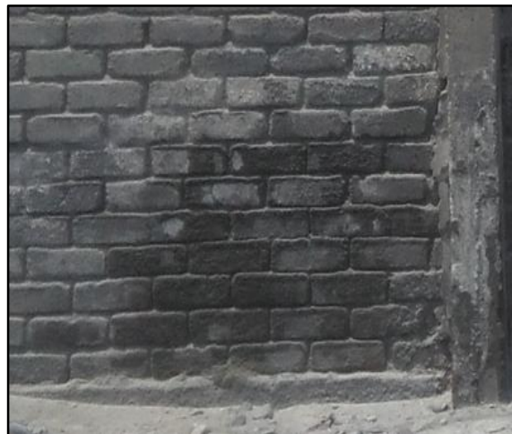
Imagen 28. Eflorescencia Nota. Fuente: Elaboración propia
