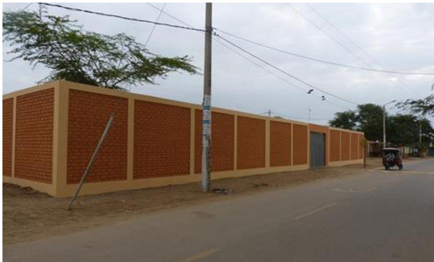
*Figura 20.* Cerco perimétrico de albañilería confinada.
