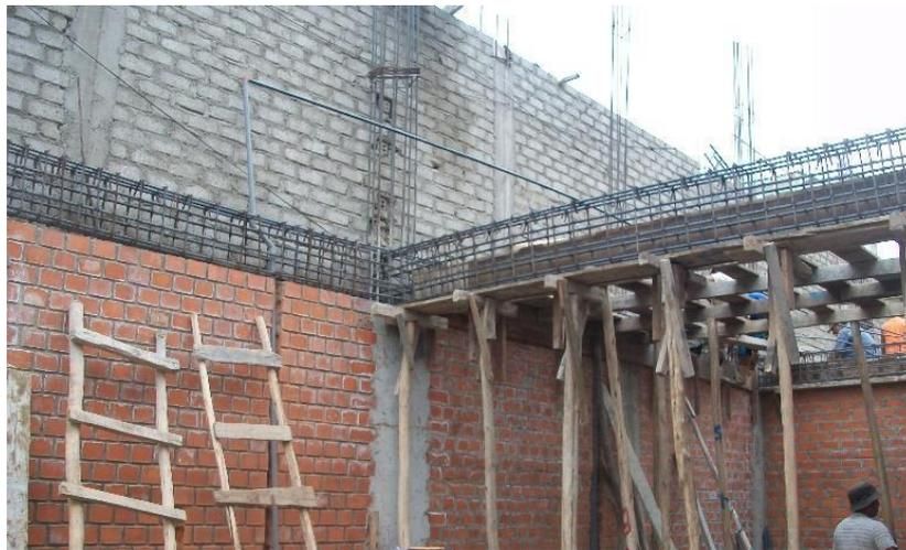
*Figura 6.* Armadura y encofrado de vigas de concreto armado.
