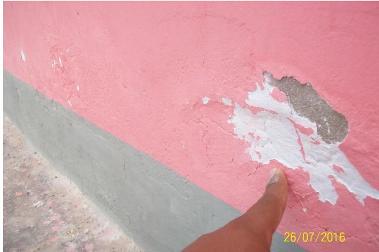
*Figura 12.* Descascaramiento de la pintura de la superficie del muro
