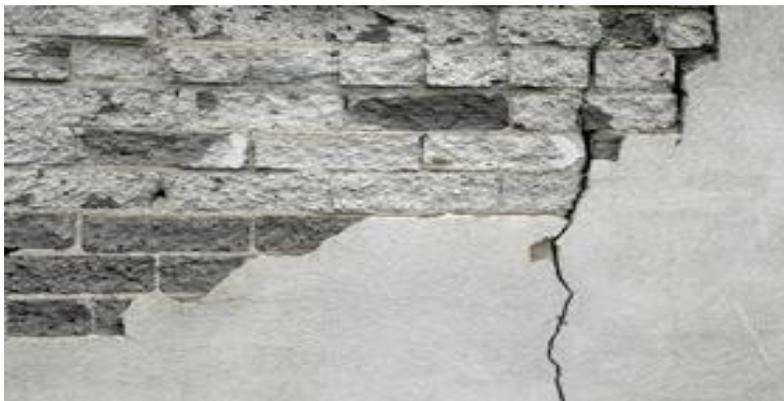
*Figura 13.* Grieta en muro producto de la deformación del apoyo de su cimiento.
