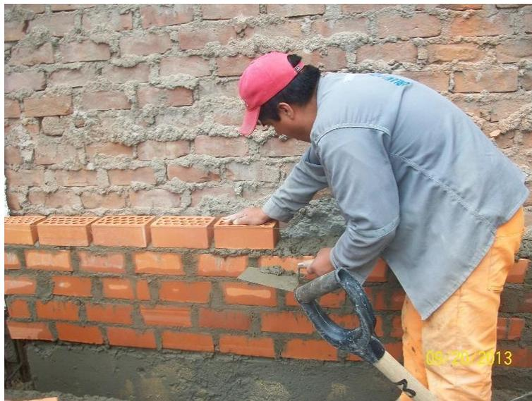
*Figura 9.* Albañil levantando un muro de albañilería de saga con ladrillos de arcilla de 18 huecos.
