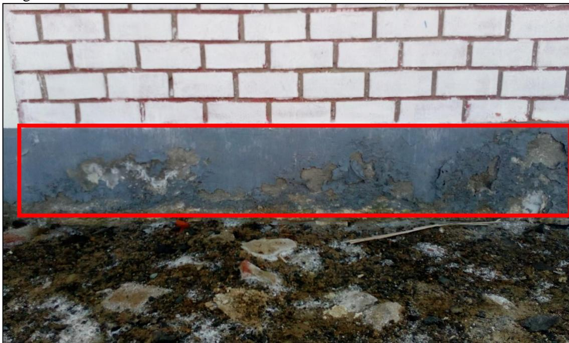
Fotografía 15: Eflorescencia en sobre cimiento del tramo B - C – Unidad Muestral 14
