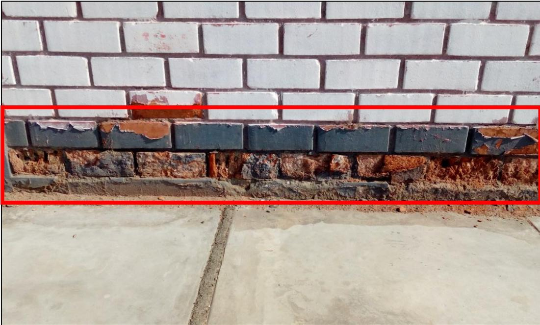
Fotografía 6: Descascaramiento en viga del tramo A -B – Unidad Muestral 4
