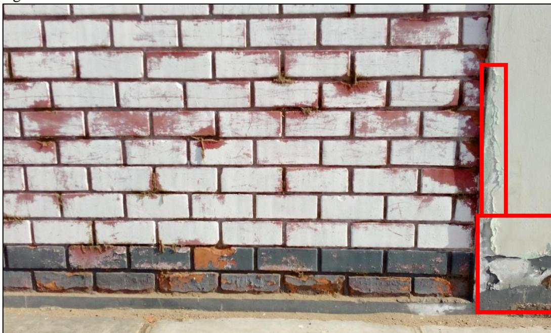
Fotografía 9: Erosión en muro del tramo A -B – Unidad Muestral 9
