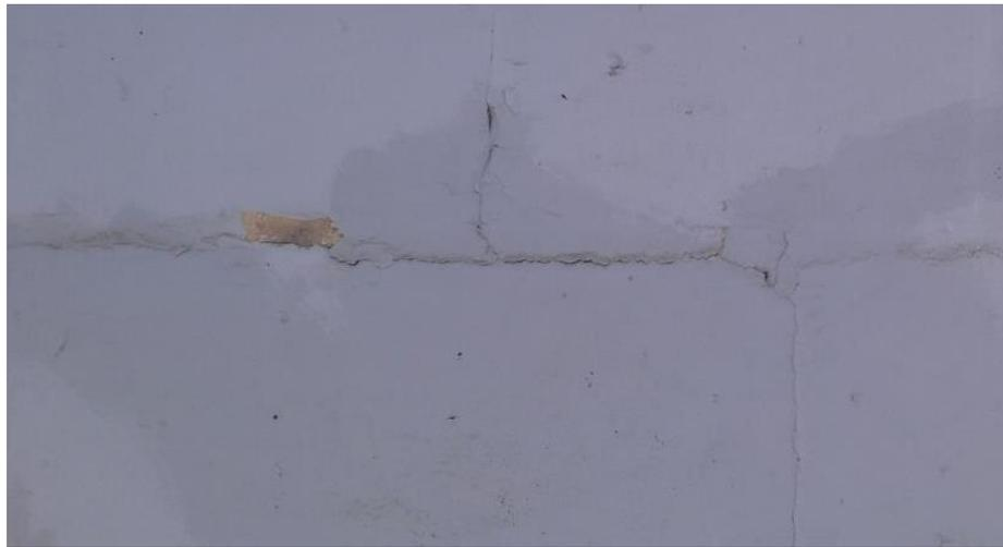
*Figura 14.* Aparición de fisuras sobre el acabado producto de esfuerzos mecánicos.
