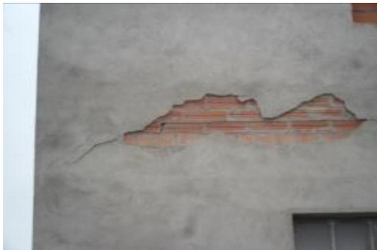
*Figura 15.* Desprendimiento de revoque en muro.
