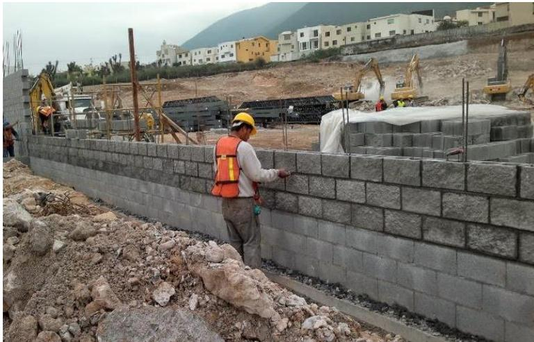
*Figura 3. Construcción de muro con albañilería armada.*
