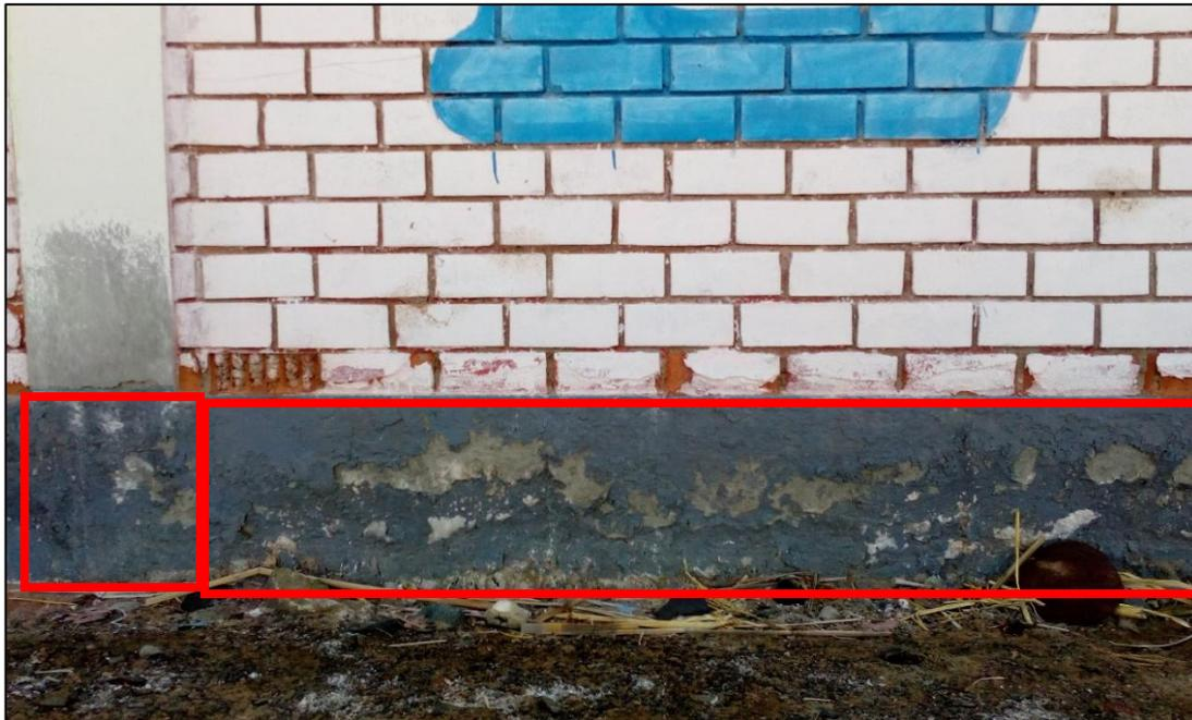
Fotografía 12: Erosión en muro y eflorescencia en sobre cimienta del tramo B - C – Unidad Muestral 11
