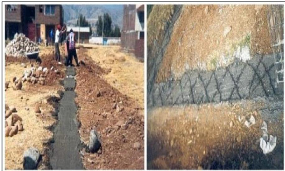
*Figura 8. Cimentación de concreto simple.*
