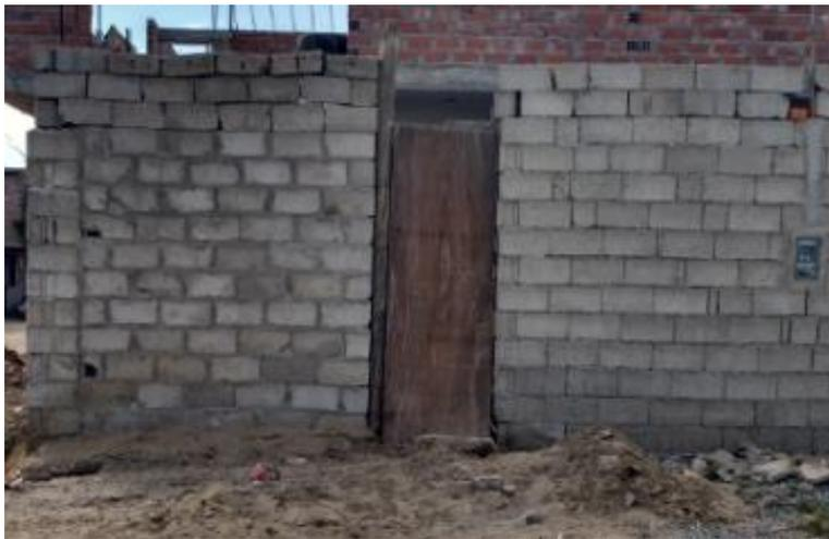
*Figura 2.* Construcción de albañilería simple con bloques de concreto.
