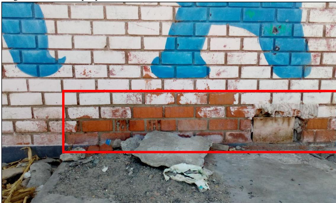
Fotografía 11: Erosión en sobre cimienta y eflorescencia en columna del tramo B - C – Unidad Muestral 10
