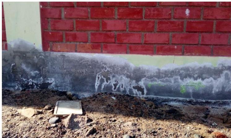
*Figura 17.* Sobrecimiento de muro con presencia de eflorescencia en la parte inferior.
