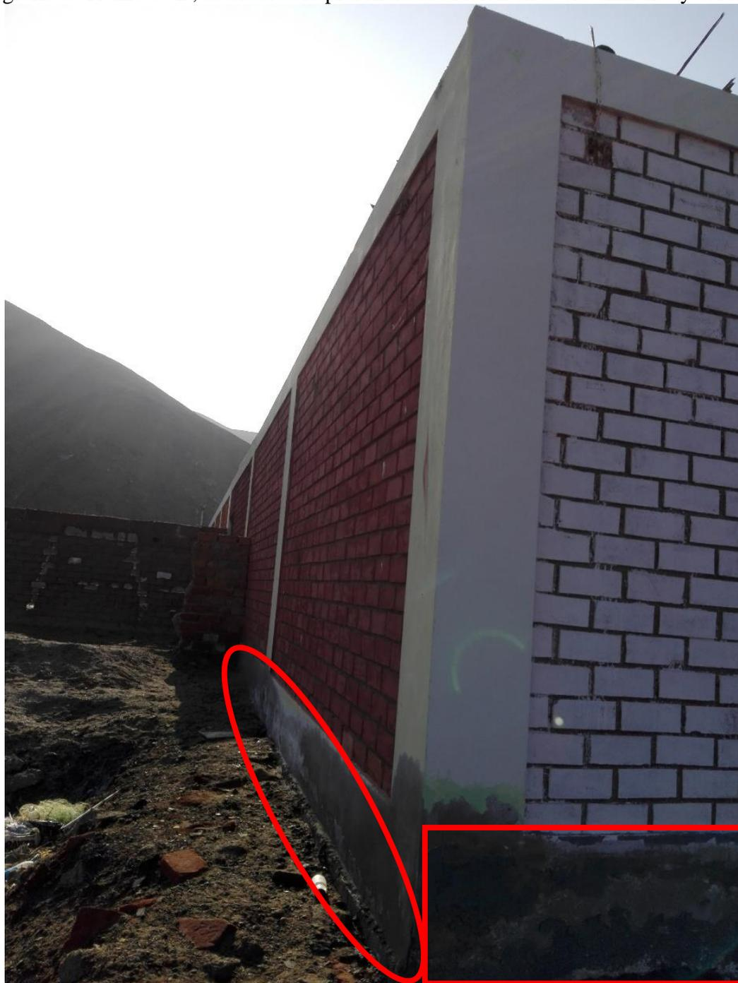
Fotografía 5: Erosión en muro del tramo A -B – Unidad Muestral 1
