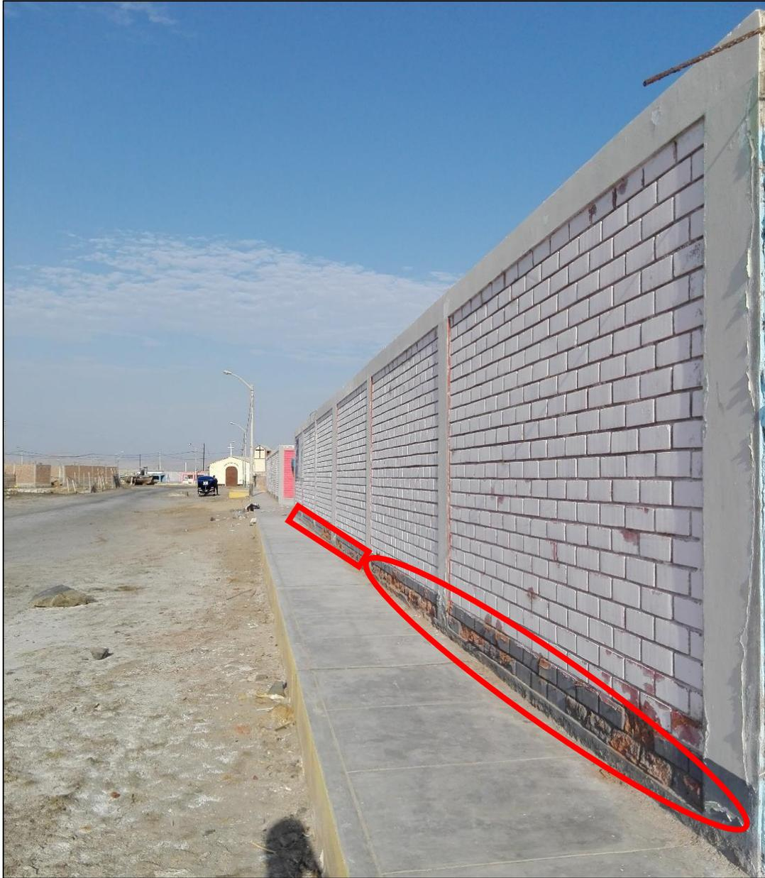
Fotografía 3: Tramo B – C, se observa la presencia de erosión en muro.
