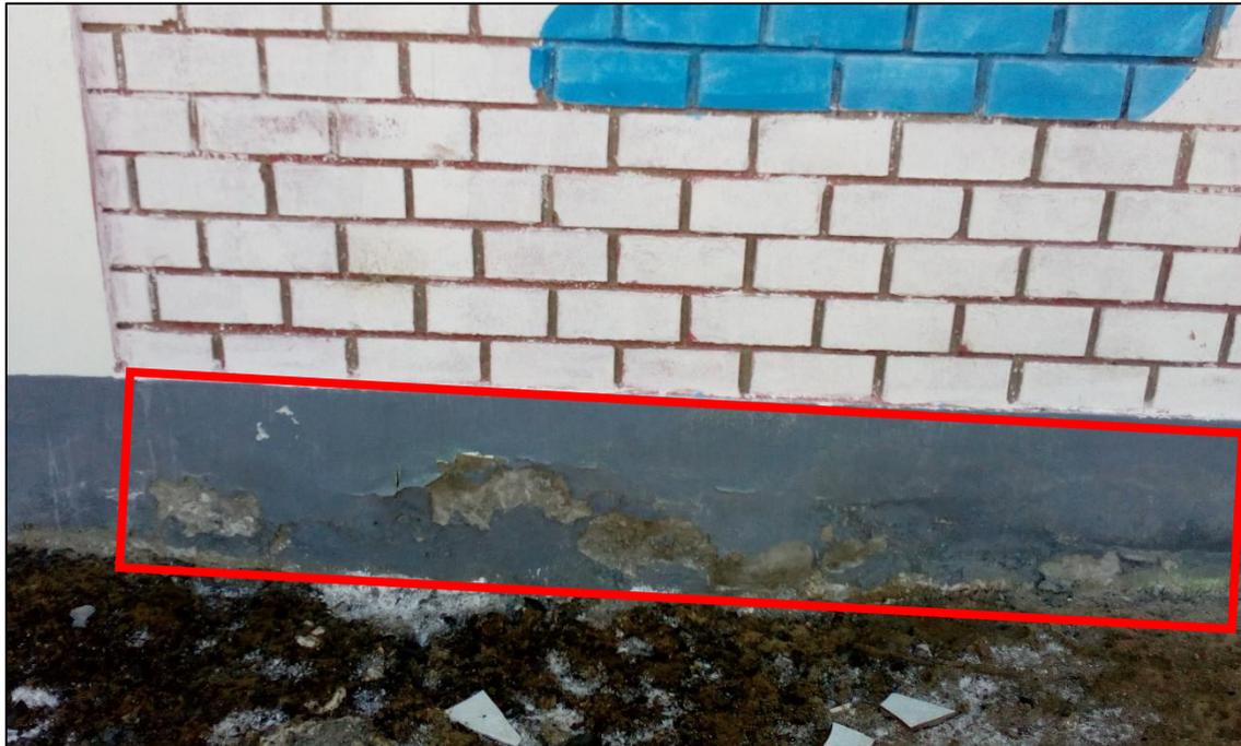
Fotografía 14: Eflorescencia en sobrecimiento del tramo B-C, Unidad Muestral 13
