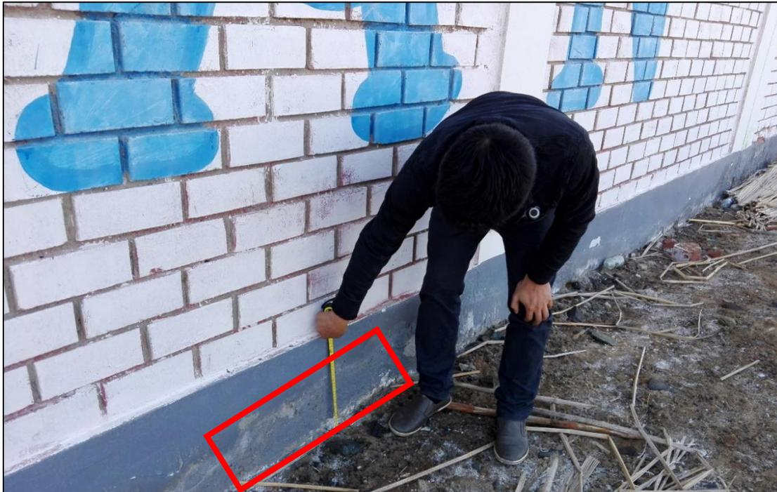
Fotografía 16: Eflorescencia en sobrecimiento del tramo B-C, Unidad Muestral 15
