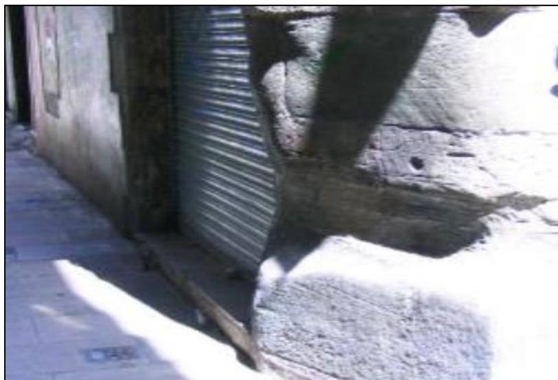
*Figura 16.* Muro con presencia de huecos ocasionados por golpes o impactos.
