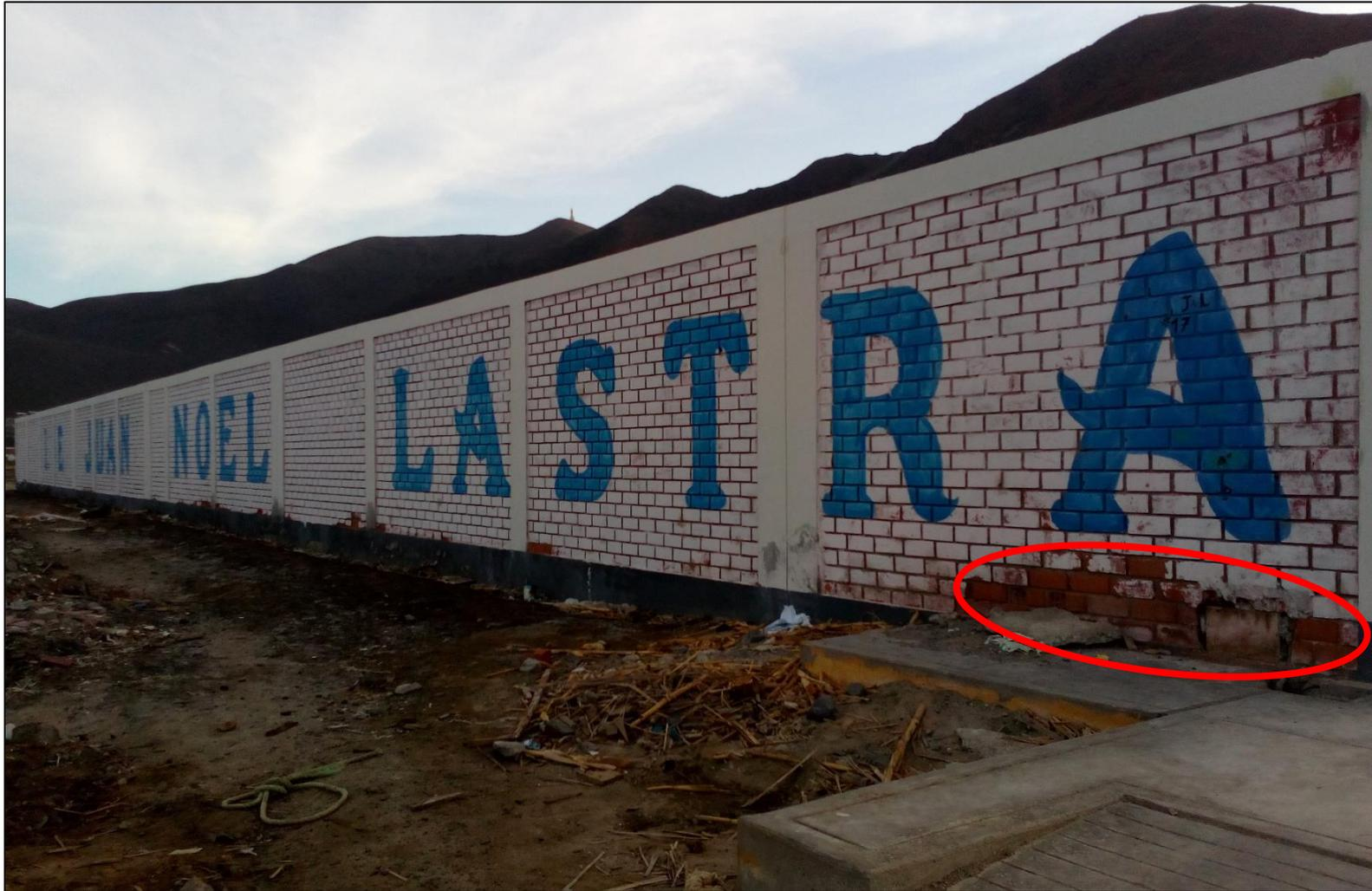
Fotografía 4: Tramo C–D, se observa la presencia de erosión en sobre cimient y columna.
