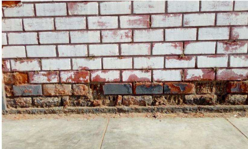
Figura 19. Muro de albañilería afectada por erosión química en la parte inferior producto de un suelo alto en sales y húmedo.
