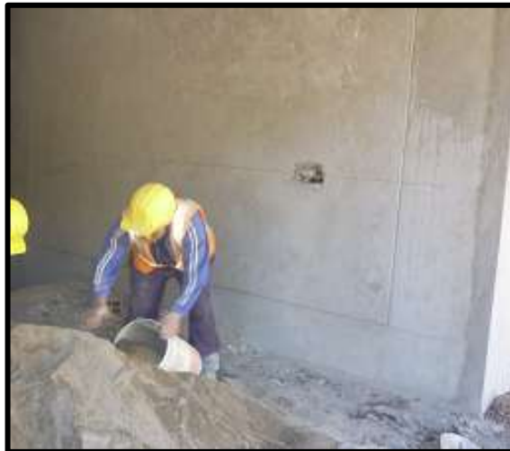
Imagen N°21: Desprendimiento de concreto. Fuente: Elaboración Propia(2017)
