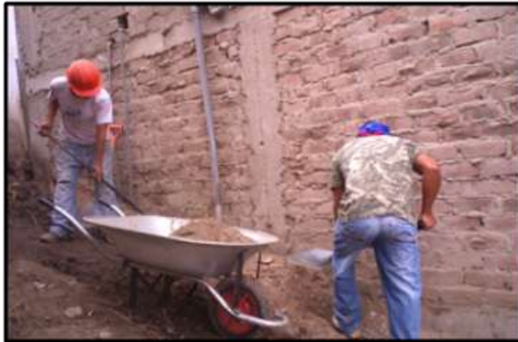
Imagen N°03: Anomalías en Acabados.
