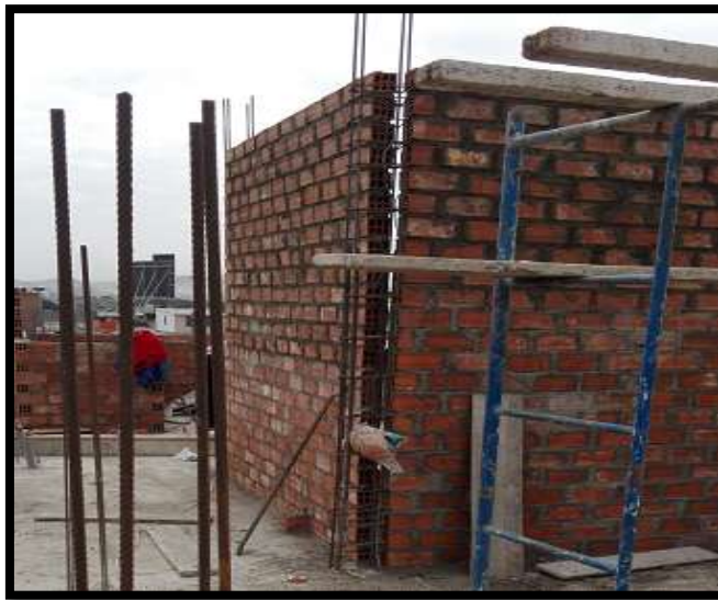
Imagen N°07: Muros de Albañilería Confinada. Fuente: Elaboración Propia(2017)
