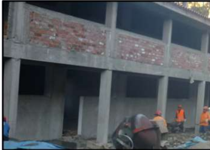
Imagen N°14: Estructura - Vigas de Concreto Armado. Fuente: Elaboracion Propia(2017)
