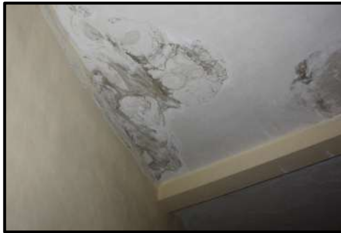
Imagen N°19 Presencia de Eflorescencia (sales) en concreto y muros de albañilería.
