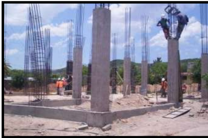
Imagen N°12: Estructura - Columnas de Concreto Armado. Fuente: Elaboración Propia(2017)
