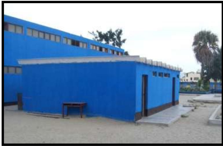
Imagen N°02: Renovación de Acabados. Fuente: Elaboración Propia(2017)
