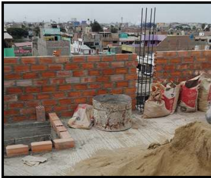
Imagen N°06: Albañilería Confinada. Fuente: Elaboración Propia(2017)
