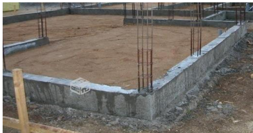
Figura 9. Sobrecimiento Nota. Fuente: (Avalos A. 2015) 15
