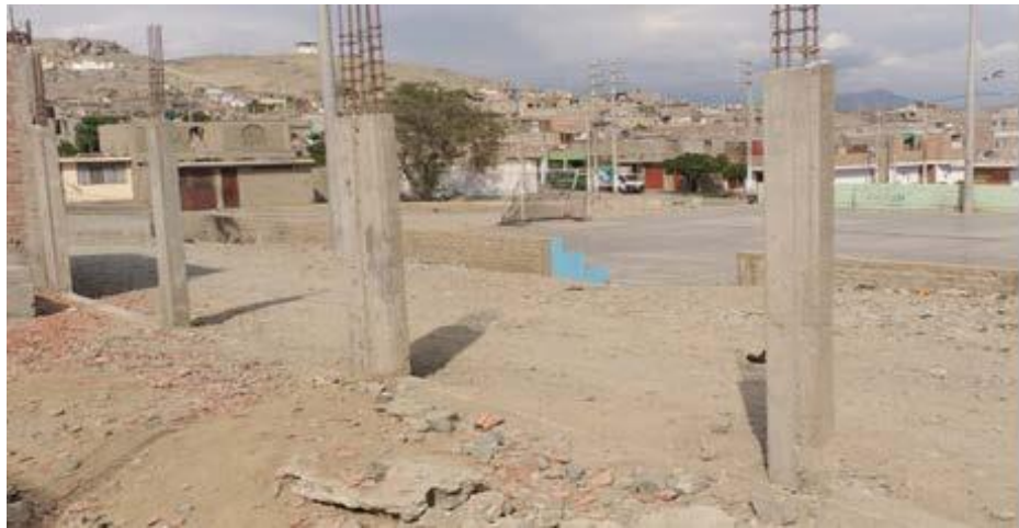
Figura 7. Columna de Concreto Armado
