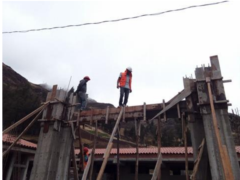
Figura 04: encofrado de viga.
