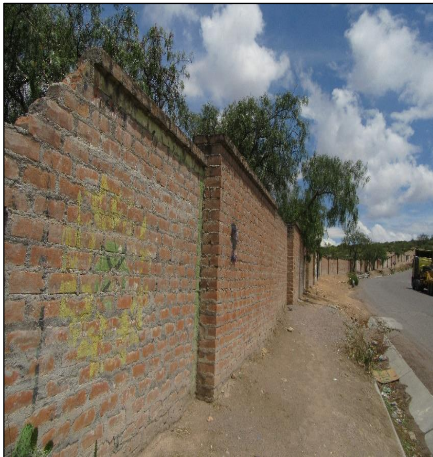
LADO IZQUIERDO PARTE DE ATRÁS DEL CERCO PERIMÉTRICO
