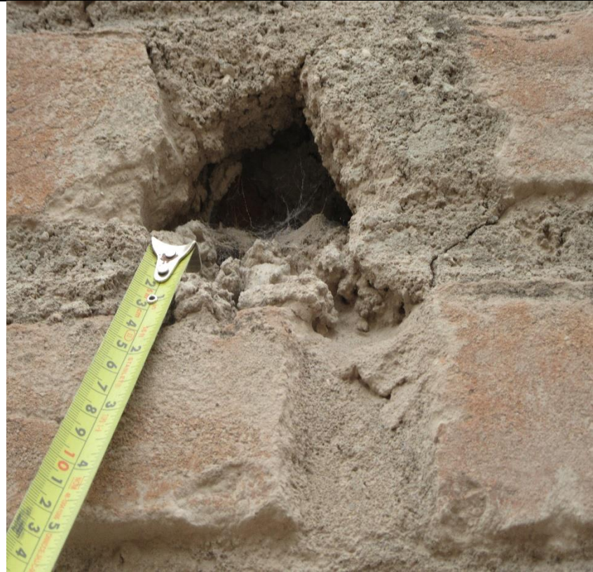
Fotografía 07: Picadura en muro del cerco perimétrico del depósito de vehículos de la universidad Nacional de San Cristóbal de Huamanga. En la unidad de muestra 09.
