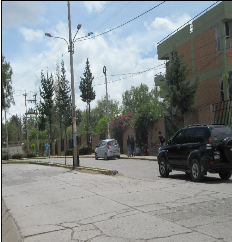
LADO IZQUIERDO DEL CERCO PERIMÉTRICO
