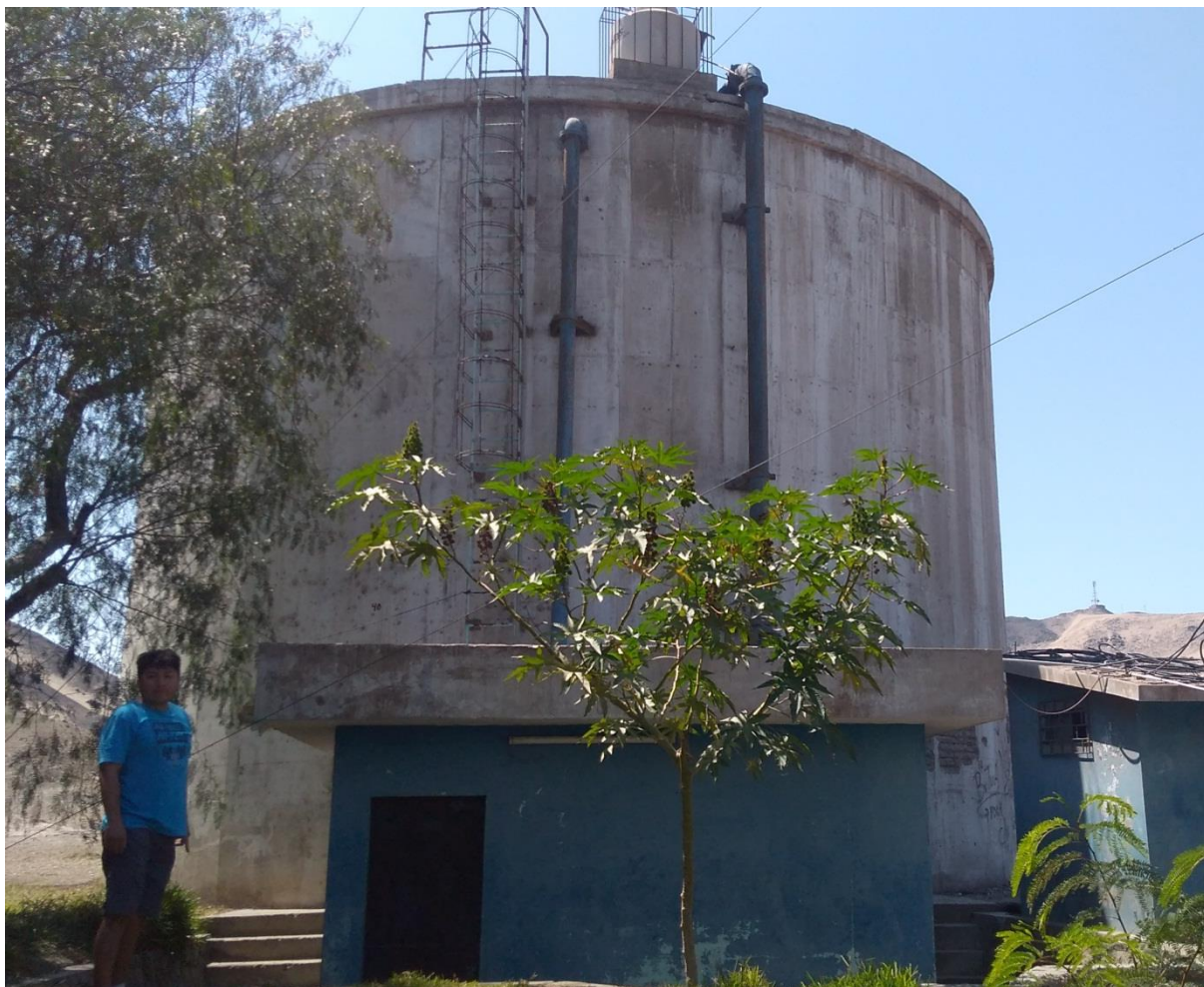
Fotografía 2: Vista frontal del reservorio apoyado R1, del distrito de Coishco, provincia de Santa, departamento de Ancash.
