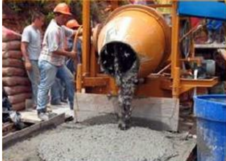
Figura 1. Preparación del concreto Nota. Fuente: Hernández. (2010)
