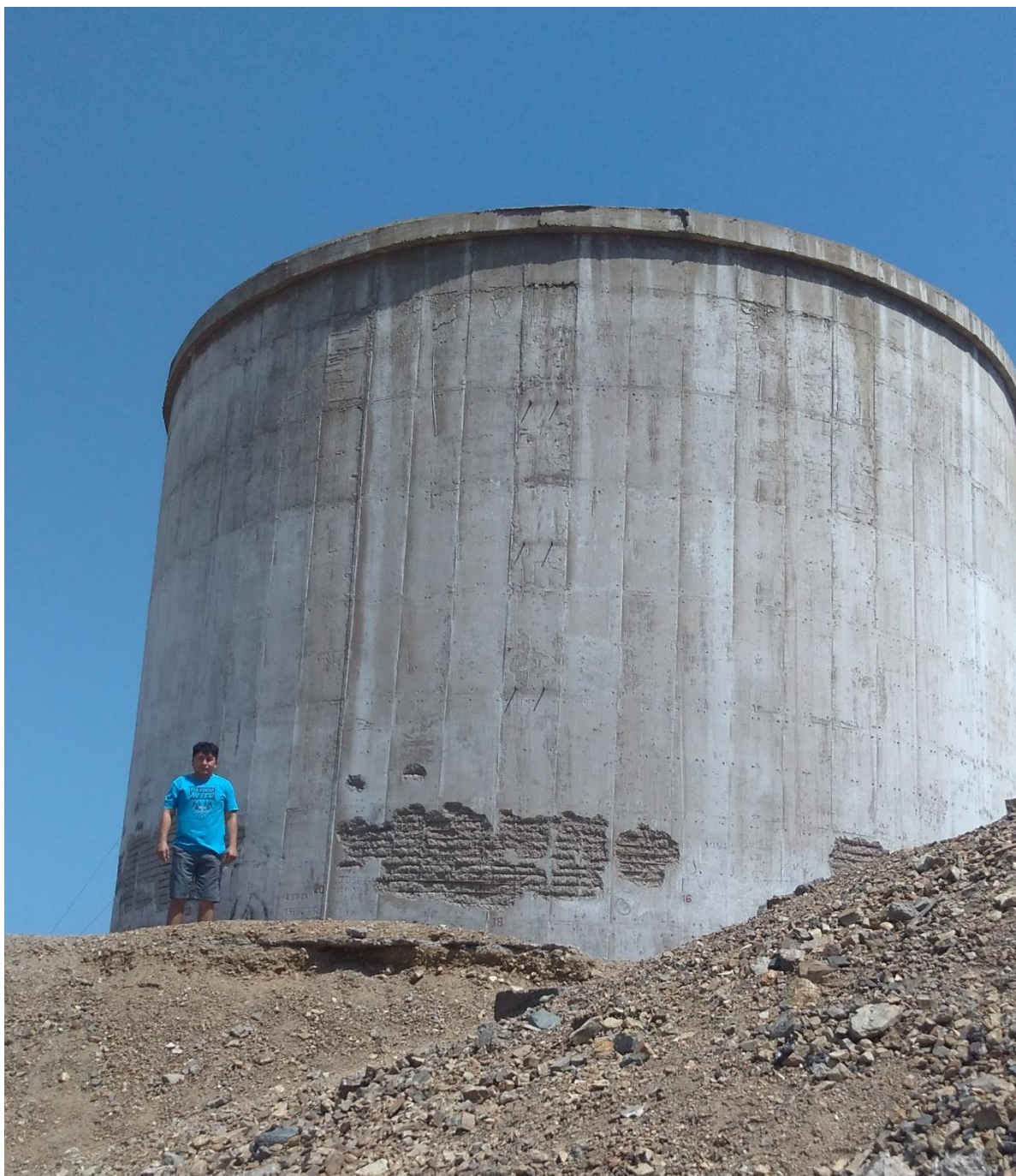
Fotografía 5: Vista posterior del reservorio apoyado R1, del distrito de Coishco, provincia de Santa, departamento de Ancash.
