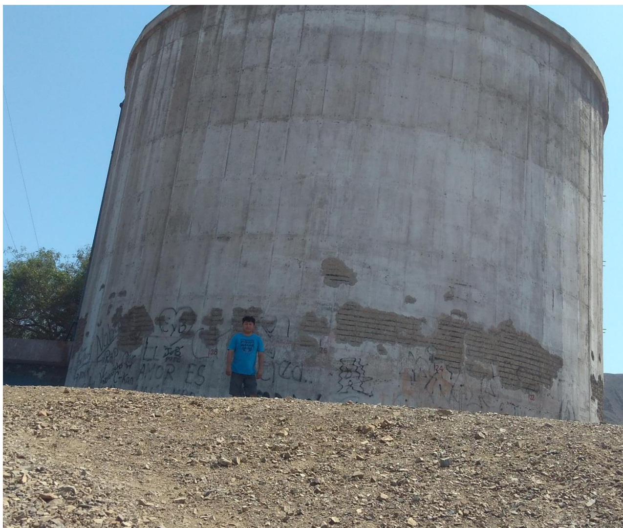
Fotografía 4: Vista lateral derecho del reservorio apoyado R1, del distrito de Coishco, provincia de Santa, departamento de Ancash.
