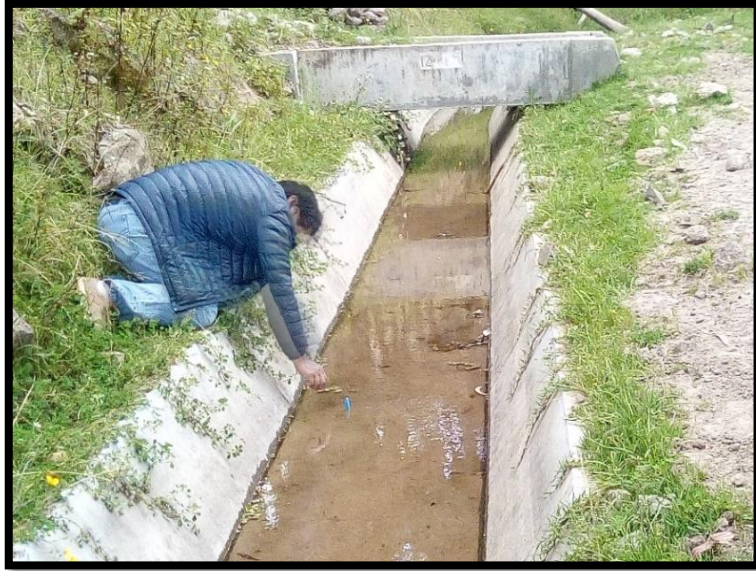
Imagen n° 05 y 06: Identificación de la patología sedimentación en el fondo del canal. Por escaso pendiente y partículas pesadas.
