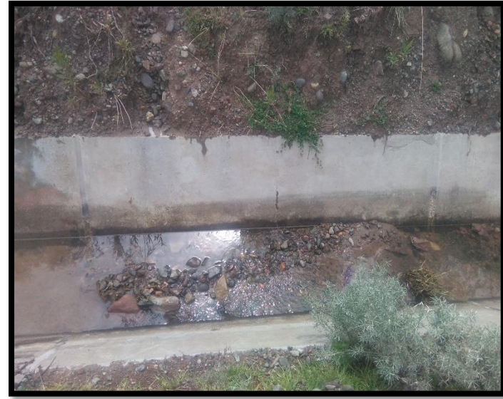
Imagen n° 05 y 06: Identificación de la patología sedimentación en el fondo del canal. Por escaso pendiente y partículas pesadas.
