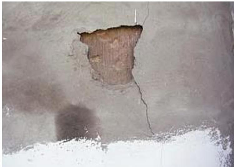
Figura 14: Desprendimiento en muro.
