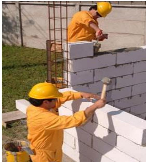
Figura 04. Asentado de ladrillo de la estructura de albañilería confinada
